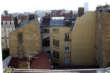
Elévations latérale et postérieure Phot. Bernard Ducouret IVR82_20046905301NUCA
