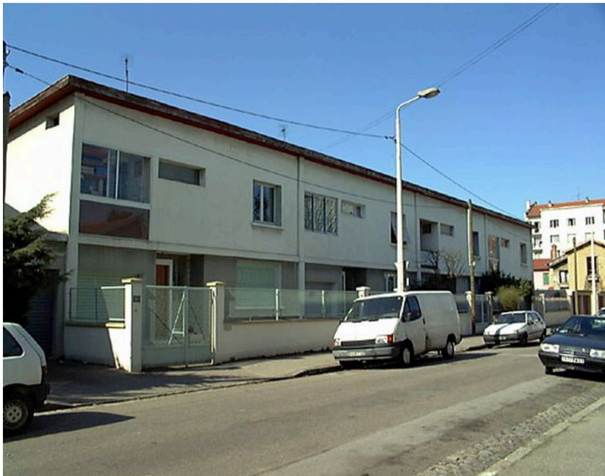
Vue générale des façades sur rue
