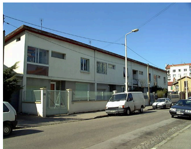
Vue générale des façades sur rue Phot. Bernard Ducouret IVR82_20016900869NUCA
