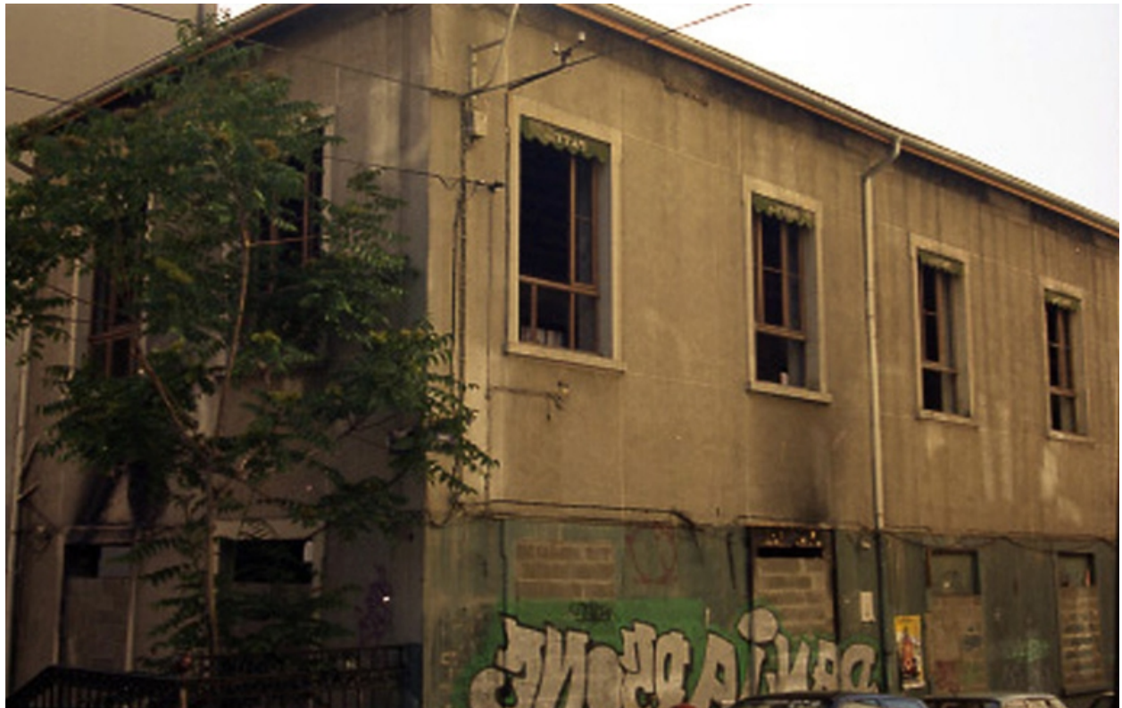
Façade angle nord-est
