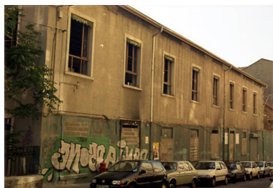
Vue d'ensemble façade principale ouest Phot. Nadine Halitim-Dubois IVR82_19996900886ZA
