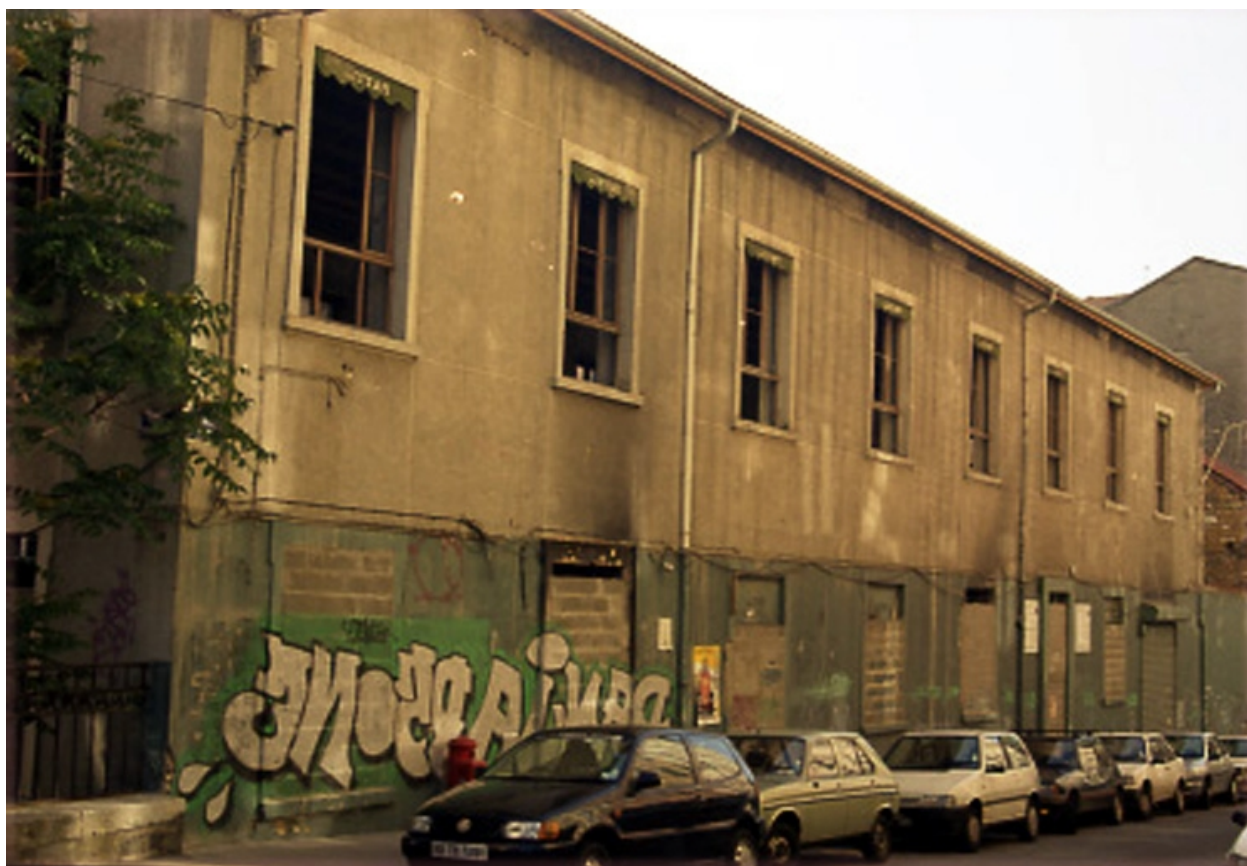
Vue d'ensemble façade principale ouest
