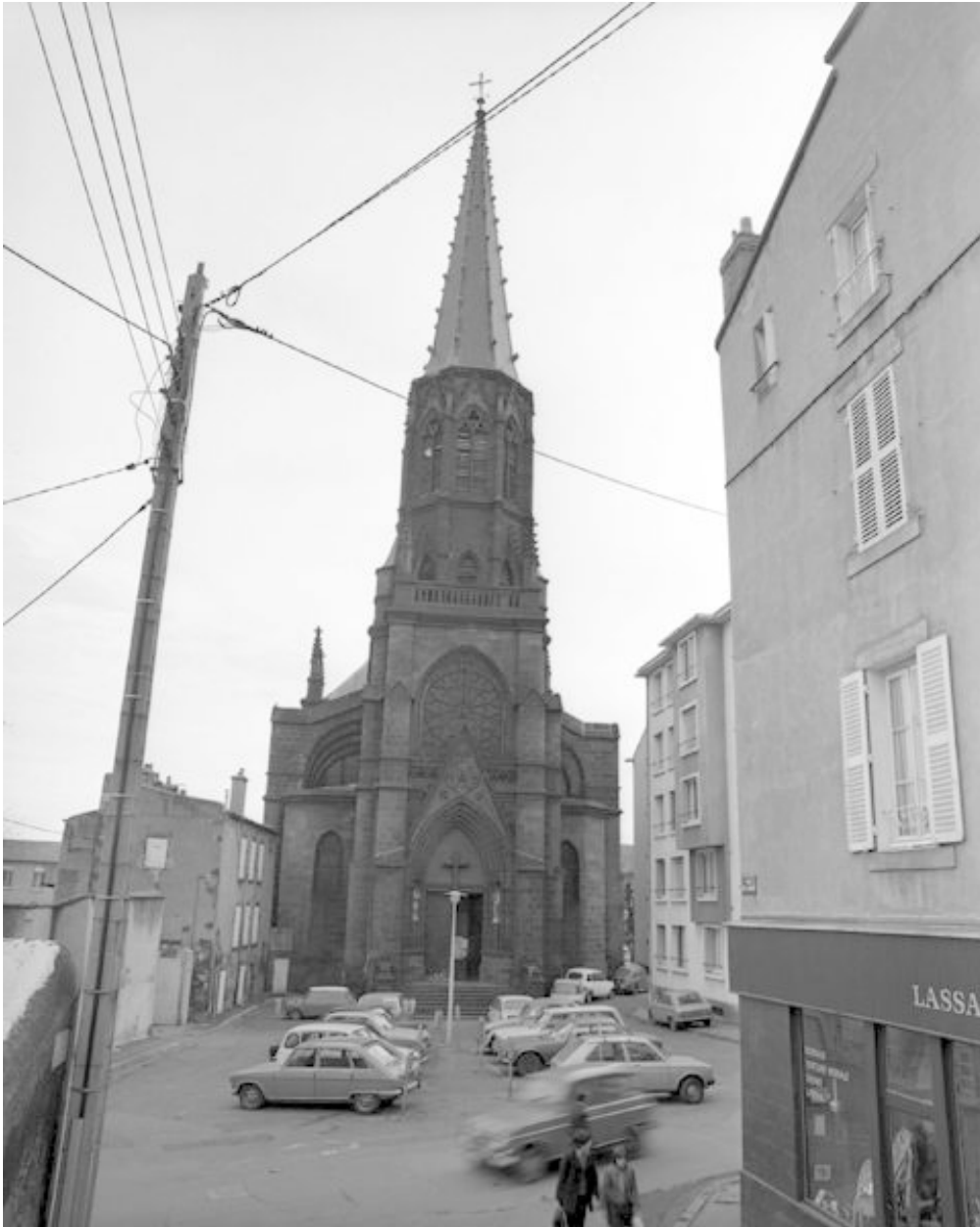
Vue de la façade occidentale
