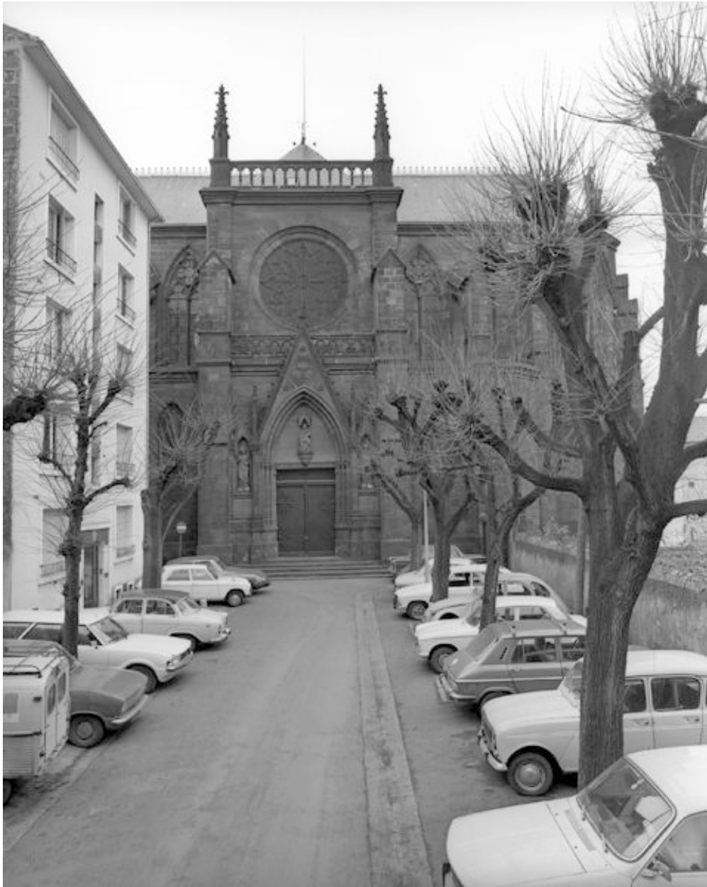
Vue d'une façade latérale
