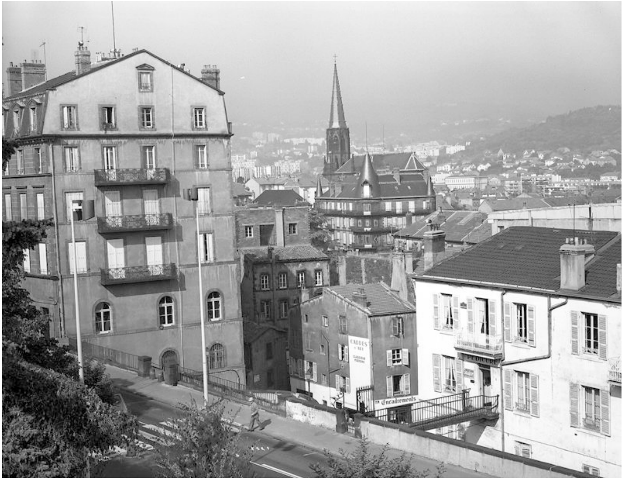
Vue de l'église prise du boulevard Montlosier
