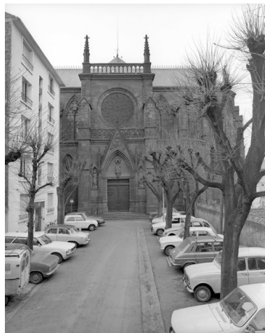
Vue d'une façade latérale IVR83_19786300497X
