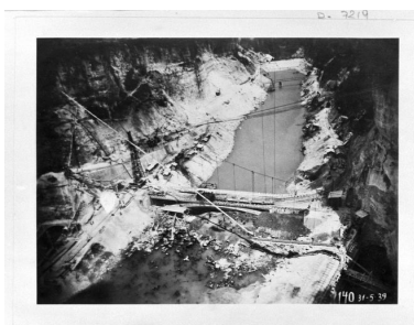
Génissiat, construction du barrage. Mai-juin 1939 / [1939]. 1 fotogr. : n. et b. (BnF - Estampes : Va 1, t. 4, Microfilms H. 106440). Passerelle en arrière-plan Phot. BNF, Autr. auteur inconnu IVR82_20100100030NUCAB
