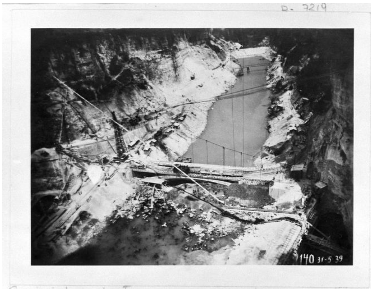
Génissiat, construction du barrage. Mai-juin 1939 / [1939]. 1 fotogr. : n. et b. (BnF - Estampes : Va 1, t. 4, Microfilms H. 106440). Passerelle en arrière-plan
