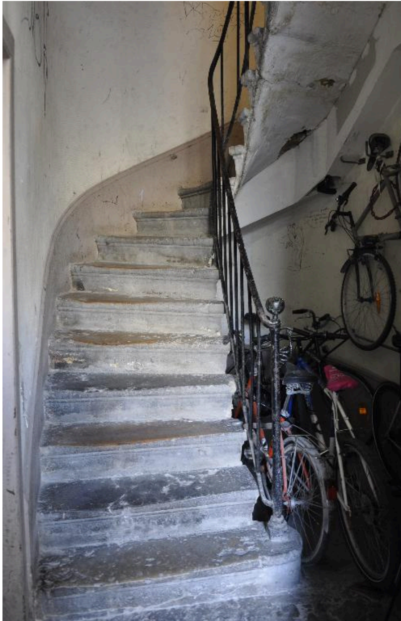
Vue intérieure : départ de l'escalier
