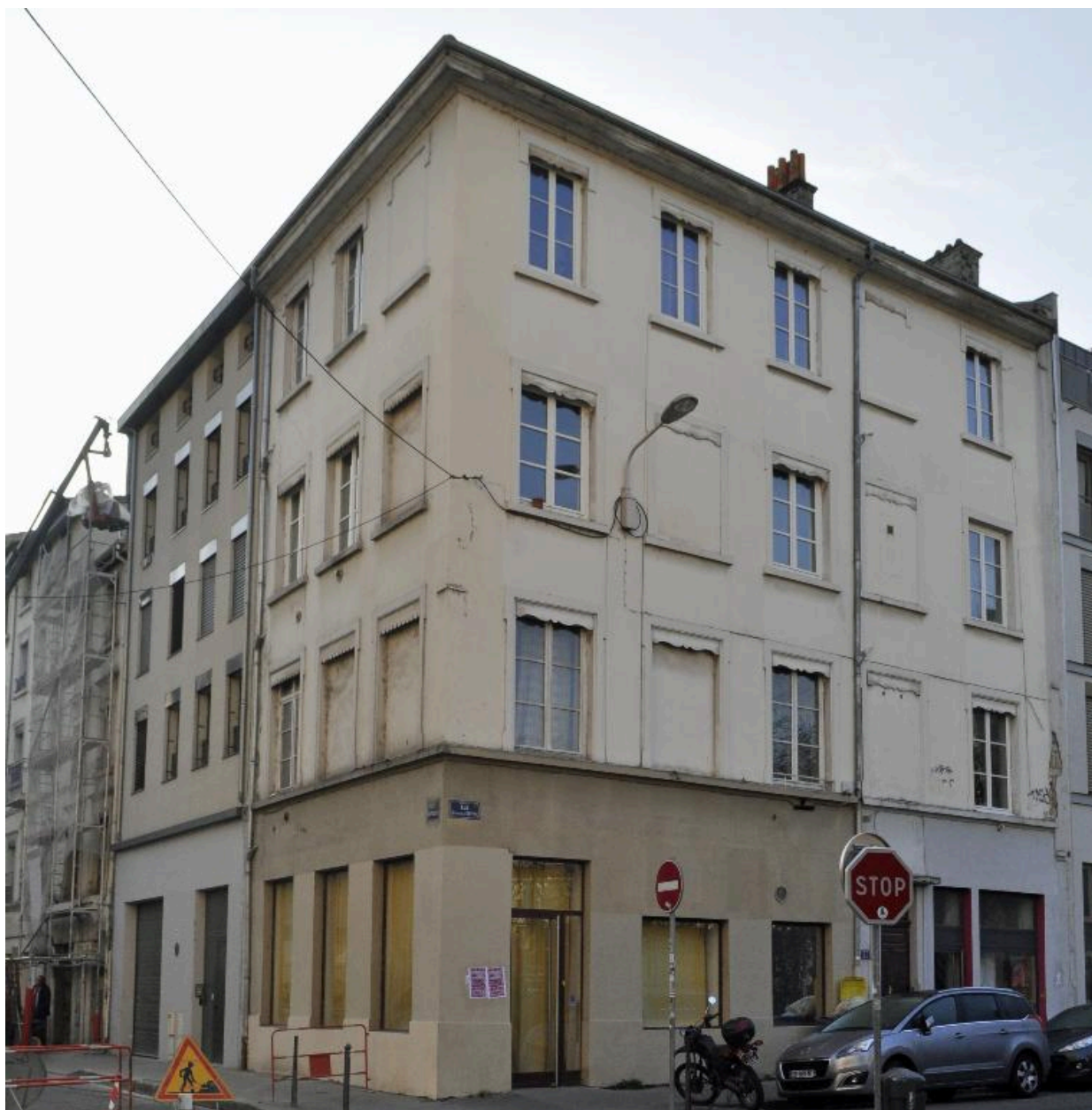
Vue générale depuis la rue Sébastien-Gryphe
