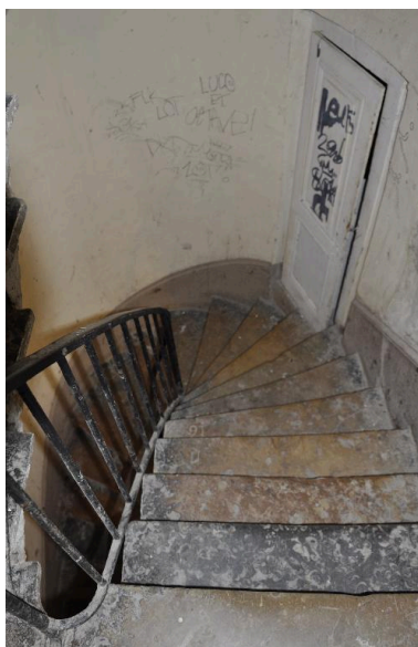
Vue intérieure : escalier, porte de loge (?) Phot. Magali Delavenne IVR84_20166902226NUCA
