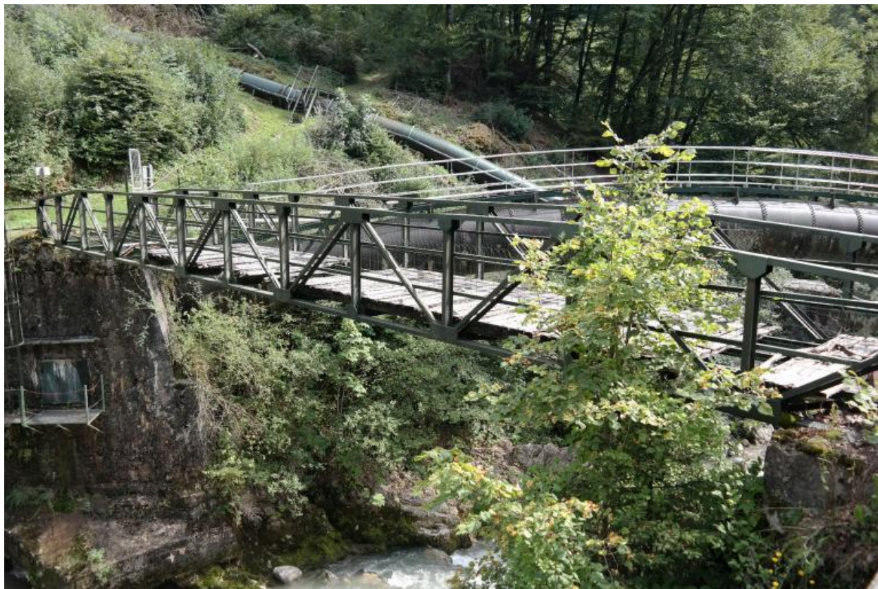
Passerelle EDF de Bioge, vue de la face amont
