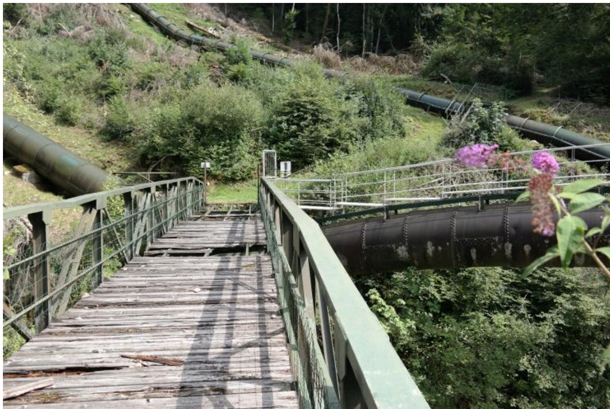
Passerelle EDF de Bioge, connexion des deux passerelles
