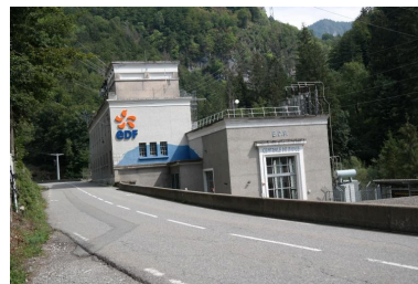
Centrale électrique de Bioge Phot. Pascale Renard IVR84_20207401411NUCA
