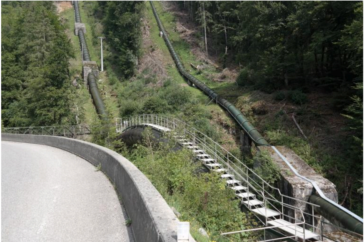
Passerelle sur conduite forcée à la centrale électrique de Bioge
