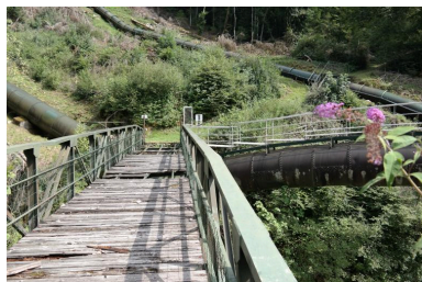
Passerelle EDF de Bioge, connexion des deux passerelles Phot. Pascale Renard IVR84_20207401409NUCA
