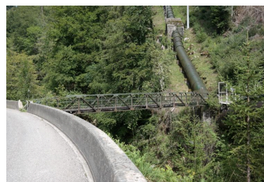
Passerelle EDF de Bioge, vue de la face aval Phot. Pascale Renard IVR84_20197401221NUCA
