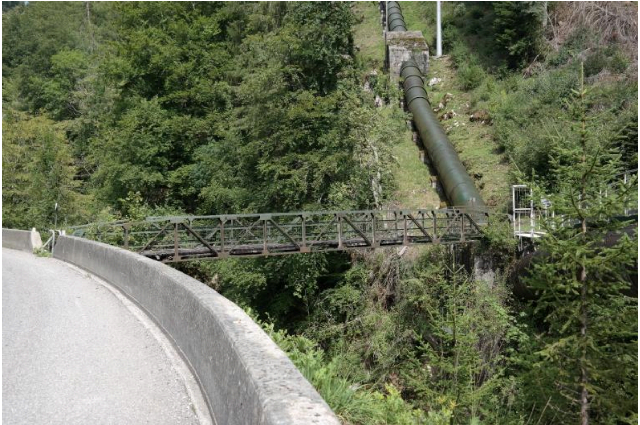
Passerelle EDF de Bioge, vue de la face aval
