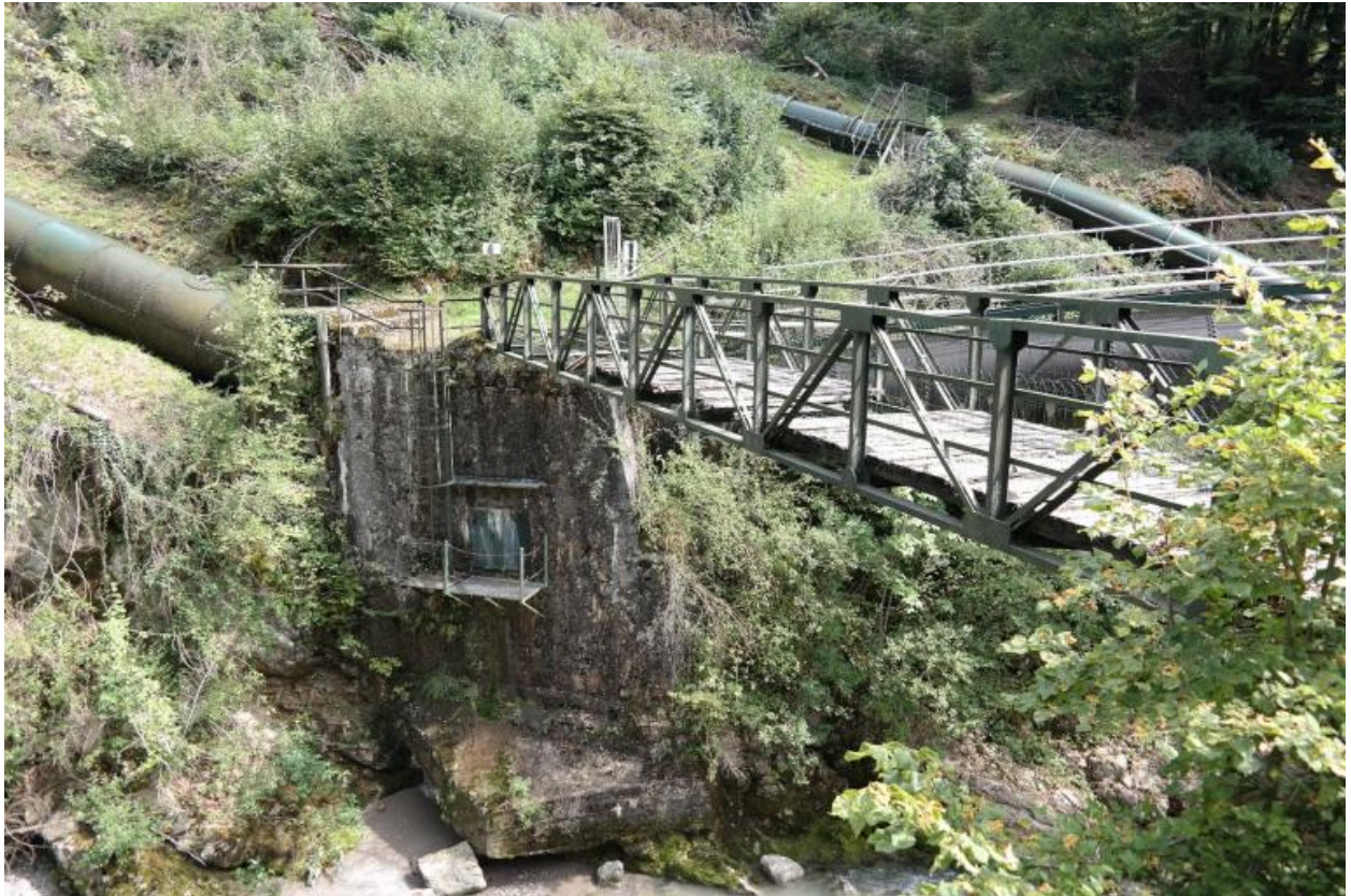
Passerelle EDF de Bioge, vue de l'extrémité rive gauche
