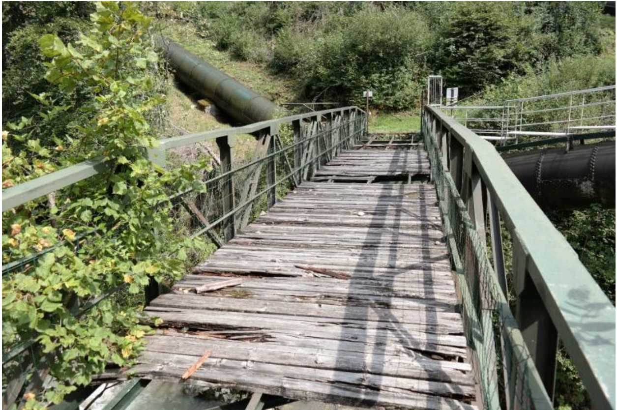
Passerelle EDF de Bioge, vue du tablier
