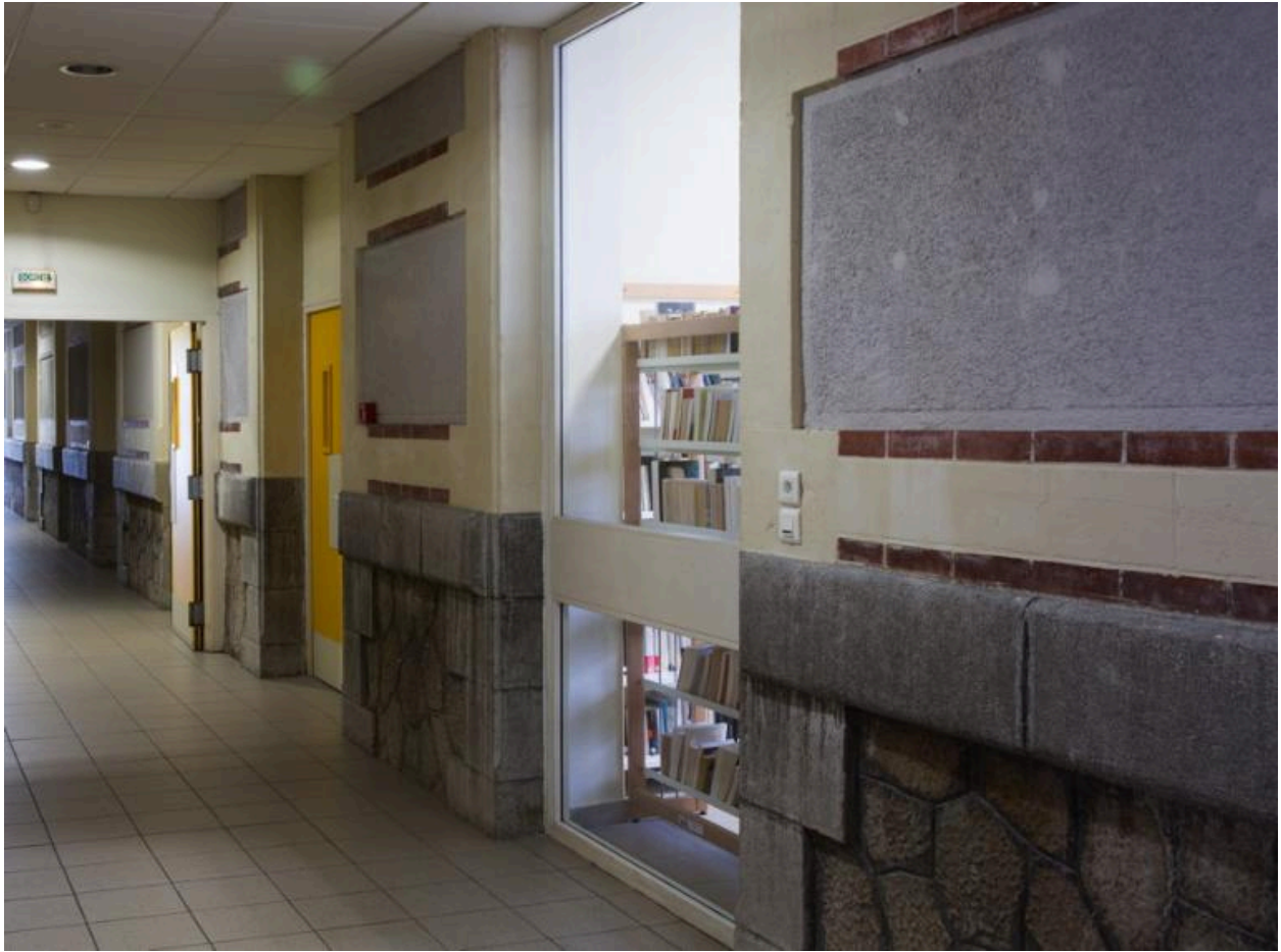
Bâtiment nord : ancienne façade sud sur cour emprise dans le C.D.I.
