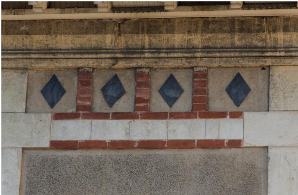
Bâtiment nord : façade nord : détail de la frise, surélévation de 1909
