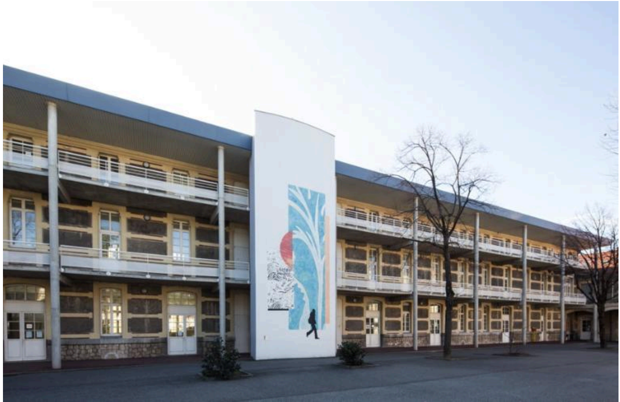
Bâtiment sud : façade nord : vue générale, au centre cage de l'ascenseur et 1% artistique.
