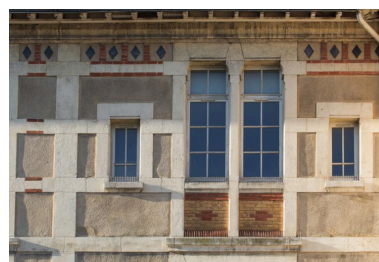
Bâtiment nord : façade nord : détail d'une baie, surélévation de 1909 Phot. Pascal Lemaître IVR82_20152600073NUCA
