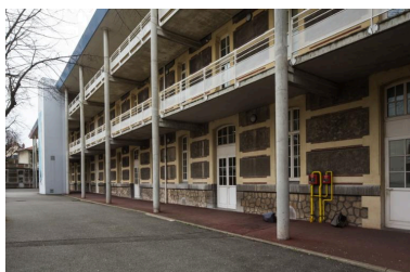
Bâtiment sud : façade nord : étagement des galeries Phot. Pascal Lemaître IVR82_20152600081NUCA
