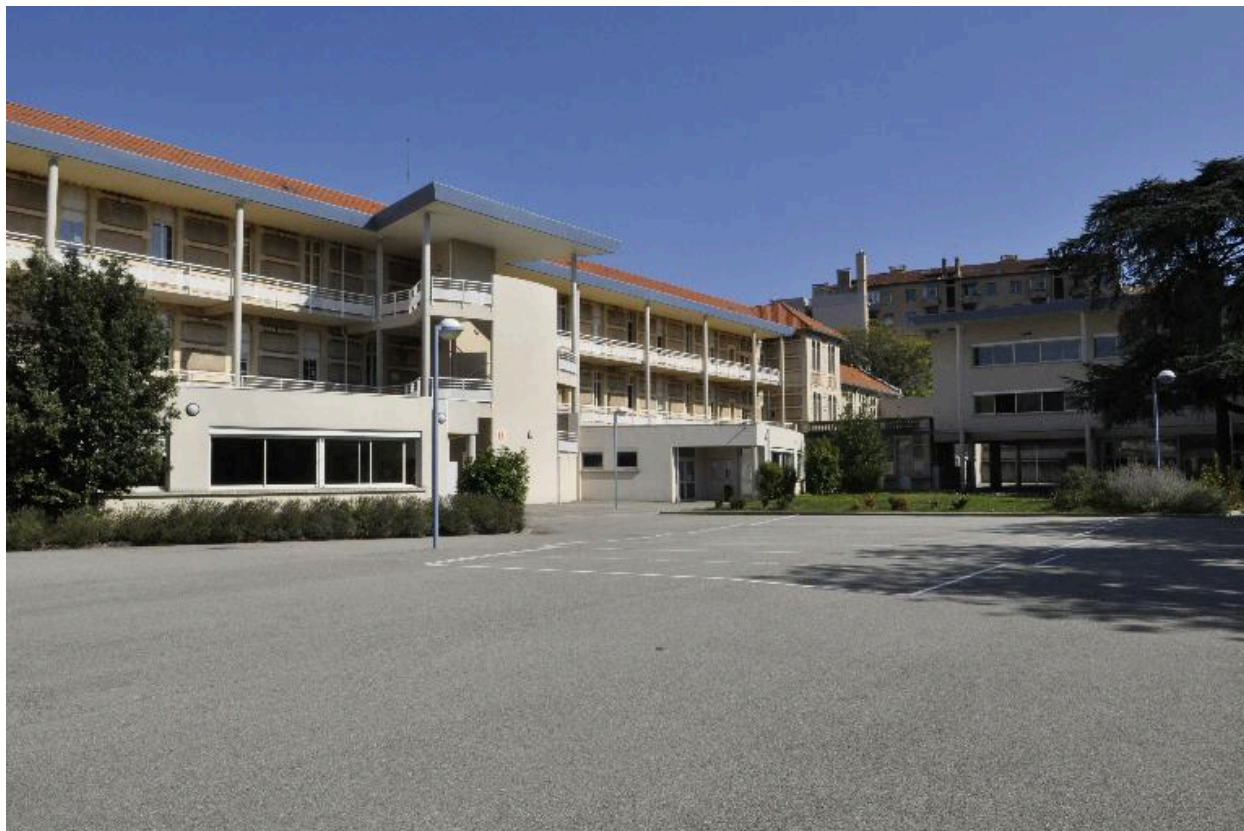
Bâtiment nord : façade sud, partie est
