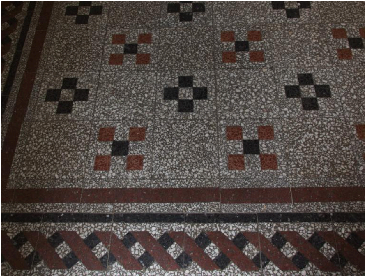
Bâtiment nord : escalier principal, pavement
