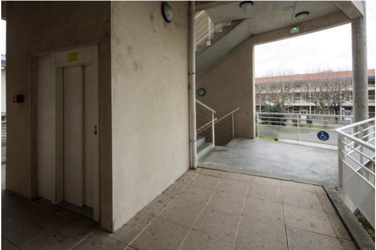
Bâtiment nord : avant-corps central, ascenseur et escalier
