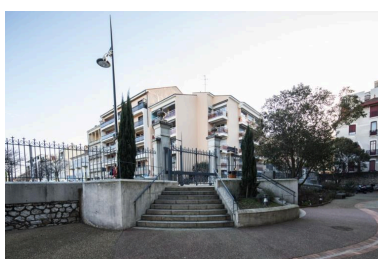
Bâtiment nord : perron et rampe d'accès depuis le Champ de Mars face à l'entrée des élèves Phot. Pascal Lemaître IVR82_20152600071NUCA
