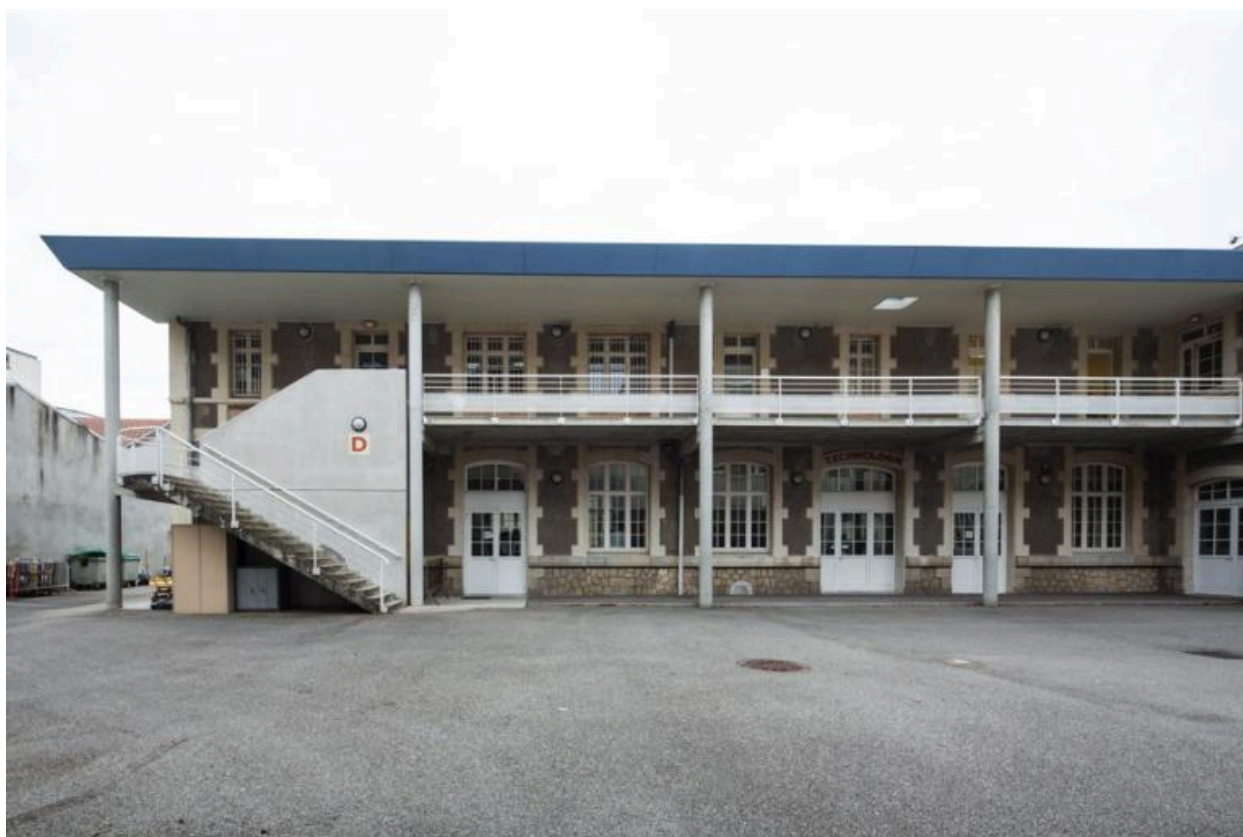
Bâtiment sud : façade nord : aile est.
