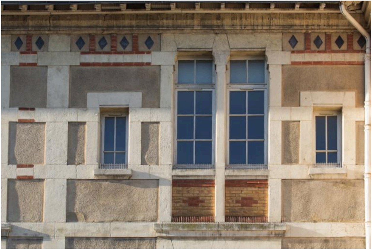
Bâtiment nord : façade nord : détail d'une baie, surélévation de 1909
