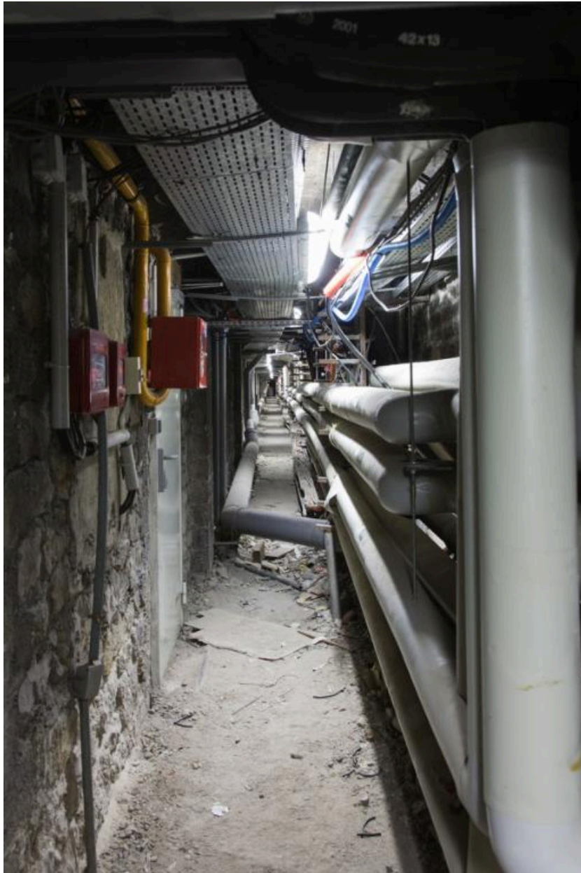
Sous-sol : galerie courant sous les bâtiments nord et sud.
