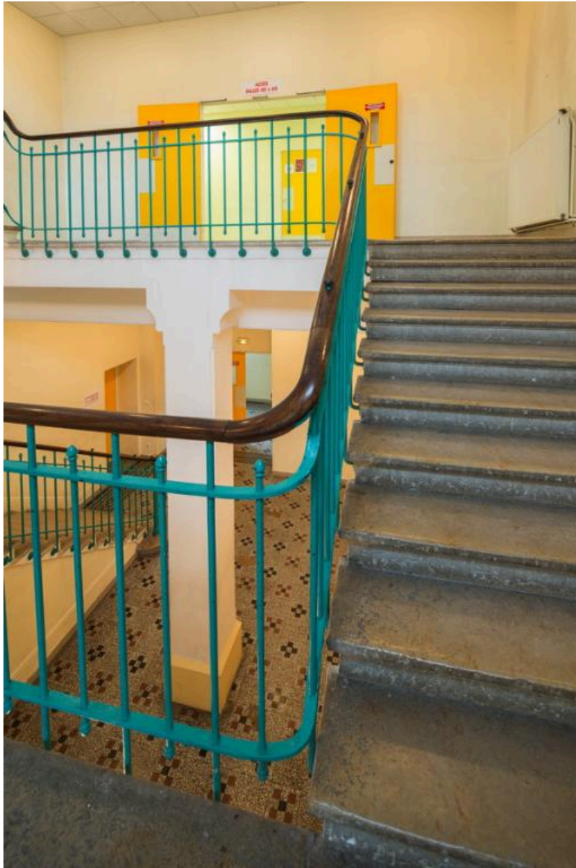
Bâtiment nord : escalier principal, 1ère révolution depuis le 1er repos
