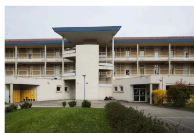
Bâtiment nord : façade sud, avant-corps de l'escalier et ascenseur desservant les coursiers Phot. Pascal Lemaître IVR82_20152600075NUCA
