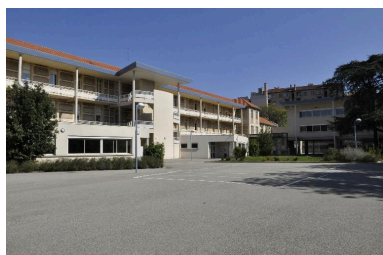
Bâtiment nord : façade sud, partie est Phot. Catherine Guégan IVR84_20162600002NUCA
