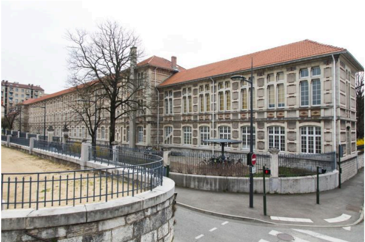
Bâtiment nord : façade nord
