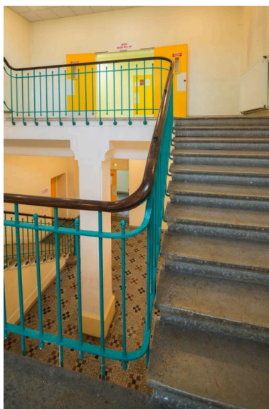
Bâtiment nord : escalier principal, 1ère révolution depuis le 1er repos Phot. Pascal Lemaître IVR82_20152600112NUCA
