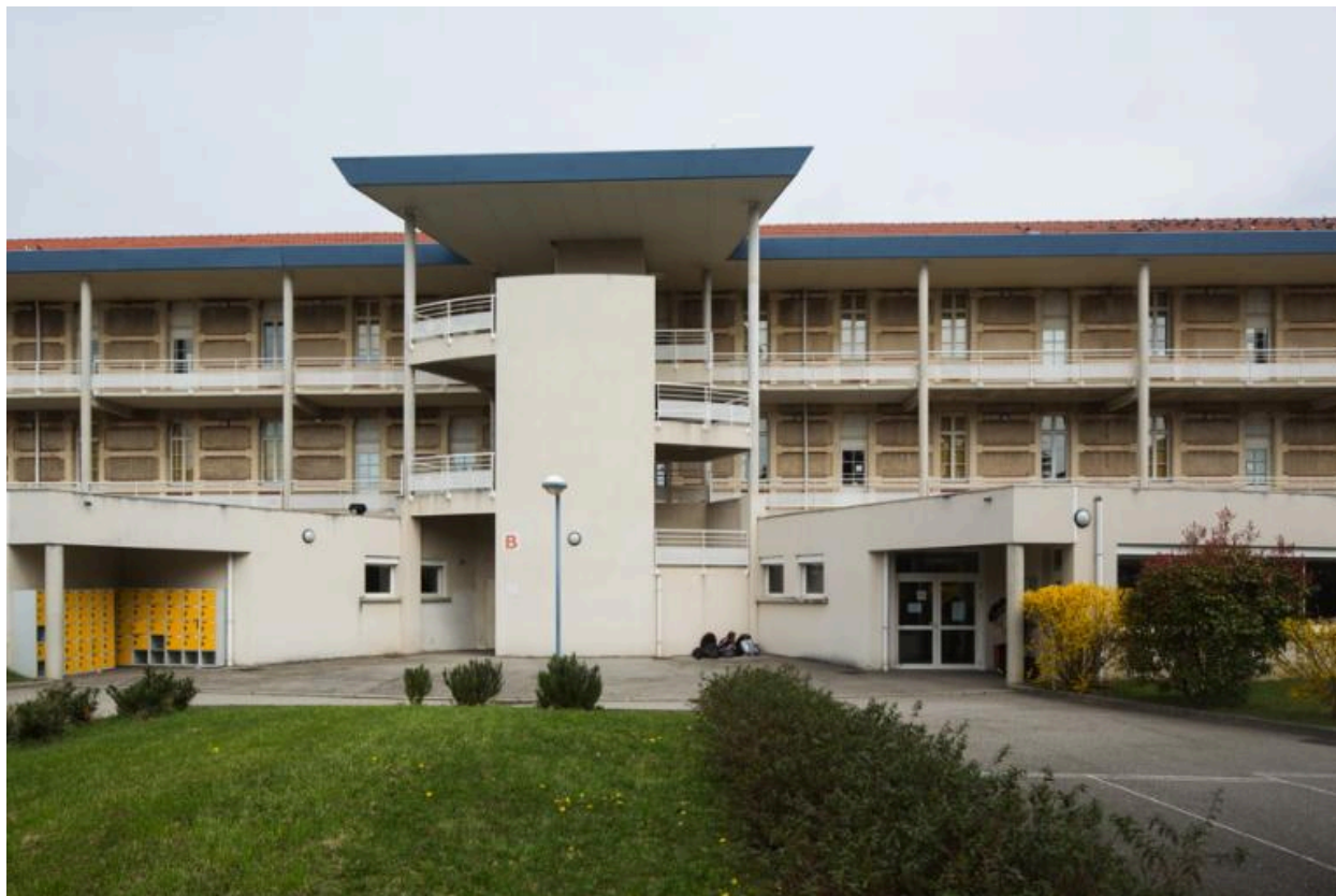
Bâtiment nord : façade sud, avant-corps de l'escalier et ascenseur desservant les coursières
