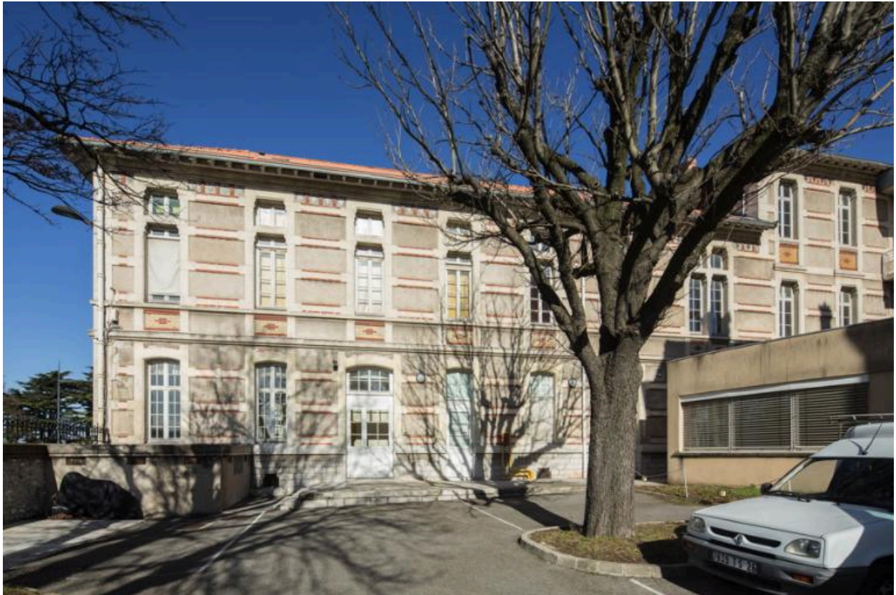
Bâtiment nord : façade sud de l'aile ouest
