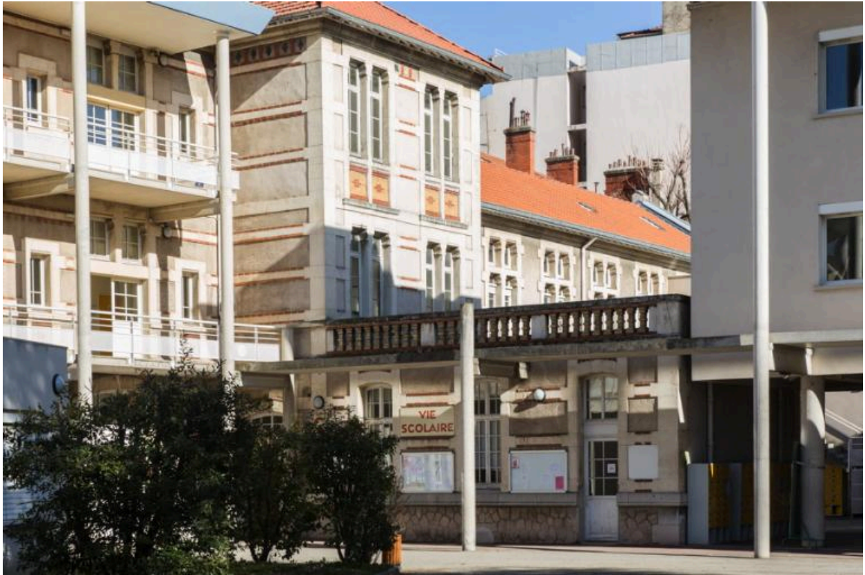
Bâtiment nord : aile en retour à l'est et volume de l'escalier principal
