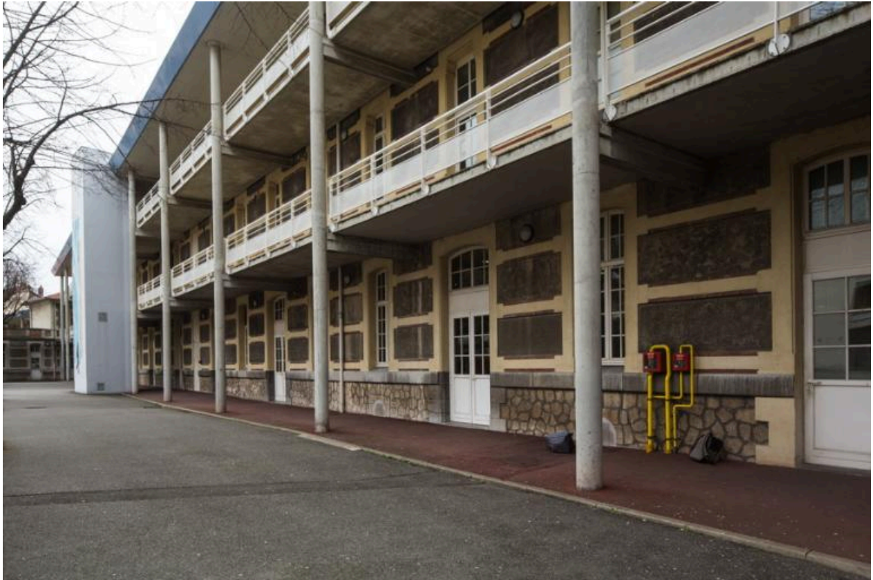
Bâtiment sud : façade nord : étagelement des galeries
