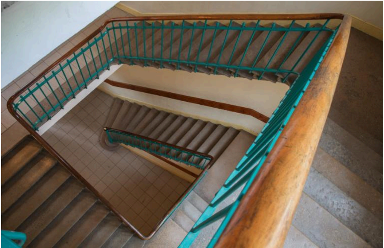
Bâtiment sud : escalier est
