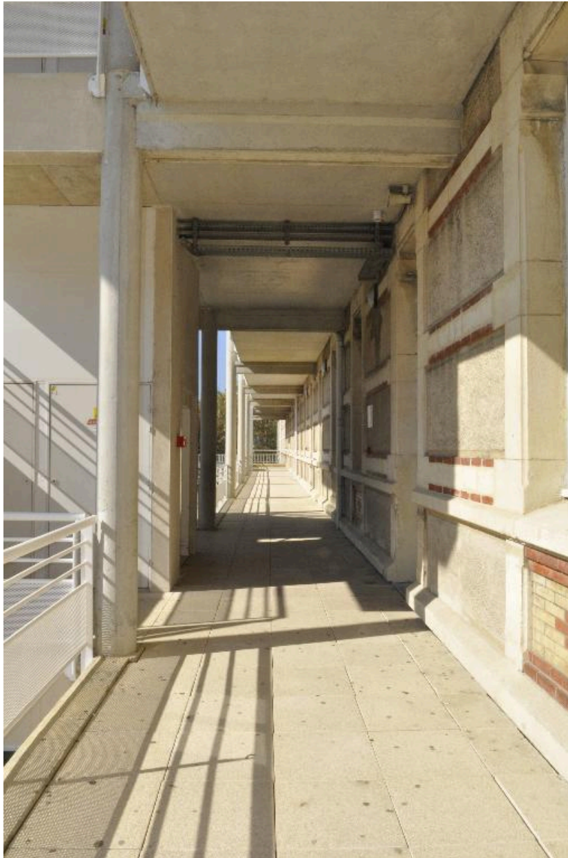
Bâtiment nord : coursière du 1er étage
