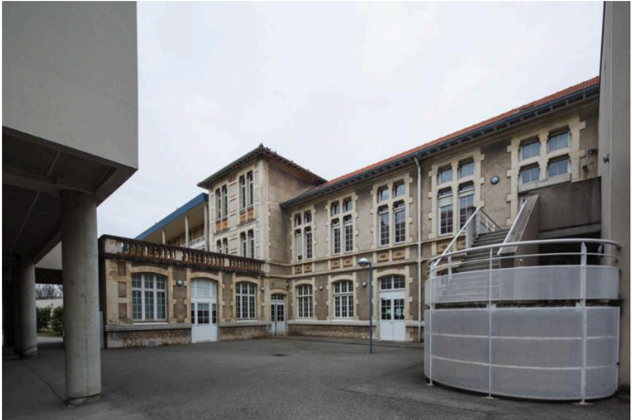
Bâtiment nord : façade sud de l'aile est et foyer des élèves.
