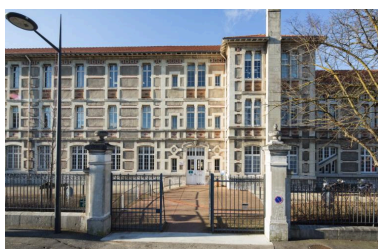
Bâtiment nord : entrée de l'administration et façade surélevée Phot. Pascal Lemaître IVR82_20152600068NUCA
