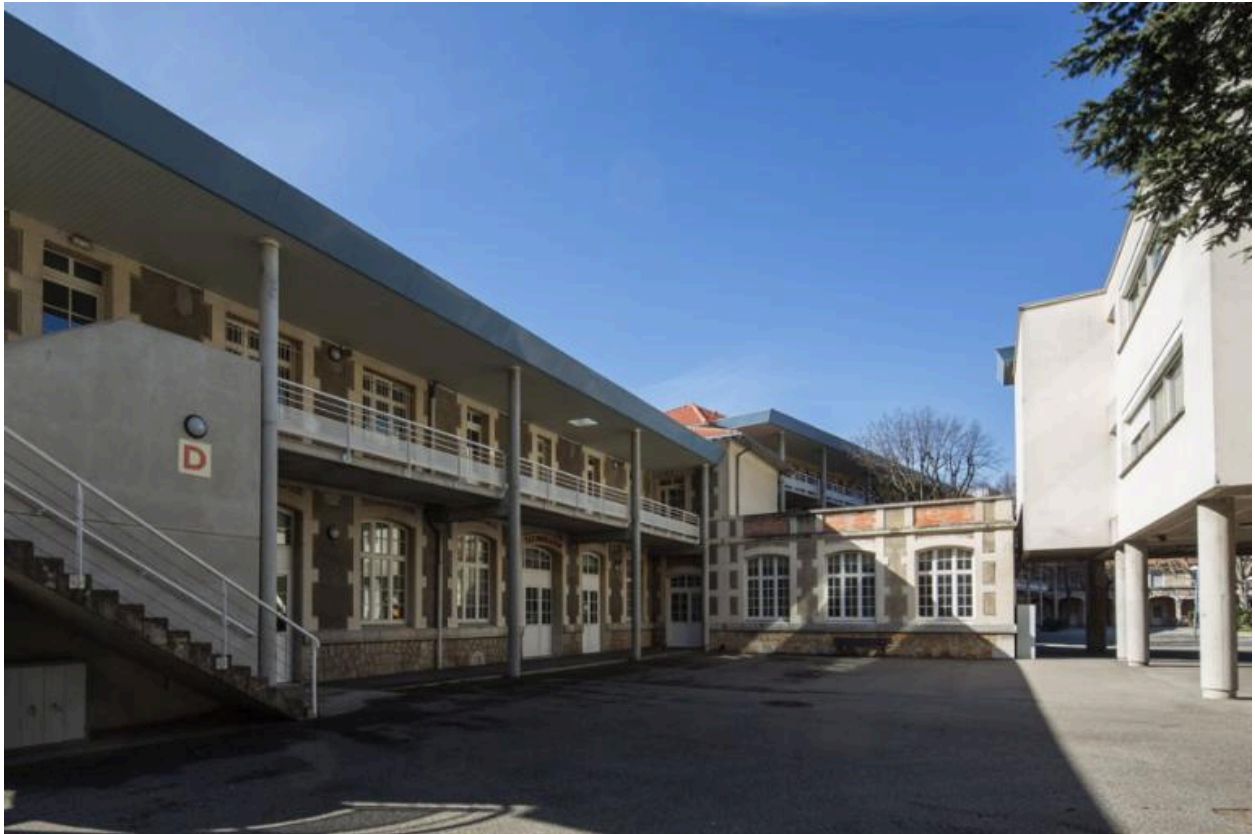
Bâtiment sud : façade nord : aile est à l'arrière du bâtiment des sciences et aile en retour d'équerre.
