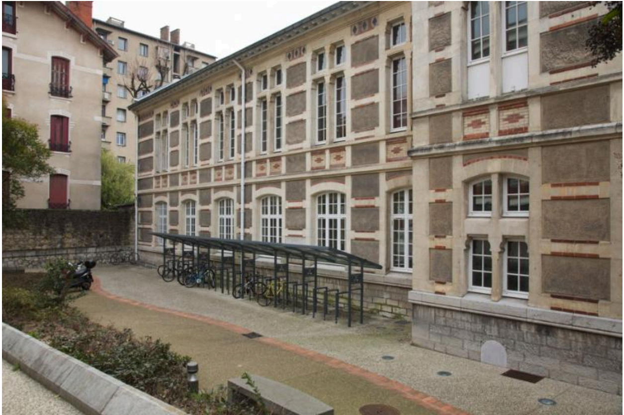
Bâtiment nord : aile est
