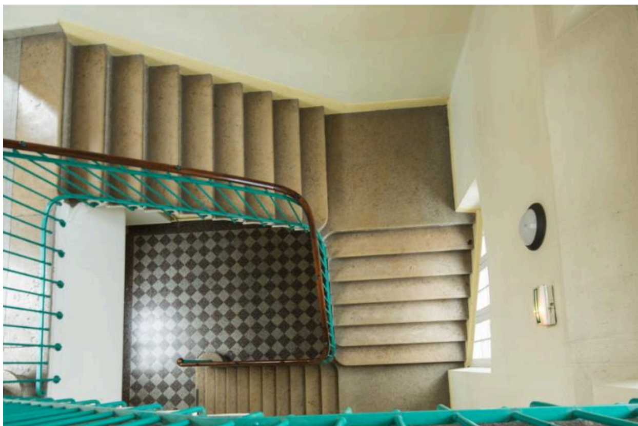
Bâtiment nord : escalier principal, vu depuis le haut
