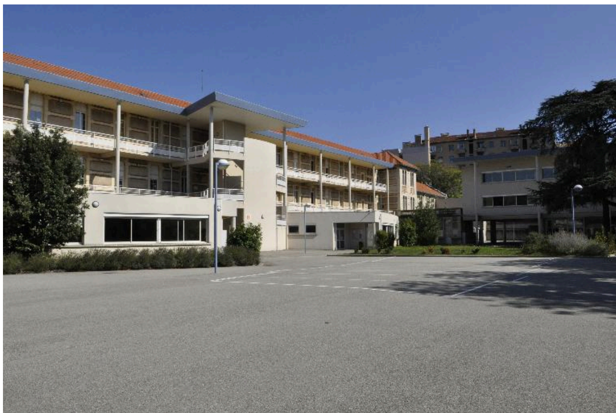
Bâtiment nord : façade sud, partie est
