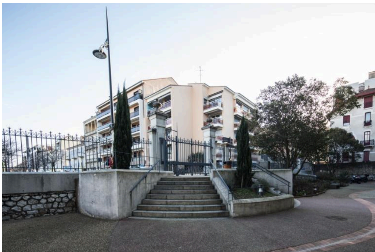
Bâtiment nord : perron et rampe d'accès depuis le Champ de Mars face à l'entrée des élèves
