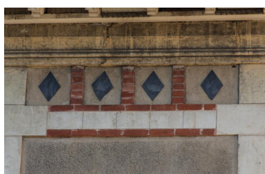
Bâtiment nord : façade nord : détail de la frise, surélévation de 1909 Phot. Pascal Lemaître IVR82_20152600074NUCA
