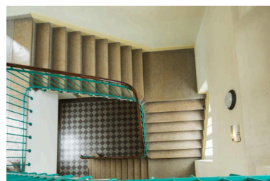
Bâtiment nord : escalier principal, vu depuis le haut Phot. Pascal Lemaître IVR82_20152600113NUCA
