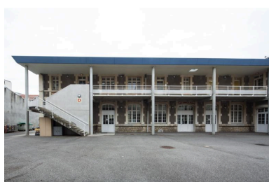
Bâtiment sud : façade nord : aile est. Phot. Pascal Lemaître IVR82_20152600083NUCA
