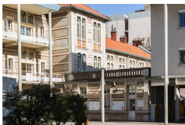
Bâtiment nord : aile en retour à l'est et volume de l'escalier principal Phot. Pascal Lemaître IVR82_20152600076NUCA
