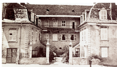
Vue générale Repro. François Fouger IVR82_20057300991NUCB
