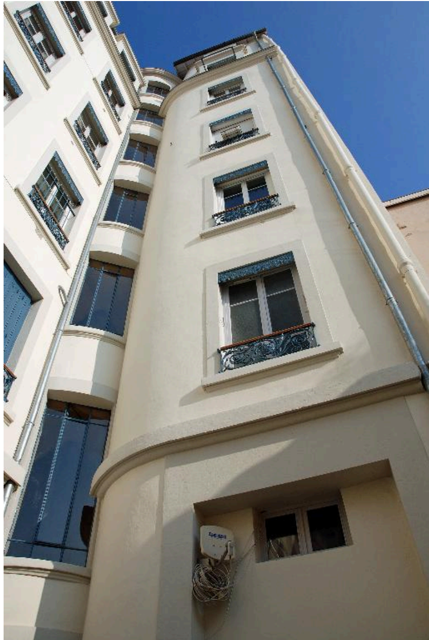
Vue partielle des élévations sur cour
