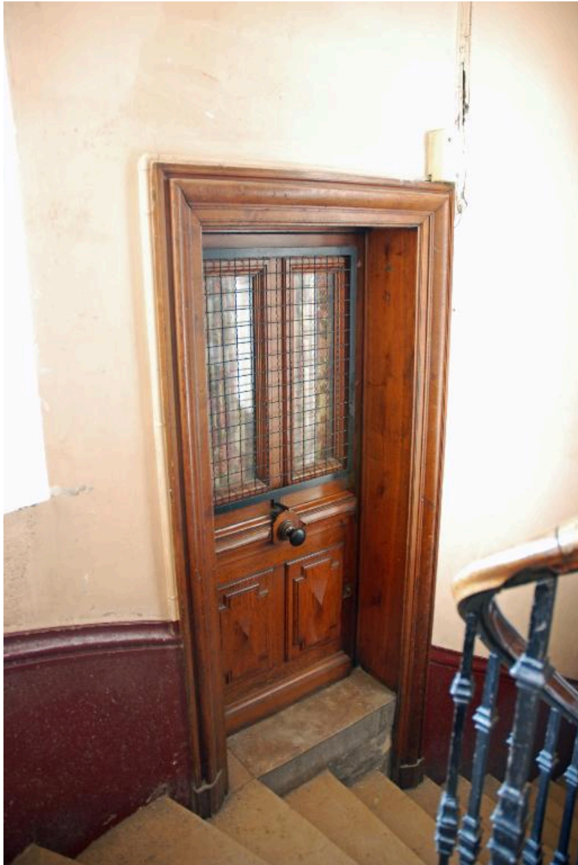
Vue intérieure : porte de la loge de concierge, dans la première volée de l'escalier
