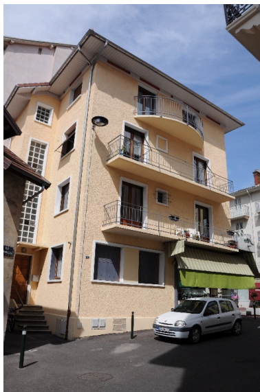
Vue de trois-quarts Phot. François Fouger IVR82_20127300255NUCA
