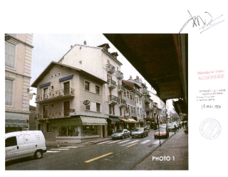
Etat avant travaux Repro. François Fouger IVR82_20127300911NUCB
