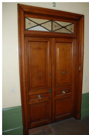
Vue intérieure : porte palière double au deuxième étage carré Phot. Magali Delavenne IVR82_20156901197NUCA
