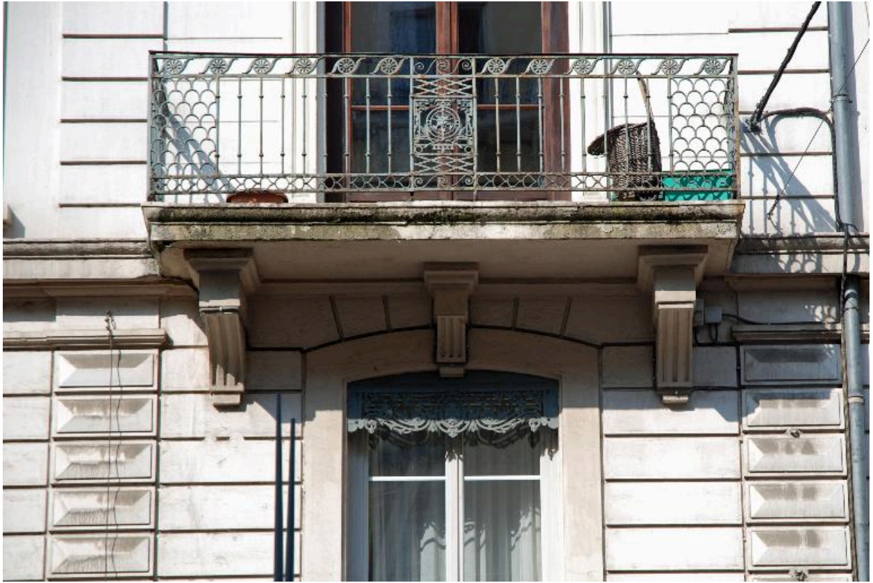
Elévation principale : balcon, garde-corps identique au 12 place Gabriel-Péri
