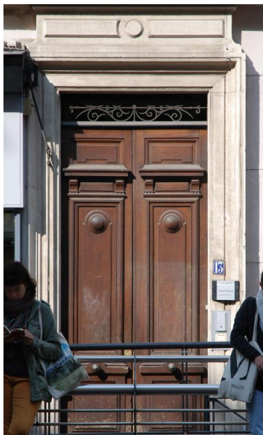
Elévation principale : porte bâtarde, imposte en ferronnerie Phot. Magali Delavenne IVR82_20156901191NUCA
