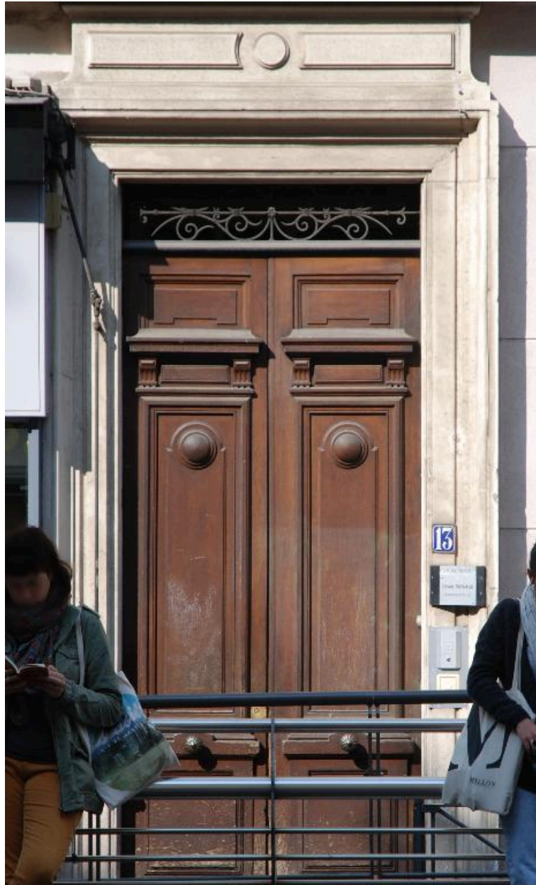
Elévation principale : porte bâtarde, imposte en ferronnerie
