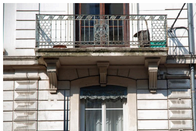
Elévation principale : balcon, garde-corps identique au 12 place Gabriel-Péri Phot. Magali Delavenne IVR82_20156901190NUCA
