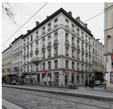
Vue de situation, depuis le nord-est Phot. Eric Dessert IVR84_20166901389NUCA
