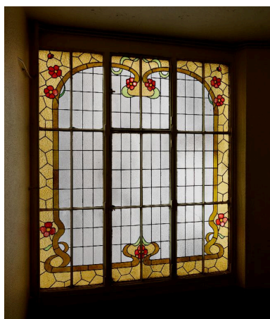
Vue intérieure : une des verrières éclairant la cage d'escalier Phot. Eric Dessert IVR84_20166901386NUCA
