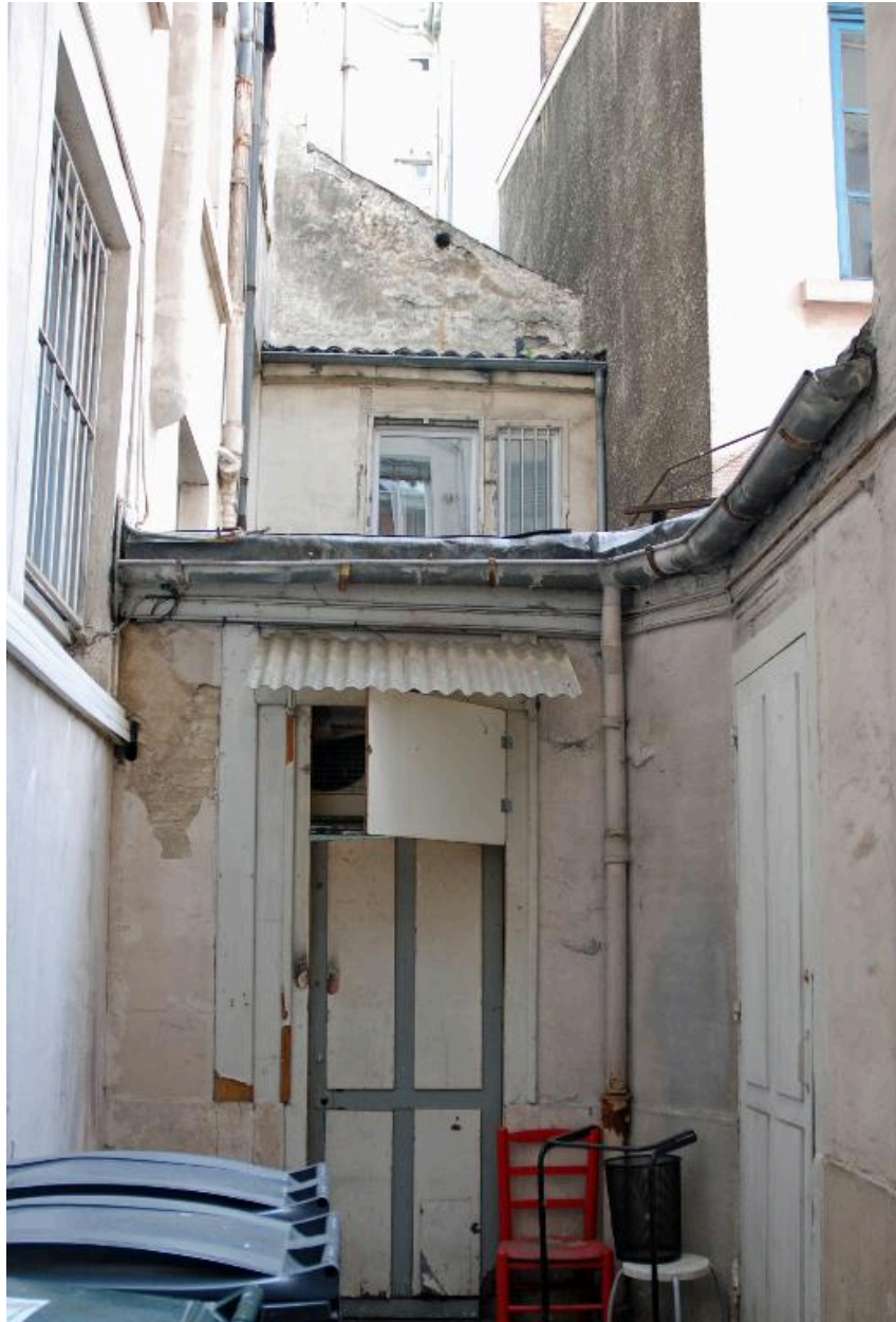
Vue partielle des bâtiments sur cour
