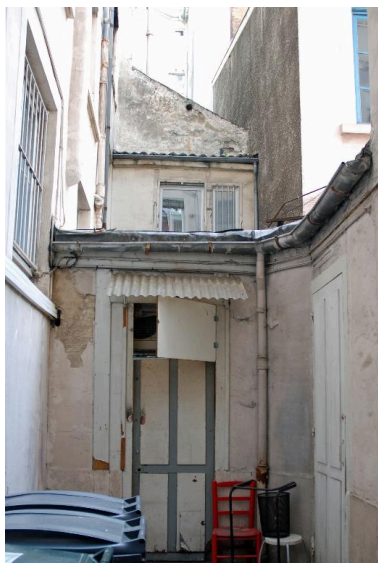
Vue partielle des bâtiments sur cour Phot. Magali Delavenne IVR82_20156901187NUCA
