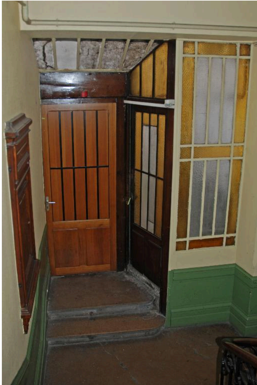
Vue intérieure : porte de la loge de concierge, sur le premier repos
