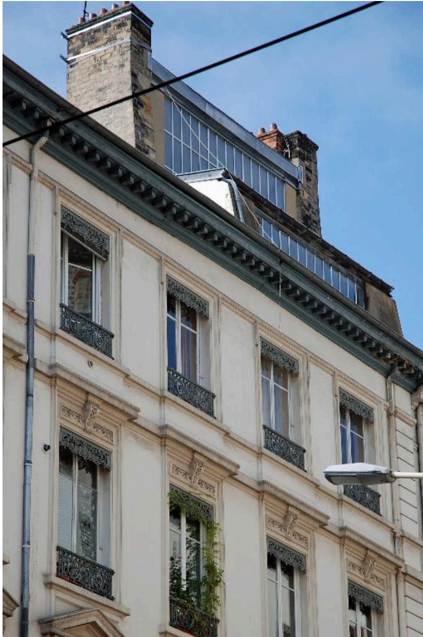
Elévation latérale : étage de comble partiellement aménagé avec verrière et toit-terrasse
