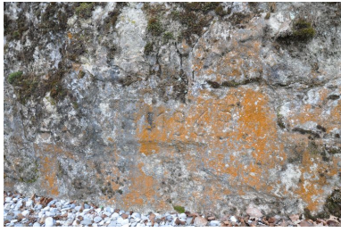
Date portée sur le massif du seuil Phot. Samir Mahfoudi, Autr. Samir Mahfoudi IVR82_20107403192NUCA
