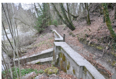
Vue générale du canal de dérivation Phot. Samir Mahfoudi, Autr. Samir Mahfoudi IVR82_20107403190NUCA
