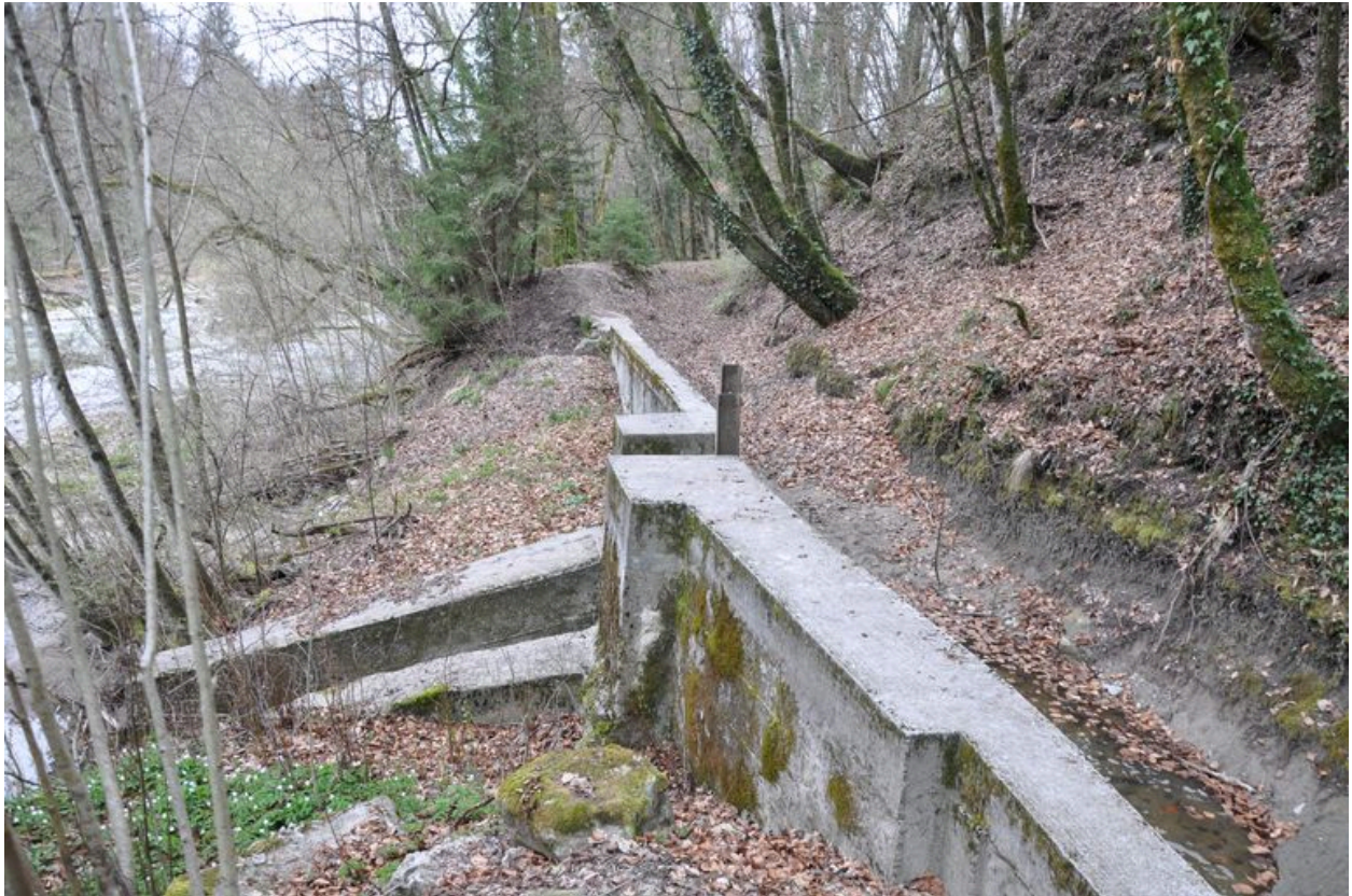
Vue générale du canal de dérivation
