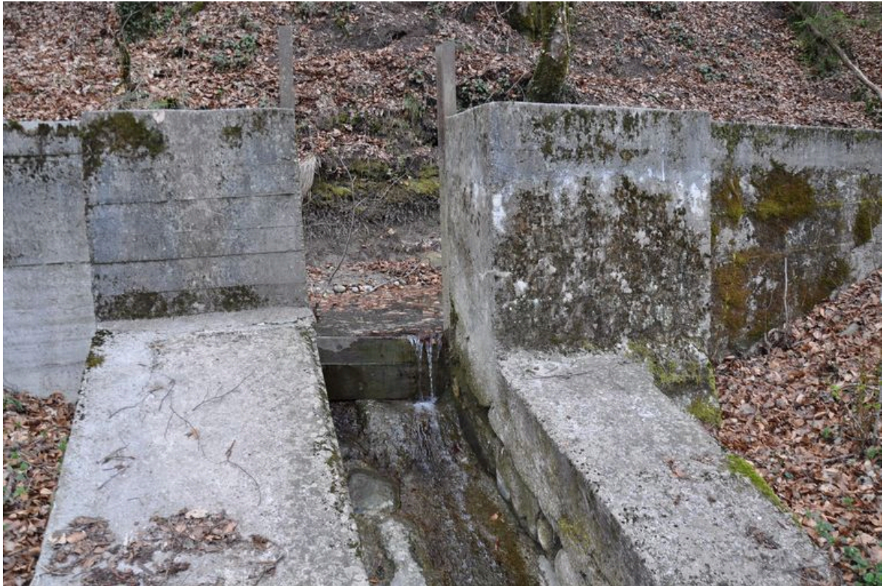
Détail du trop plein
