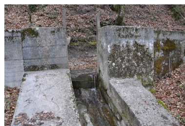
Détail du trop plein Phot. Samir Mahfoudi, Autr. Samir Mahfoudi IVR82_20107403191NUCA
