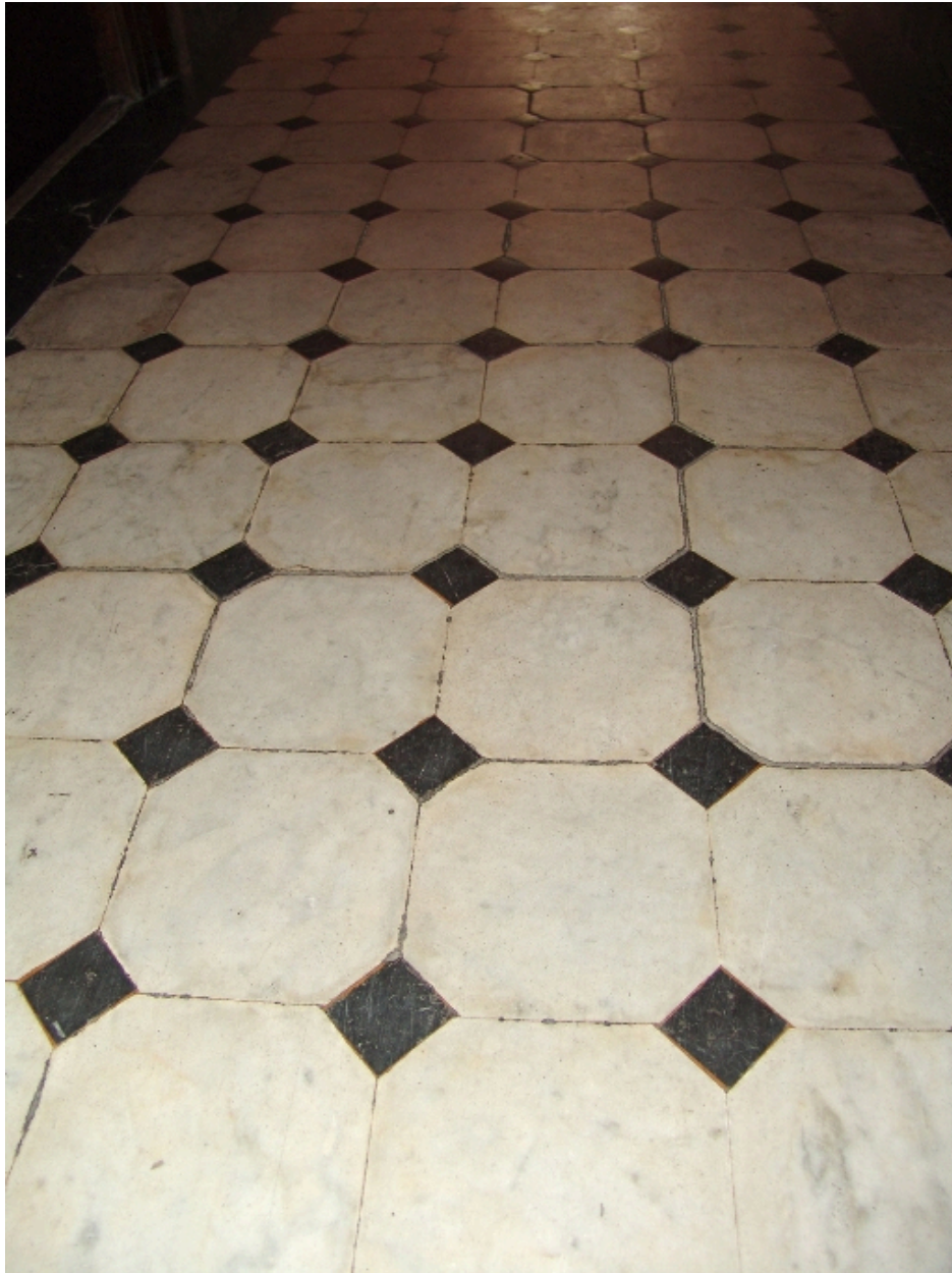
Détail du carrelage du rez-de-chaussée
