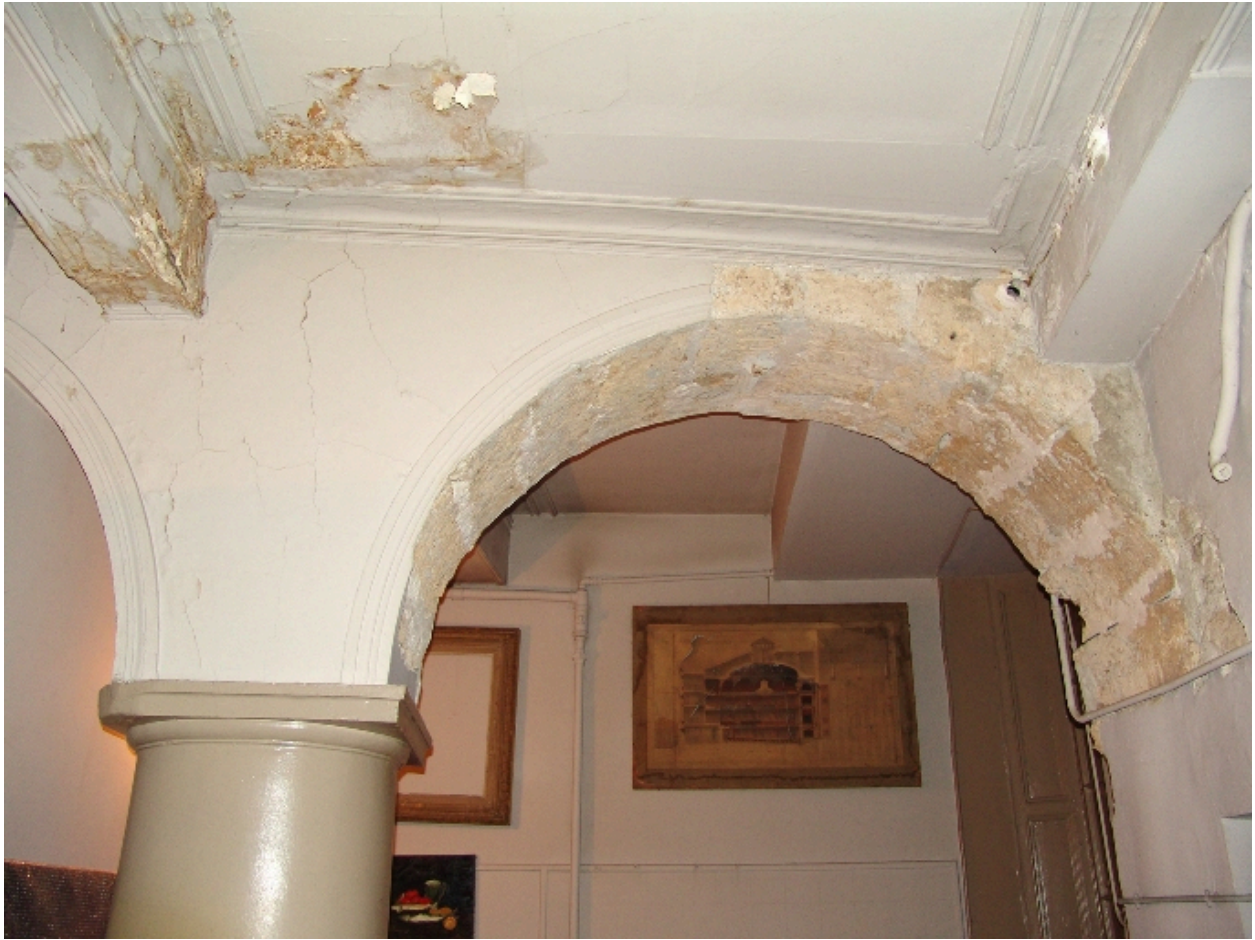
Colonne et arcs visibles à l'arrière du 1er étage
