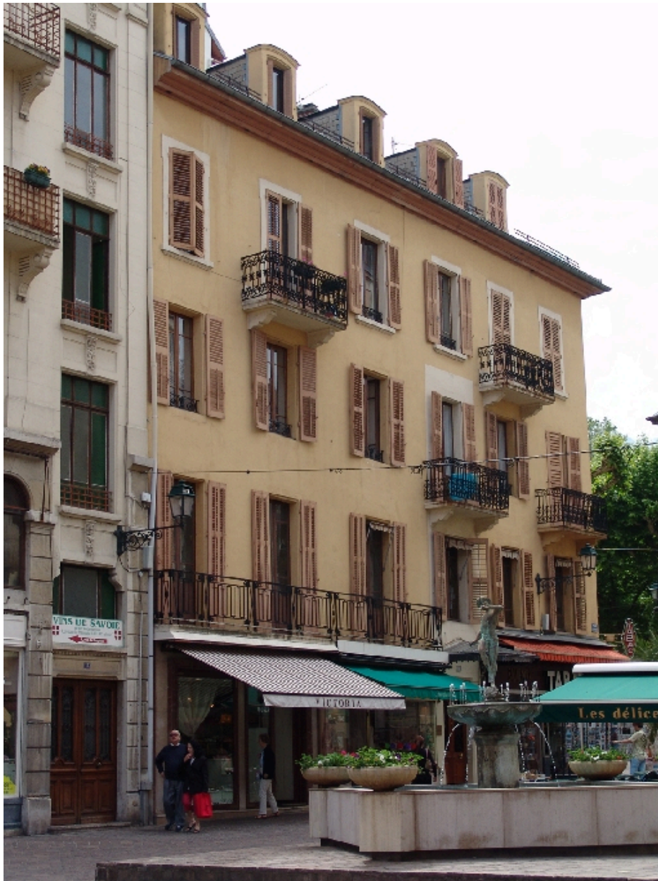
Façade sur la place Carnot
