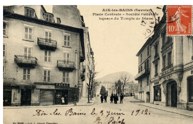
Angle sud-ouest de l'hôtel Repro. François Fouger IVR82_20057300286NUCB
