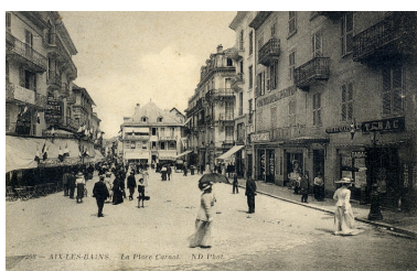
Façade sur la place Repro. François Fouger IVR82_20057300287NUCB
