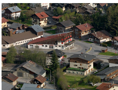
Vue d'ensemble depuis la montagne du Jaillet au sud-ouest Phot. Eric Dessert IVR82_20107401395NUCA
