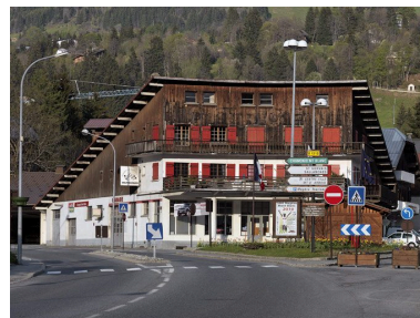
Vue de 3/4 gauche Phot. Eric Dessert IVR82_20107401401NUCA
