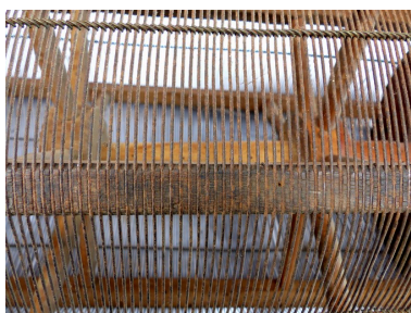
Détail du passage du fil métallique sur les tasseaux. Phot. Alexeï Laurent IVR84_20162601113NUCA
