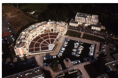
Vue aérienne, 1995 : L'Adelphia à droite Repro. Denys Harreau IVR84_20177300079NUCB
