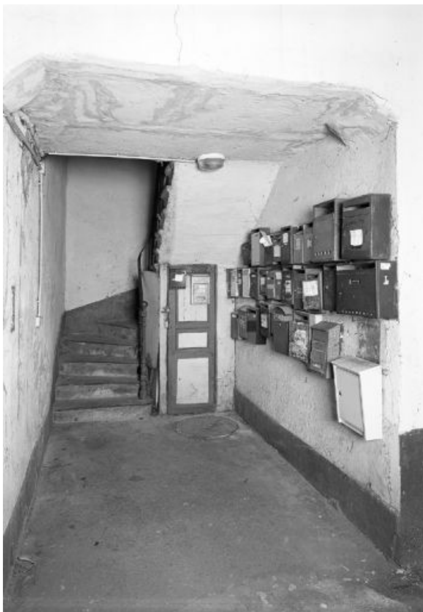
Vue de l'escalier de l'immeuble en fond de cour
