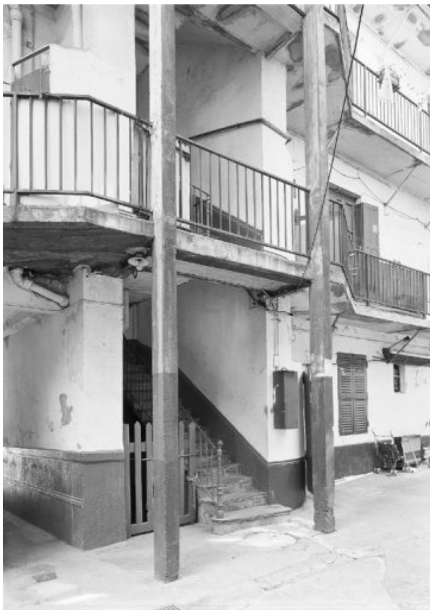
Vue de la montée d'escalier de l'immeuble sur rue
