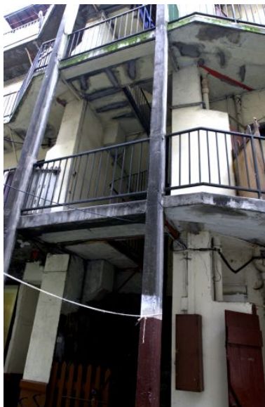
Vue de la montée d'escalier de l'immeuble sur rue Phot. Maryannick Chalabi IVR82_20016900055NUCA
