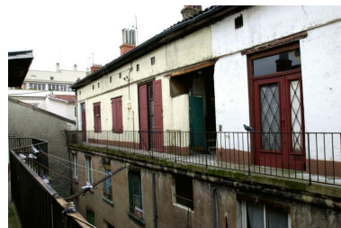
Vue de la coursière du dernier étage de l'immeuble sur cour Phot. Maryannick Chalabi IVR82_20016900058NUCA
