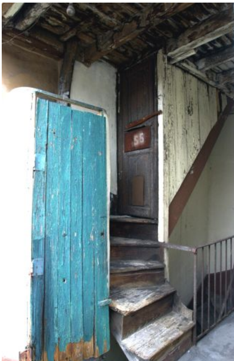
Immeuble sur cour : la dernière volée d'escalier en bois, et les latrines sur le palier
