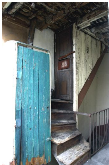
Immeuble sur cour : la dernière volée d'escalier en bois, et les latrines sur le palier Phot. Maryannick Chalabi IVR82_20016900061NUCA
