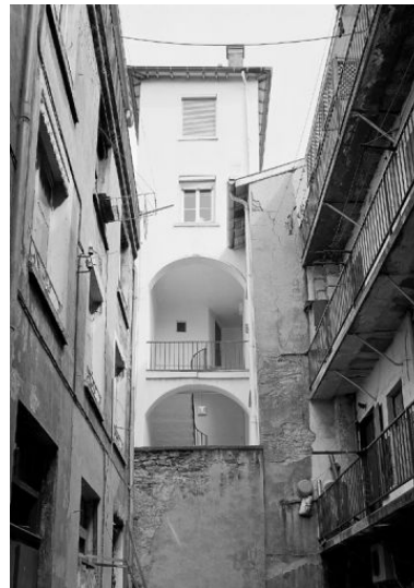
Vue de la cour depuis l'ouest Phot. Jean-Marie Refflé IVR82_20016901773P
