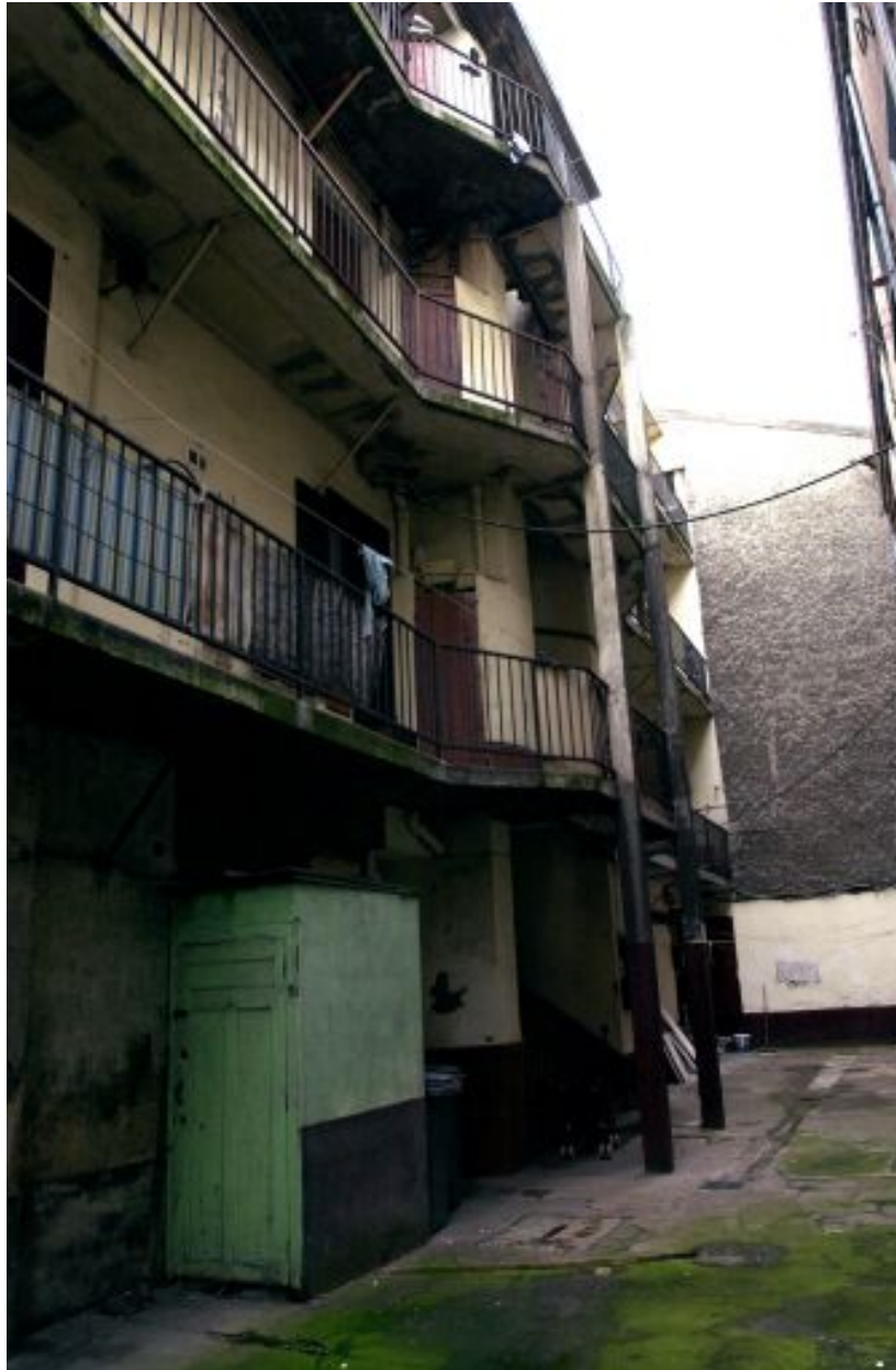
Elévation postérieure de l'immeuble sur rue, depuis l'est. Détail
