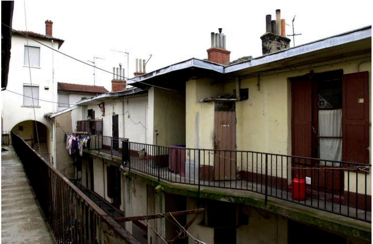
Élévation postérieure de l'immeuble sur rue, depuis l'ouest
