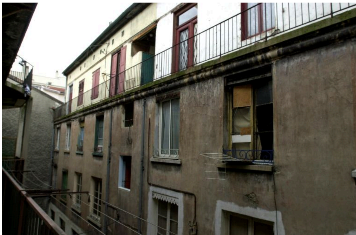
Elévation de l'immeuble sur cour depuis l'est
