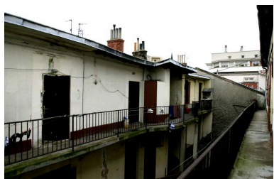
Elévation postérieure de l'immeuble sur rue depuis l'est Phot. Maryannick Chalabi IVR82_20016900060NUCA
