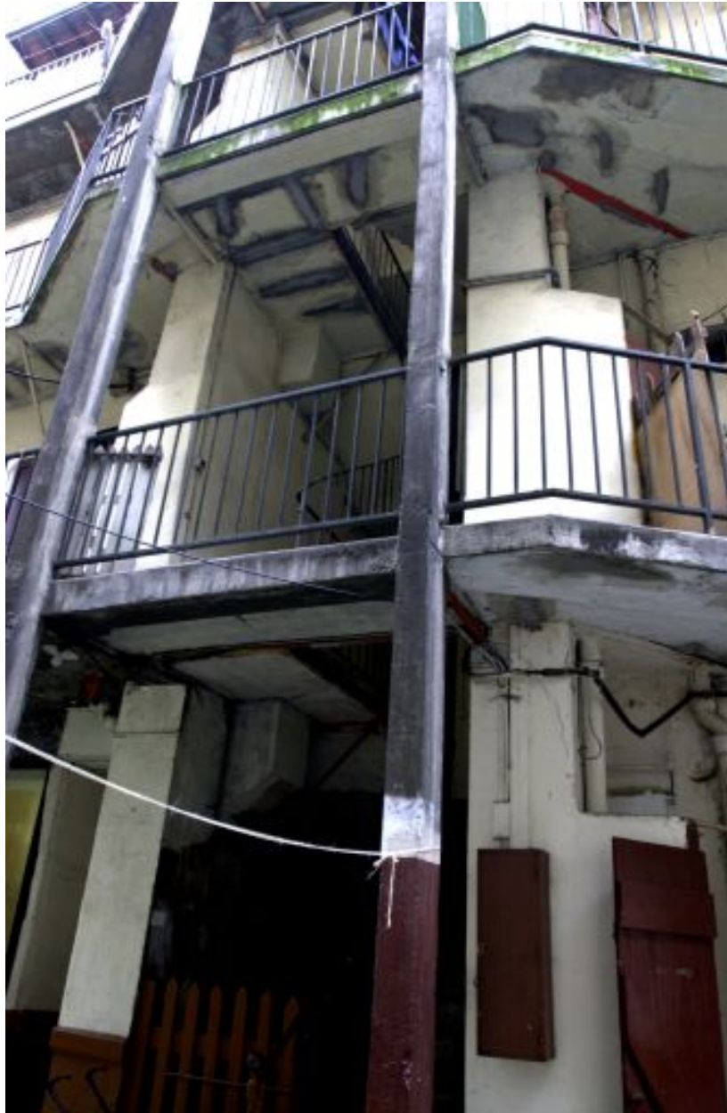
Vue de la montée d'escalier de l'immeuble sur rue
