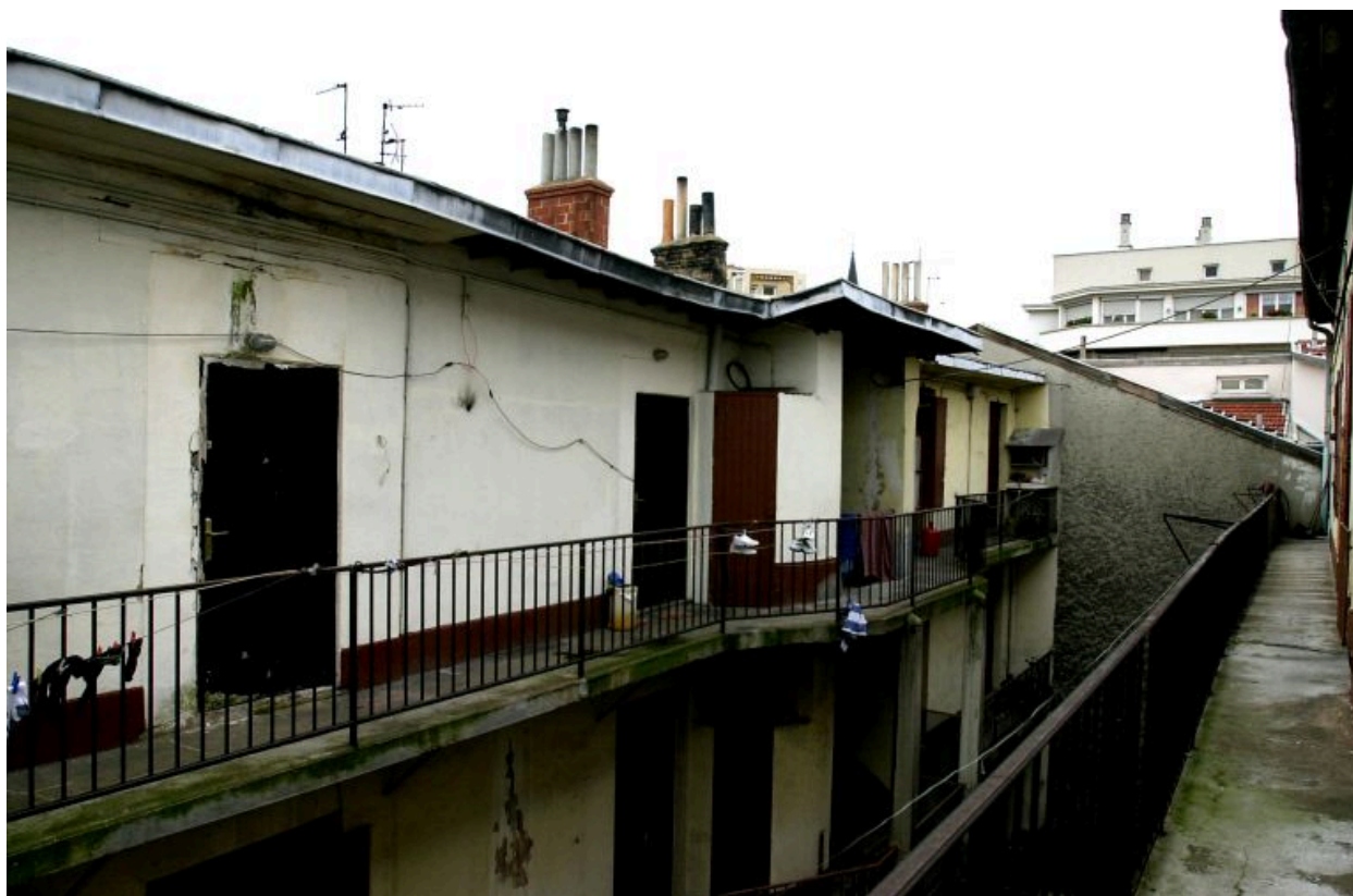
Elévation postérieure de l'immeuble sur rue depuis l'est
