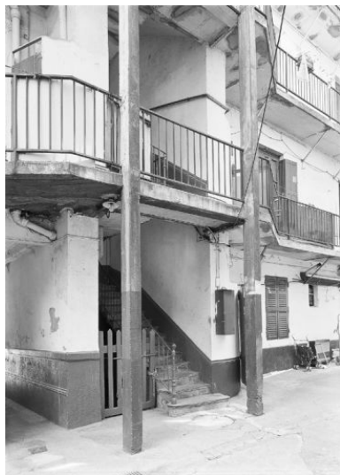
Vue de la montée d'escalier de l'immeuble sur rue Phot. Jean-Marie Refflé IVR82_20016901774P
