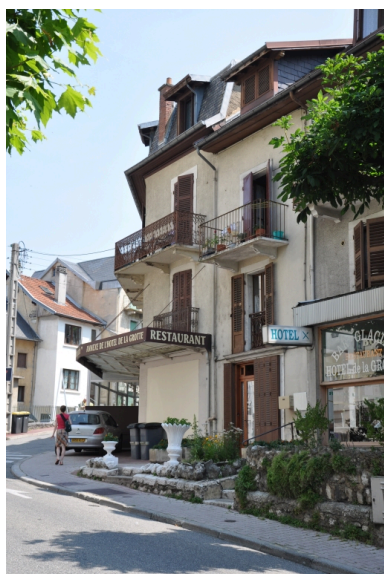
détail de l'angle antérieur droit Phot. François Fouger IVR82_20107301276NUCA
