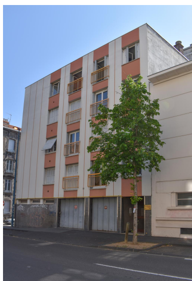
Elévation sur l'avenue d'Italie Phot. Félicie Fougère IVR84_20246300034NUCA
