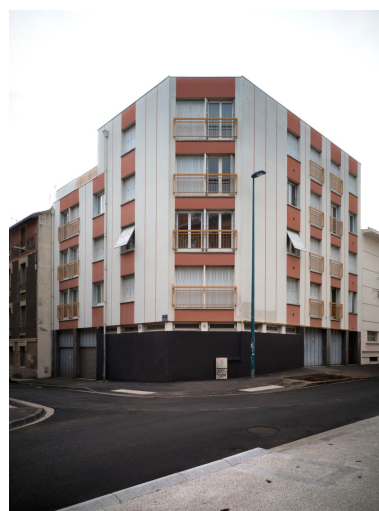
Travée d'angle et élévations Phot. Christian Parisey IVR84_20246300103NUC4A
