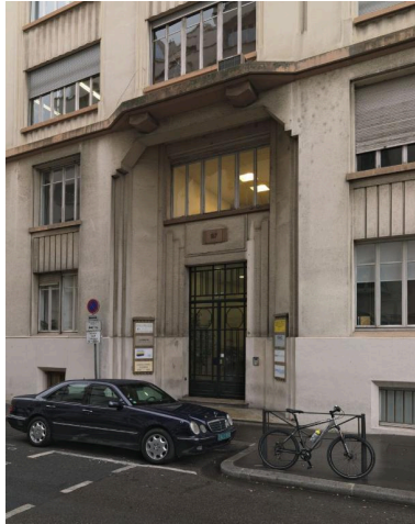
Détail entrée principale Phot. Didier Gourbin IVR82_20116905316NUCA
