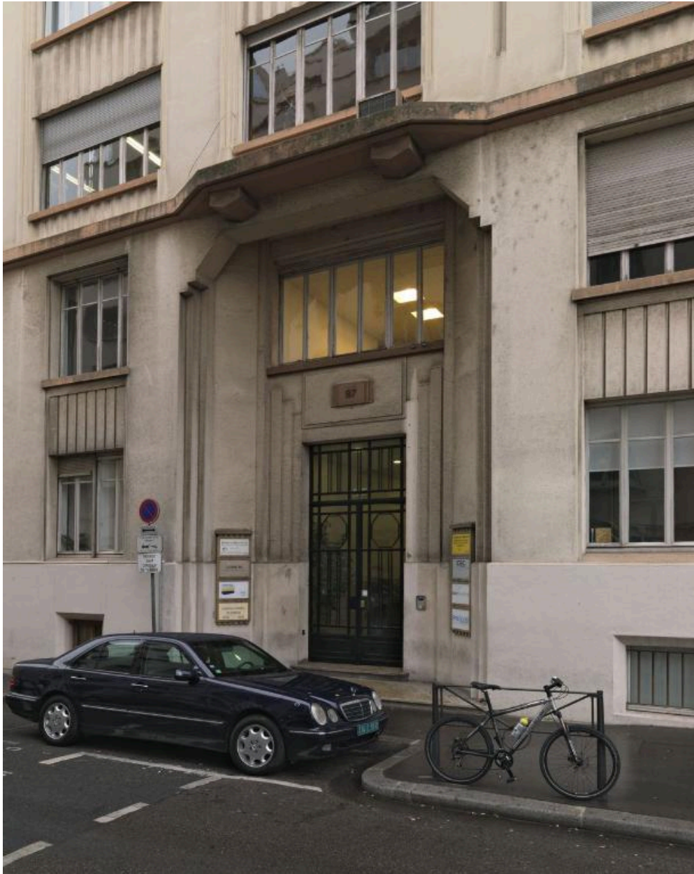
Détail entrée principale
