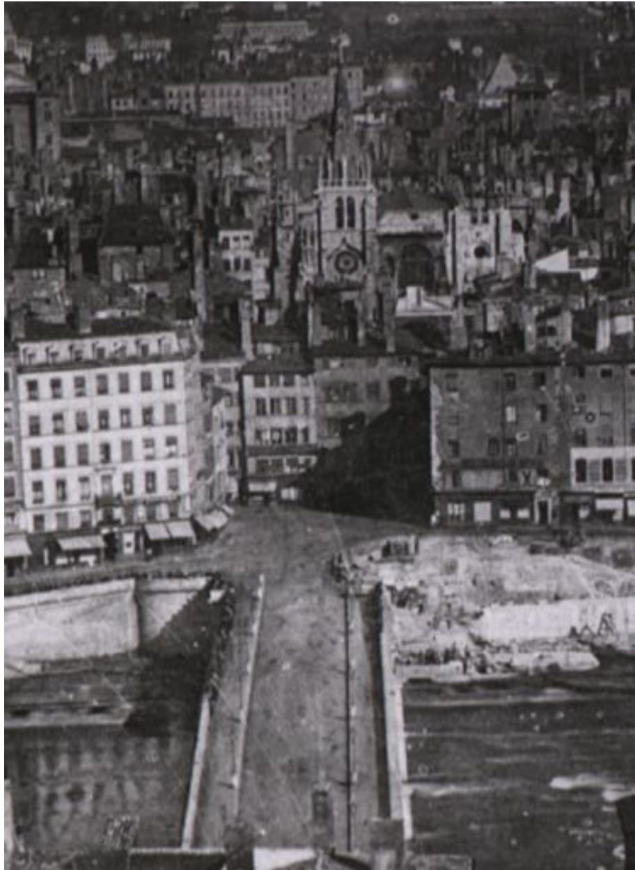
Démolition du Pont de Pierre [vue générale de la place], détail d'une fotogr., ca 1848
