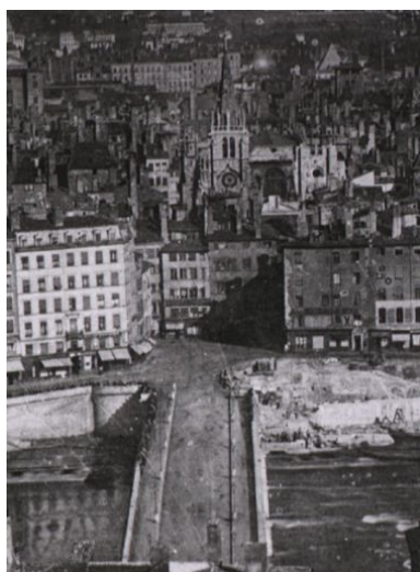
Démolition du Pont de Pierre [vue générale de la place], détail d'une fotogr., ca 1848 Phot. Repr. BM Lyon D. Nicolle IVR82_20056902069NUCB
