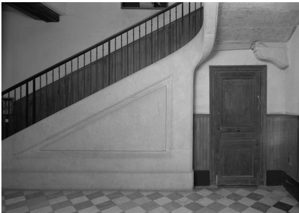
Escalier d'honneur, détail : mur d'échiffre et limon.
