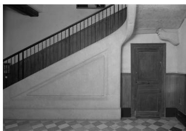
Escalier d'honneur, détail : mur d'échiffre et limon. Phot. Eric Dessert IVR82_19910100536P
