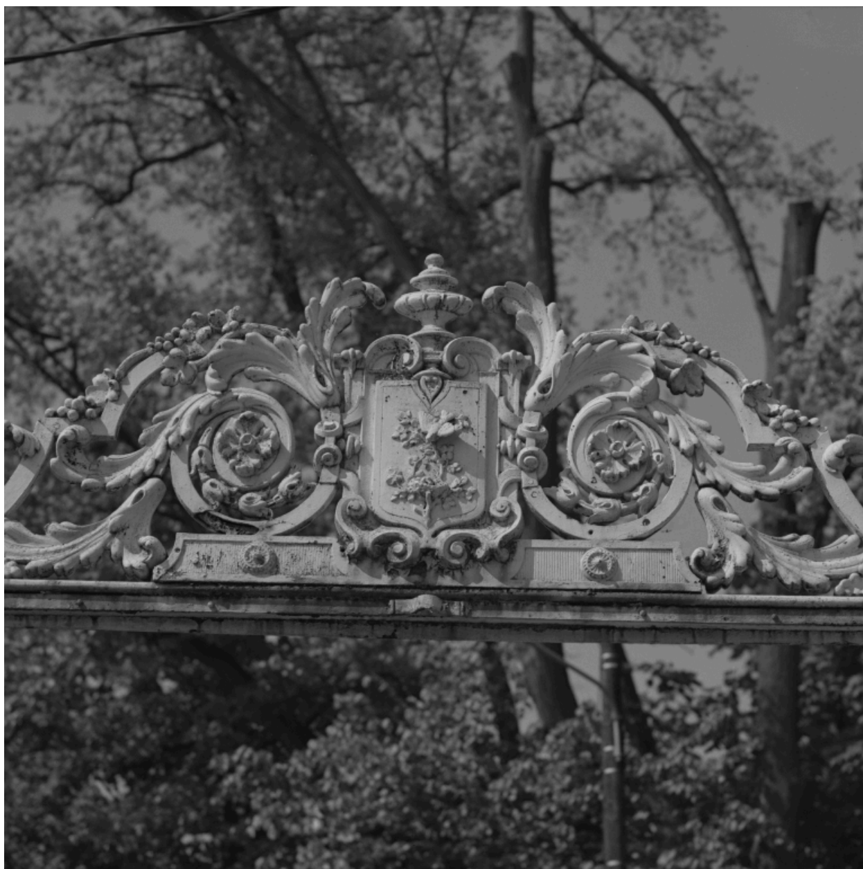
Portail d'entrée, détail du couronnement avec armoiries.
