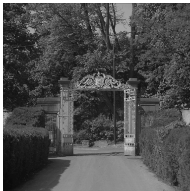
Portail d'entrée, vue d'ensemble. Phot. Eric Dessert IVR82_19910100530X
