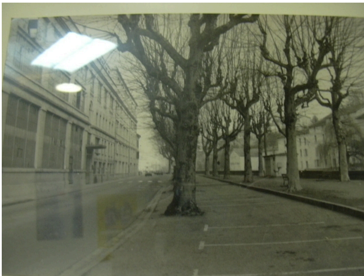
Photographie, usine quai rue Lafayette
