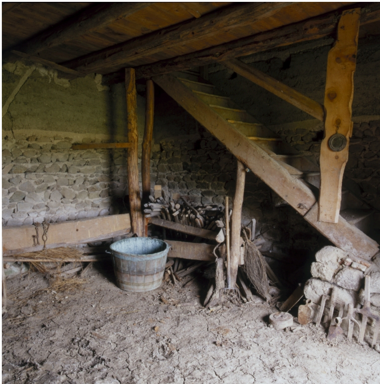
Vue intérieure du rez-de-chaussée, angle nord-ouest.
