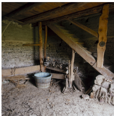
Vue intérieure du rez-de- chaussée, angle nord-ouest. Phot. Eric Dessert IVR82_20014200245XA
