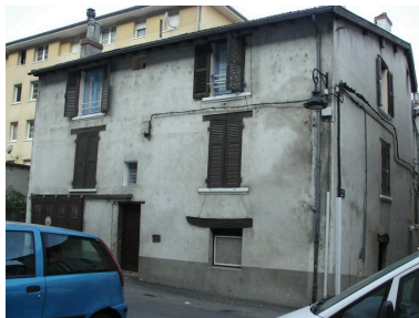
façade Est Phot. Benoît Chapelle IVR82_20073800020NUCA
