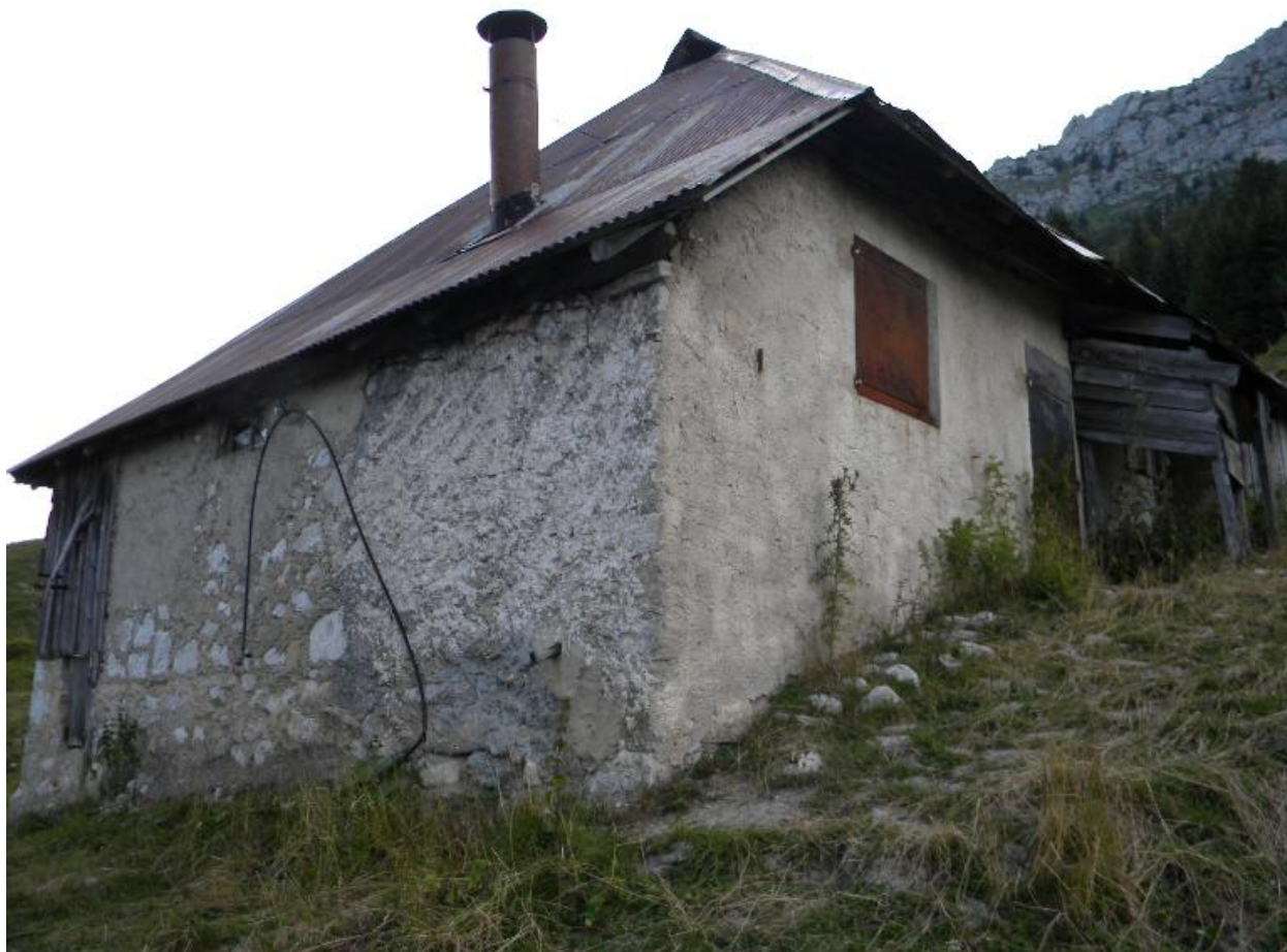
Vue de trois-quarts sud-ouest du bâtiment principal
