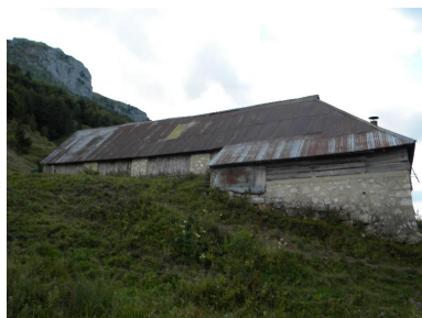
Vue de la façade nord du bâtiment principal Phot. Jérôme Daviet IVR84_20167306776NUCA
