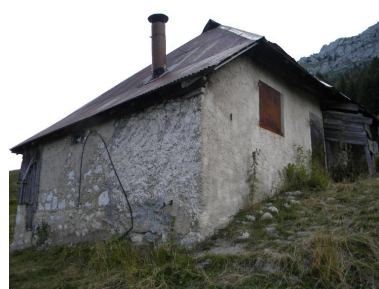
Vue de trois quarts sud-ouest du bâtiment principal Phot. Jérôme Daviet IVR84_20167306774NUCA
