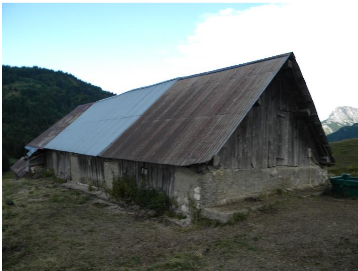
Vue de trois quarts-sud-est du bâtiment principal.
