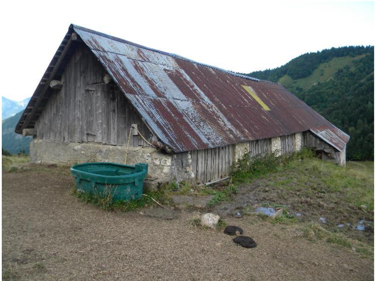
Vue de trois-quarts nord-est du bâtiment principal.
