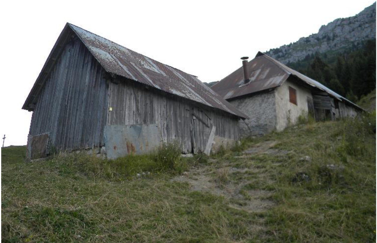
Vue d'ensemble des bâtiments amont.
