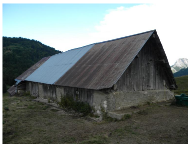
Vue de trois quarts-sud-est du bâtiment principal. Phot. Jérôme Daviet IVR84_20167306772NUCA
