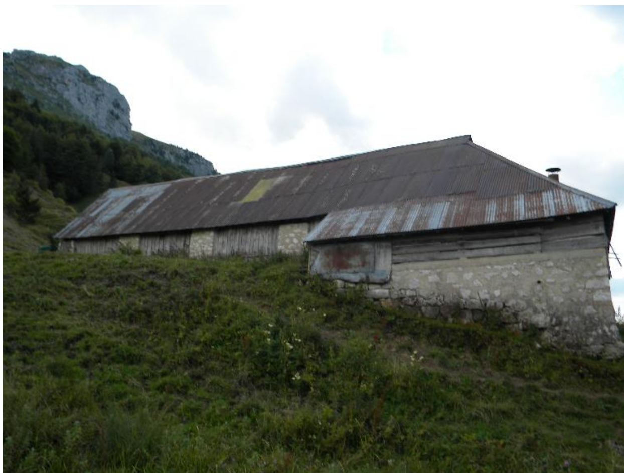
Vue de la façade nord du bâtiment principal
