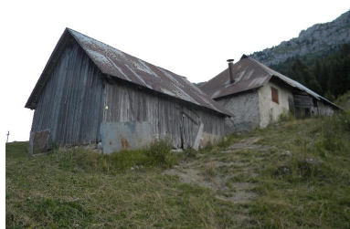
Vue d'ensemble des bâtiments amont. Phot. Jérôme Daviet IVR84_20167306777NUCA
