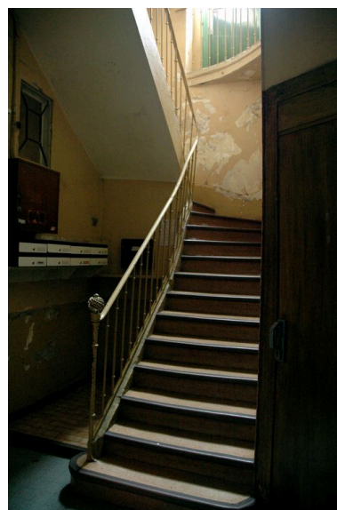
Vue du départ de l'escalier Phot. Maryannick Chalabi IVR82_20076900497NUCA
