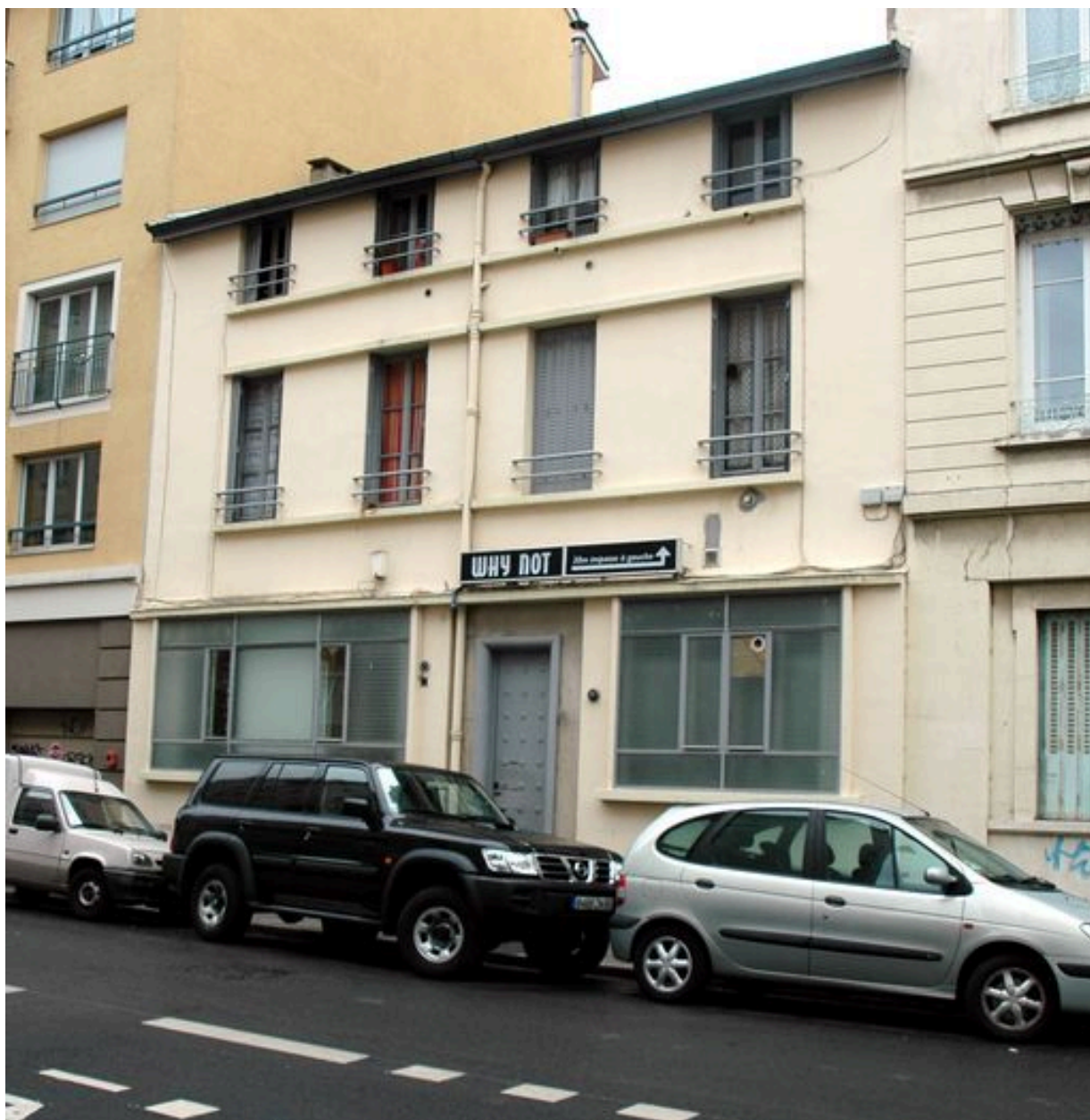
Élévation principale depuis le sud-ouest
