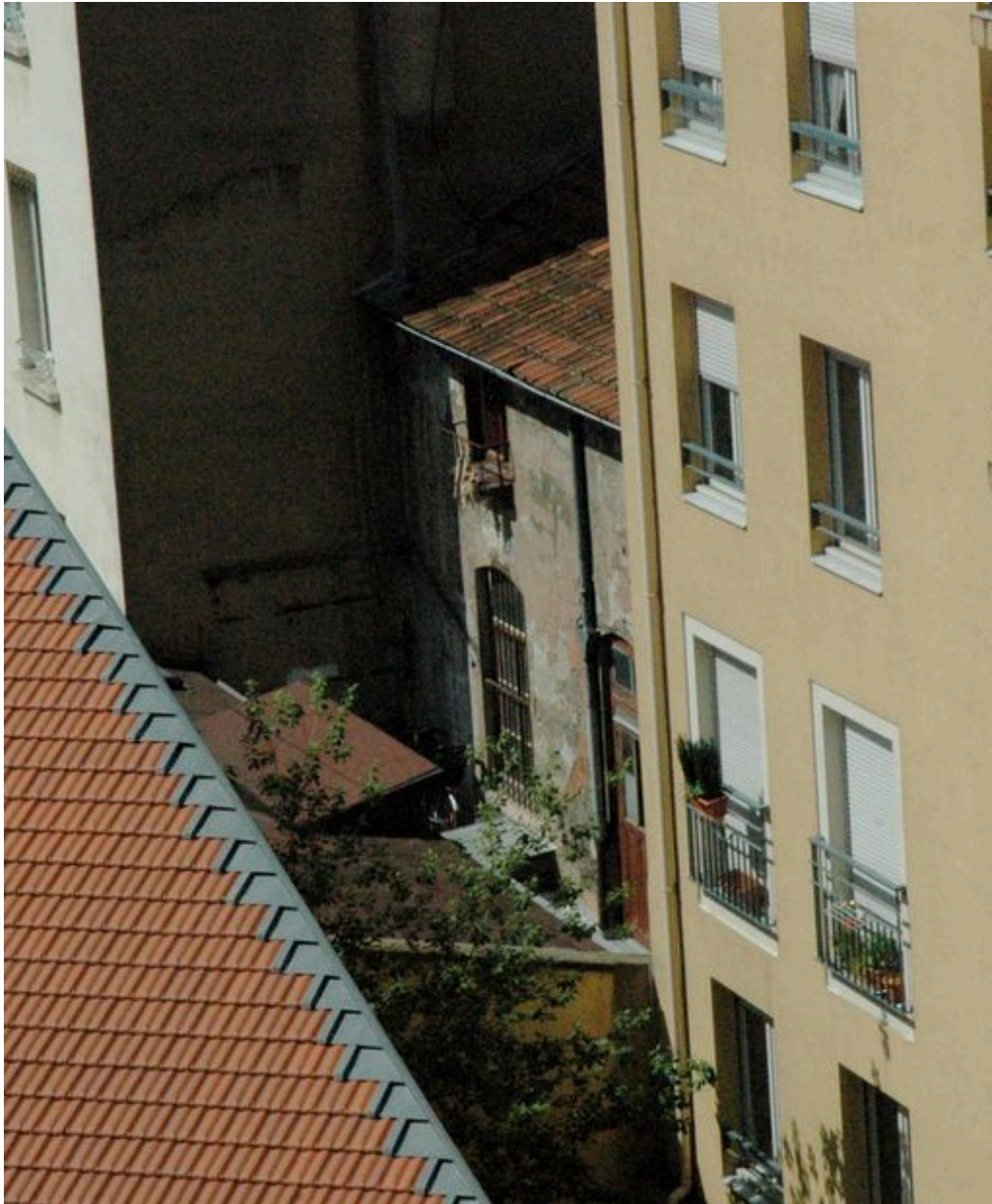
Elévation postérieure depuis le nord-est
