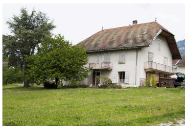
Vue d'ensemble depuis le sud-ouest Phot. Denys Harreau IVR82_20147300827NUCA
