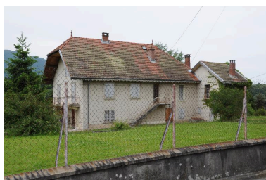
Vue d'ensemble depuis l'arrière Phot. Denys Harreau IVR82_20147300826NUCA
