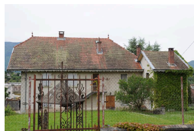
Façade postérieure Phot. Denys Harreau IVR82_20147300825NUCA
