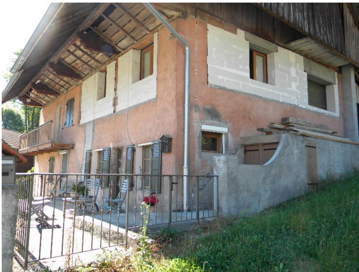
Vue de trois-quarts d'une ancienne ferme transformée (2008 F3 2381).
