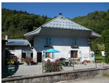
Vue du mur pignon d'une ancienne ferme (2008 F3 419) Phot. Jérôme Daviet IVR82_20137401013NUCA
