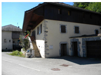
Vue de trois-quarts d'une ancienne ferme avec encadrements en calcaire marbrier (2008 F3 463). Phot. Jérôme Daviet IVR82_20137401021NUCA
