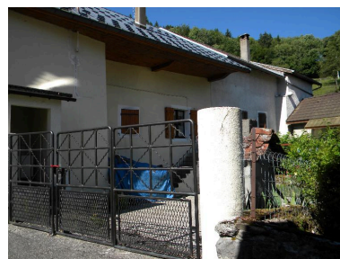
Vue de la façade nord d'un ensemble de fermes mitoyennes (2008 F3 420, 435, 436, 437). Phot. Jérôme Daviet IVR82_20137401014NUCA
