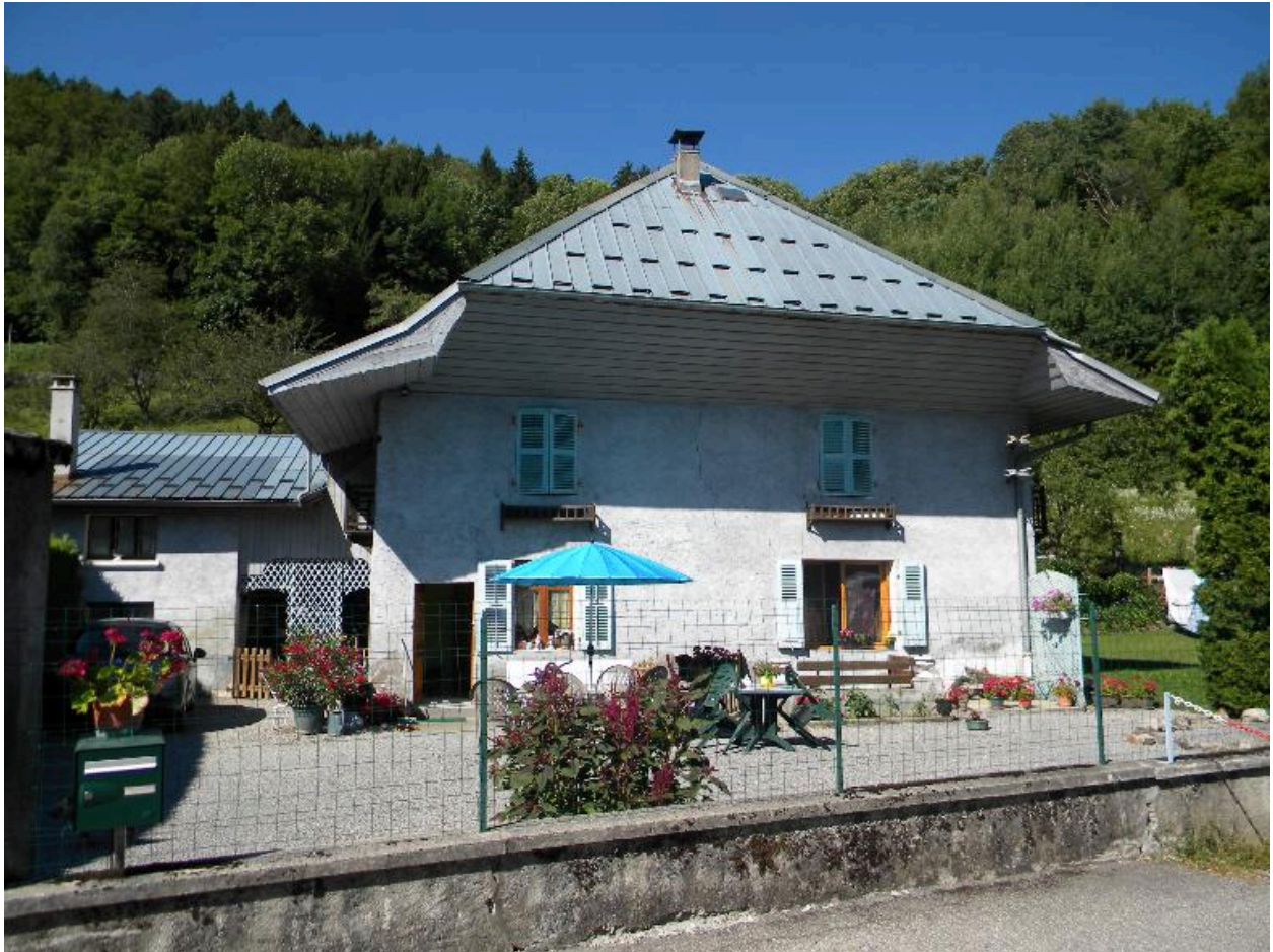
Vue du mur pignon d'une ancienne ferme (2008 F3 419)
