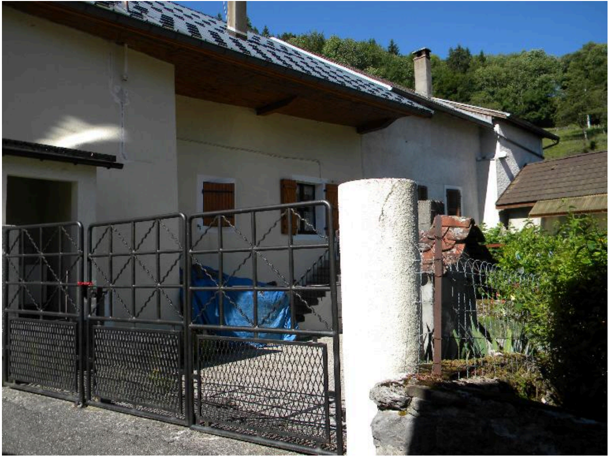
Vue de la façade nord d'un ensemble de fermes mitoyennes (2008 F3 420, 435, 436, 437).
