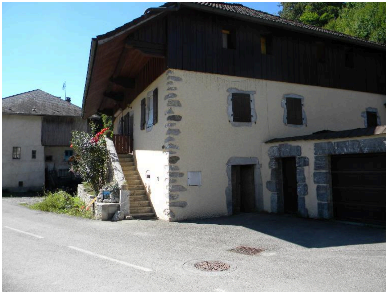
Vue de trois-quarts d'une ancienne ferme avec encadrements en calcaire marbrier (2008 F3 463).
