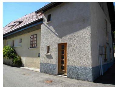
vue de deux logis mitoyens (2008 F3 452, 2302). Phot. Jérôme Daviet IVR82_20137401017NUCA
