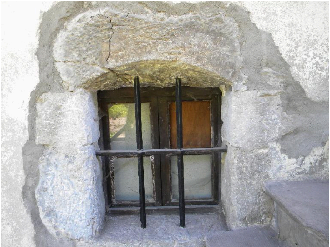
Détail d'une fenêtre à linteau délardé en façade d'une ancienne ferme (2008 F4 548).
