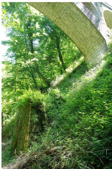
Vue d'une culée du deuxième pont (détruit), sous le pont actuel. Phot. Thierry Monnet IVR84_20187301296NUCA
