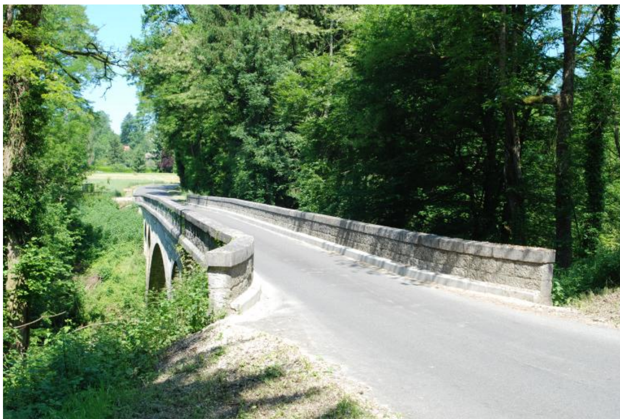
Vue du pont actuel.
