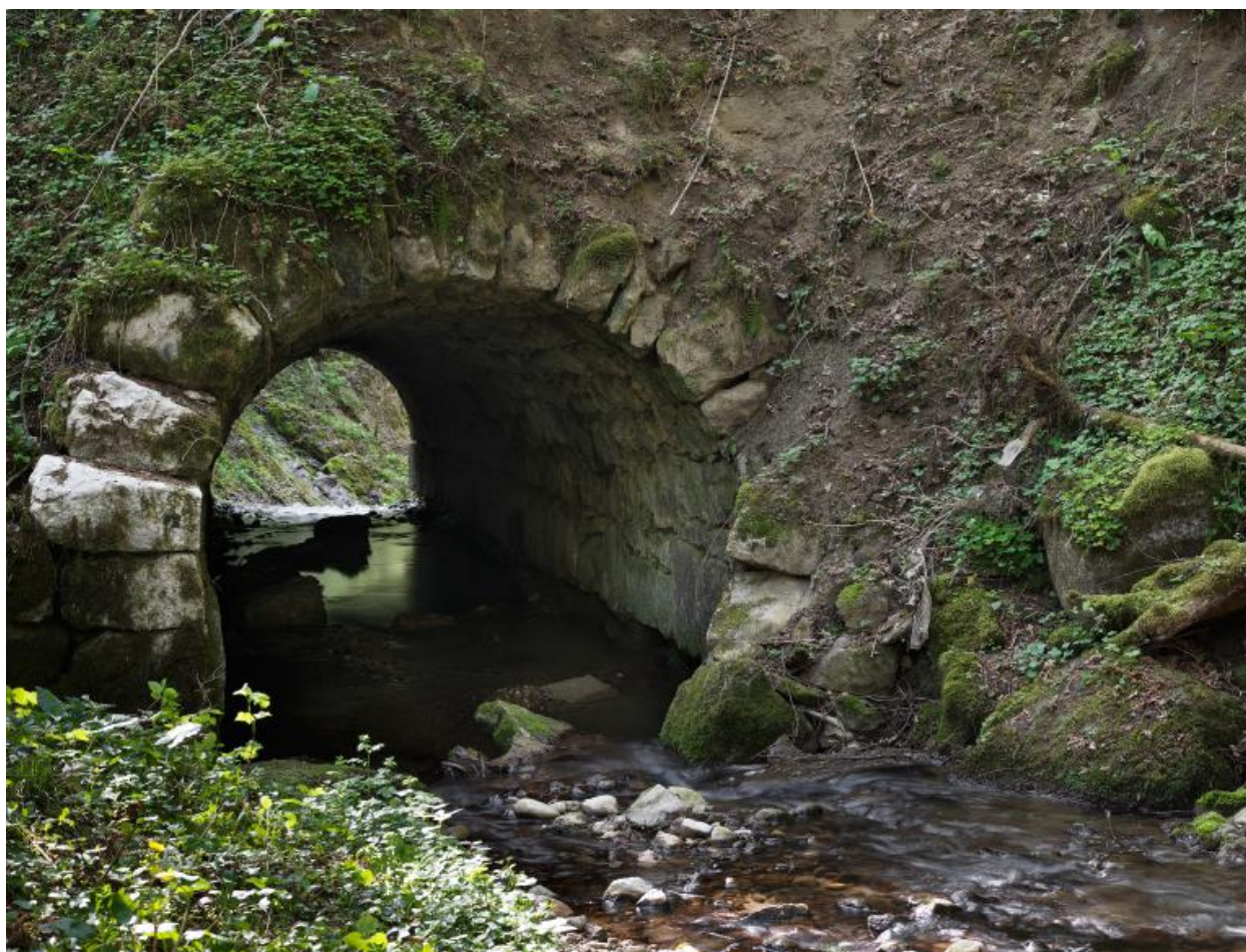
Vue rapprochée côté amont.
