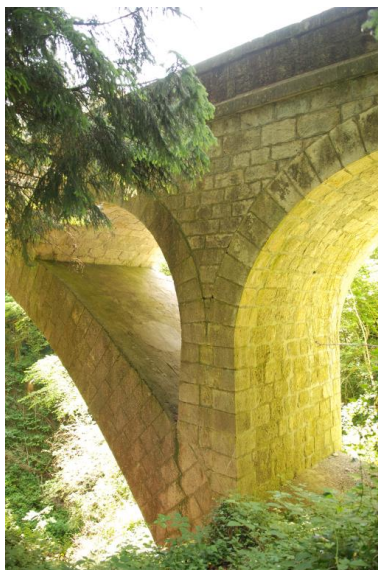
Détail de l'arche du pont actuel. Phot. Thierry Monnet IVR84_20187301294NUCA
