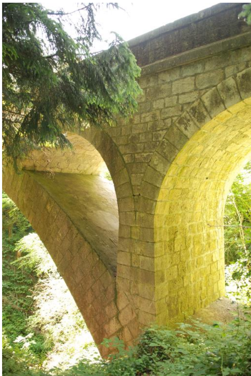
Détail de l'arche du pont actuel.
