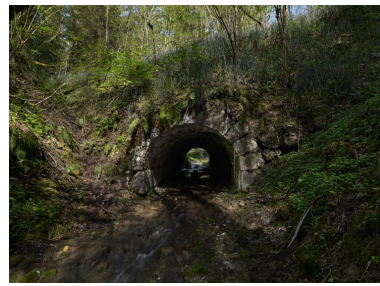
Vue aval. Phot. Thierry Leroy IVR84_20177301826NUCAQ
