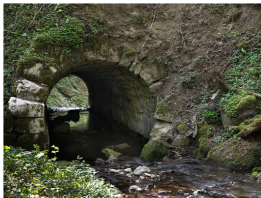
Vue rapprochée côté amont. Phot. Thierry Leroy IVR84_20177301819NUCAQ
