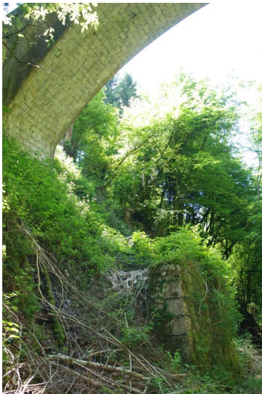
Vue d'une culée du deuxième pont (détruit), sous le pont actuel.
