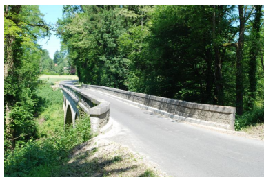
Vue du pont actuel. Phot. Thierry Monnet IVR84_20187301293NUCA
