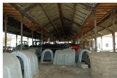
Hangar, vue intérieure Phot. Catherine Guégan IVR82_20150100110NUCA
