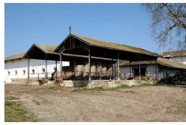
Petit hangar, depuis le sud-ouest Phot. Catherine Guégan IVR82_20150100119NUCA
