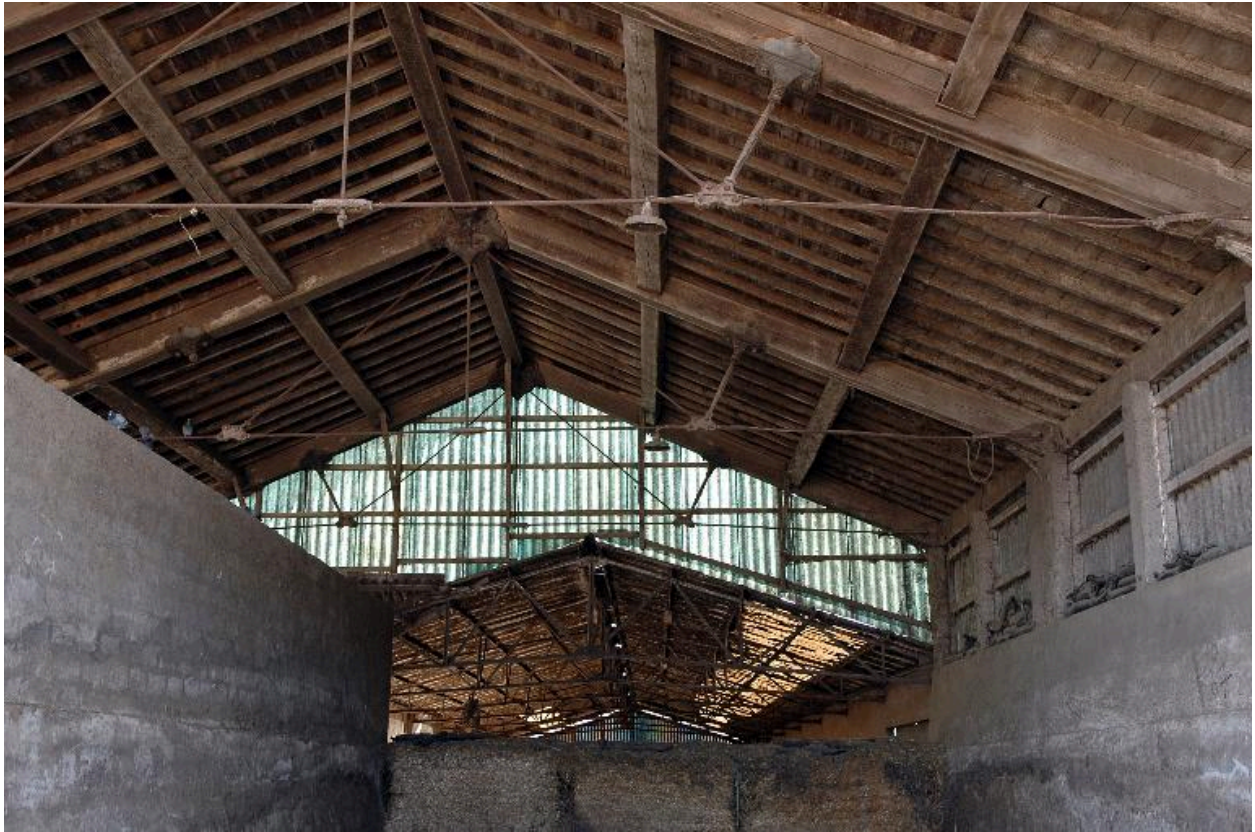
Niches à veaux et silos, détail de la charpente
