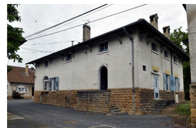
La boulangerie, élévation postérieure
