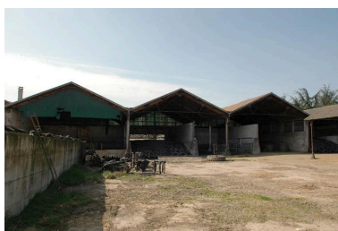
Niches à veaux et silos, depuis l'est Phot. Catherine Guégan IVR82_20150100113NUCA
