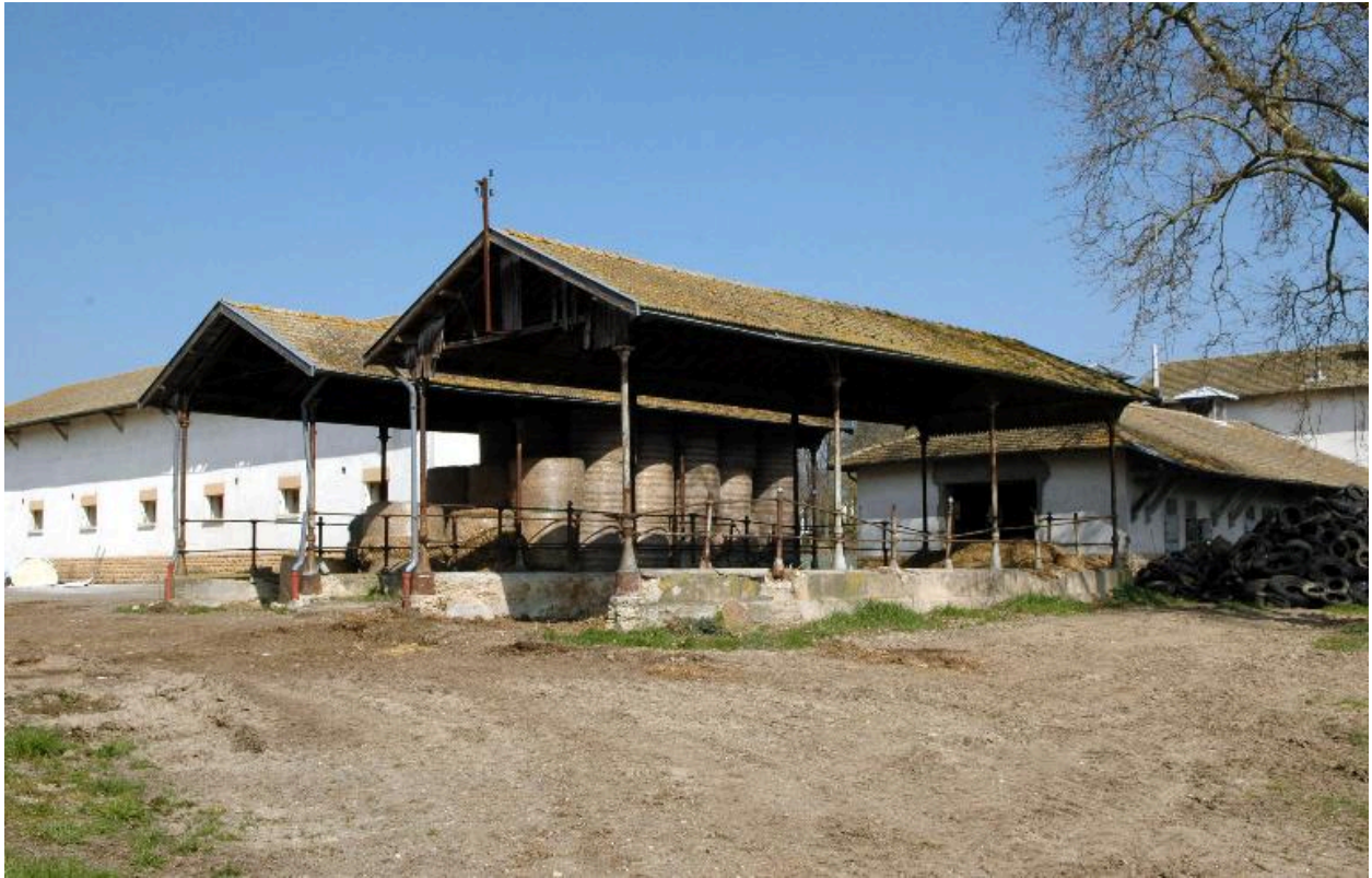
Petit hangar, depuis le sud-ouest
