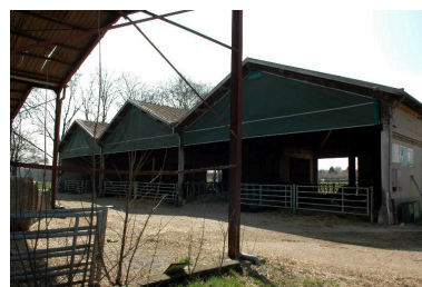
Niches à veaux et silos, depuis le nord-est Phot. Catherine Guégan IVR82_20150100115NUCA
