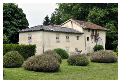
Ferme Jacon : vue d'ensemble depuis le sud-est Phot. Catherine Guégan IVR84_20160100194NUCA
