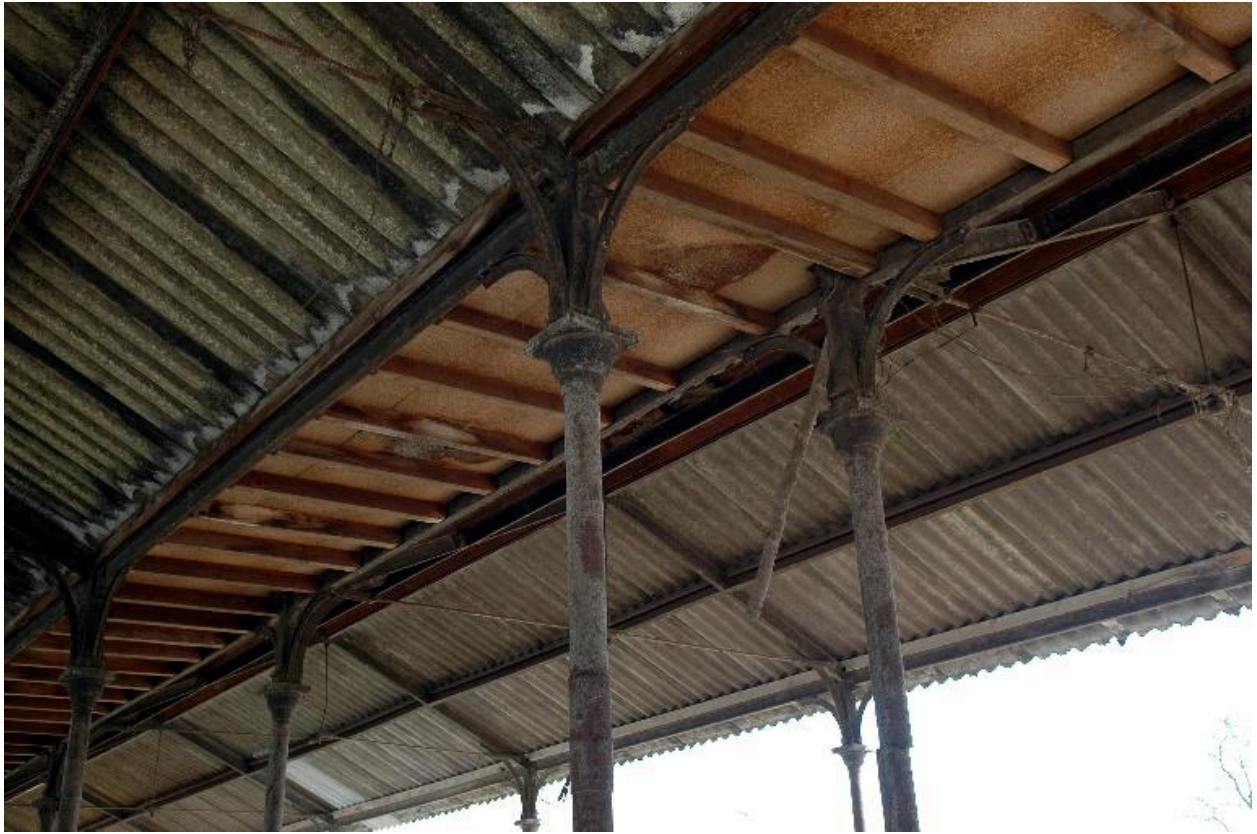
Hangar, détail de la charpente métallique
