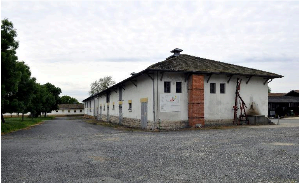
Ferme-école : moulin et étable, actuellement bâtiment des pépinières, depuis le nord
