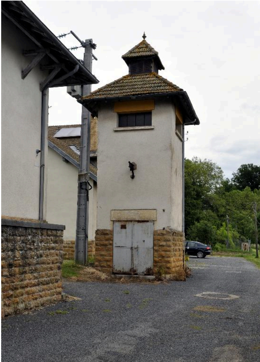
Ferme-école : poste de transformation
