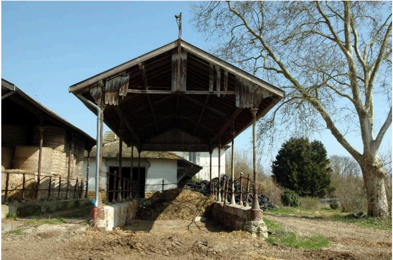
Petit hangar, depuis l'ouest
