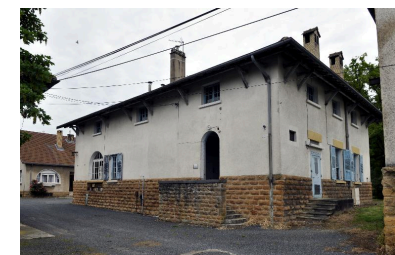
La boulangerie, élévation postérieure
