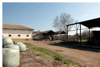
Vue de la partie sud-est des bâtiments agricoles
