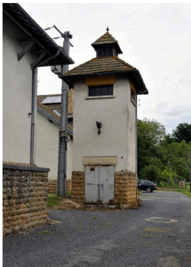
Ferme-école : poste de transformation Phot. Catherine Guégan IVR84_20160100180NUCA
