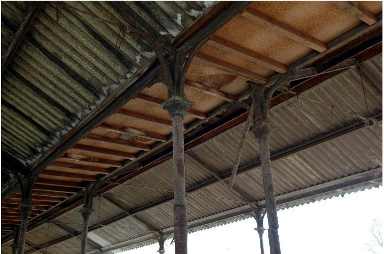
Hangar, détail de la charpente métallique
