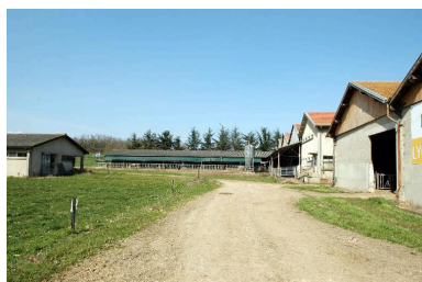
Partie ouest des bâtiments agricoles, allée, depuis le sud Phot. Catherine Guégan IVR82_20150100117NUCA
