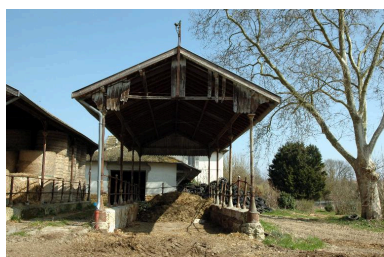
Petit hangar, depuis l'ouest Phot. Catherine Guégan IVR82_20150100120NUCA
