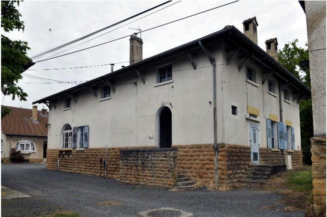
La boulangerie, élévation postérieure
