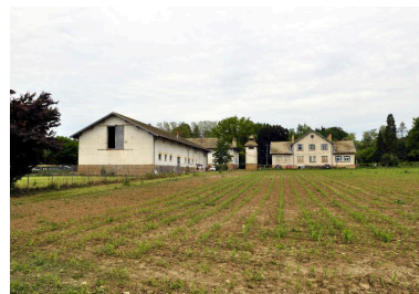
Ferme-école : ancienne écurie (à gauche de l'image) depuis le sud-est Phot. Catherine Guégan IVR84_20160100186NUCA
