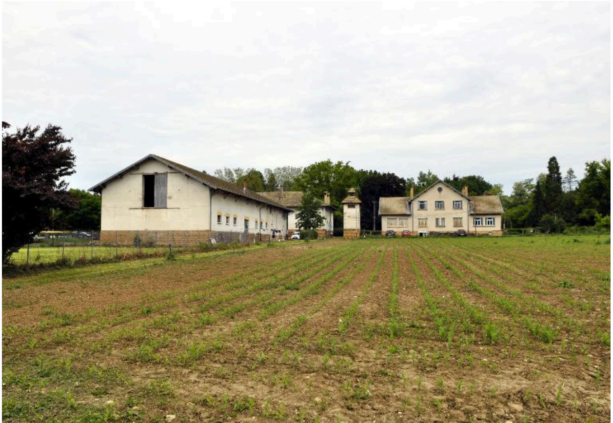
Ferme-école : ancienne écurie (à gauche de l'image) depuis le sud-est
