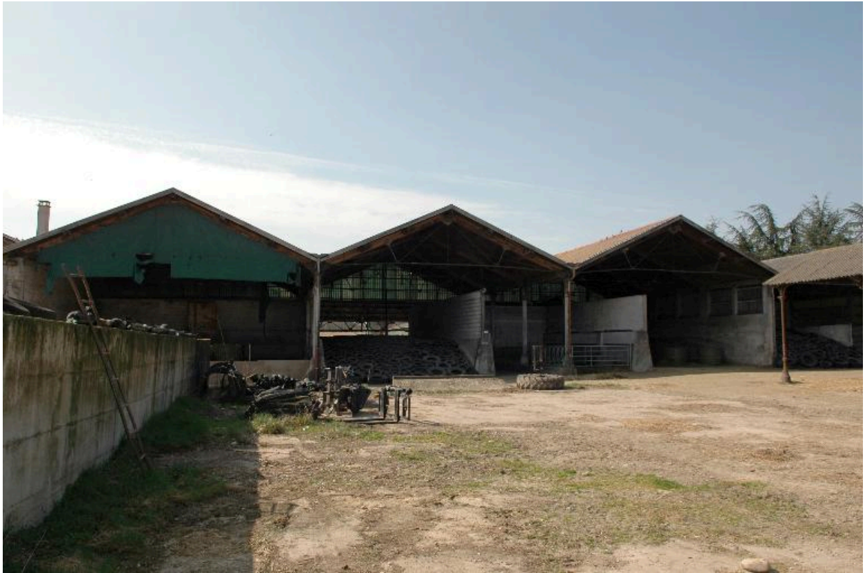
Niches à veaux et silos, depuis l'est
