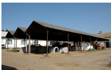
Hangar, autre vue Phot. Catherine Guégan IVR82_20150100109NUCA
