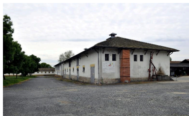
Ferme-école : moulin et étable, actuellement bâtiment des pépinières, depuis le nord Phot. Catherine Guégan IVR84_20160100181NUCA
