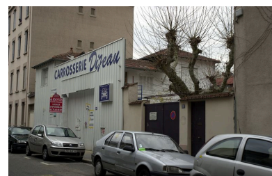
La maison de gardien (?) abritant une partie de la carrosserie Phot. Bernard Ducouret IVR82_20036903756NUCA
