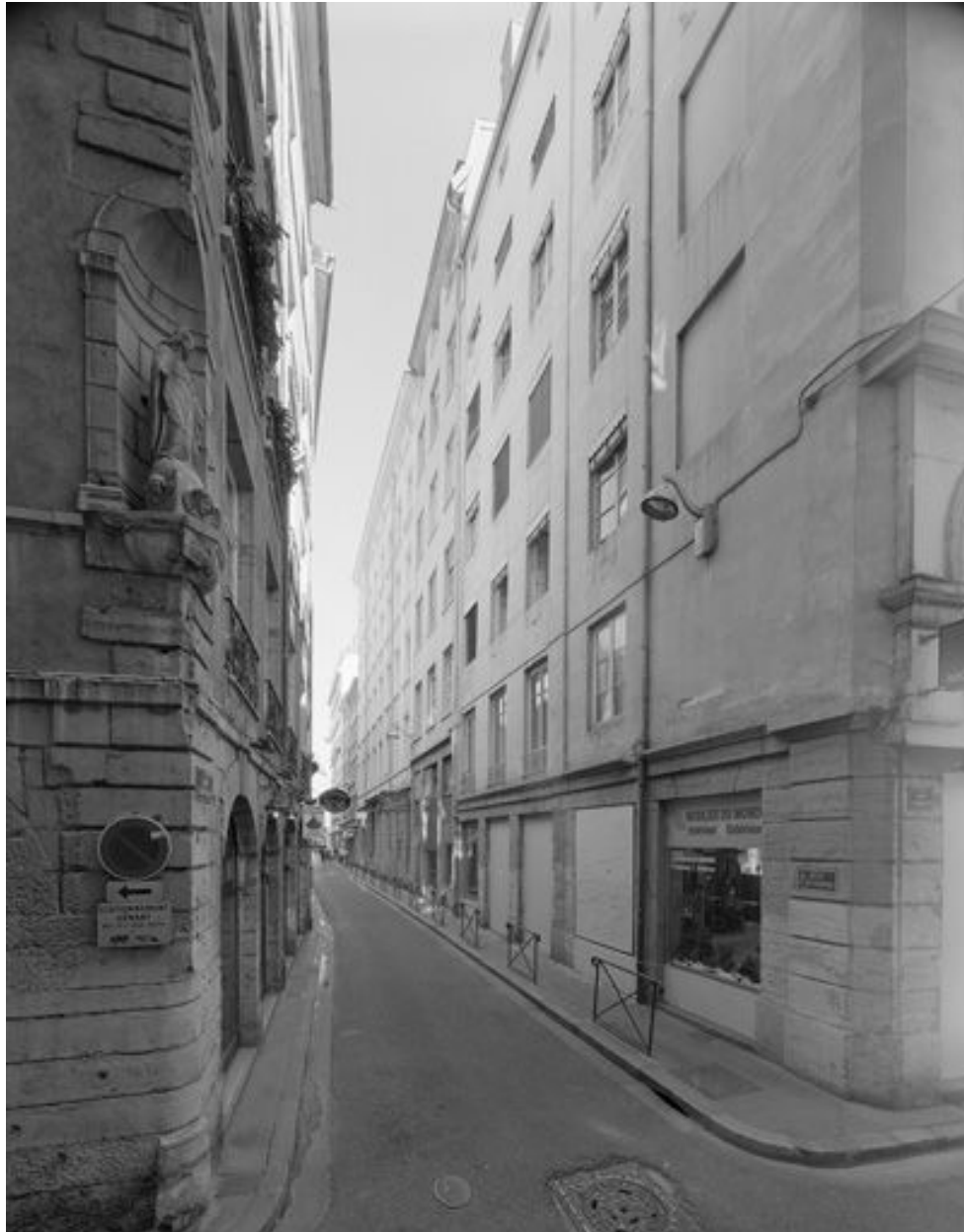
Partie sud de la rue Lanterne, vue générale du côté est prise depuis la rue Longue
