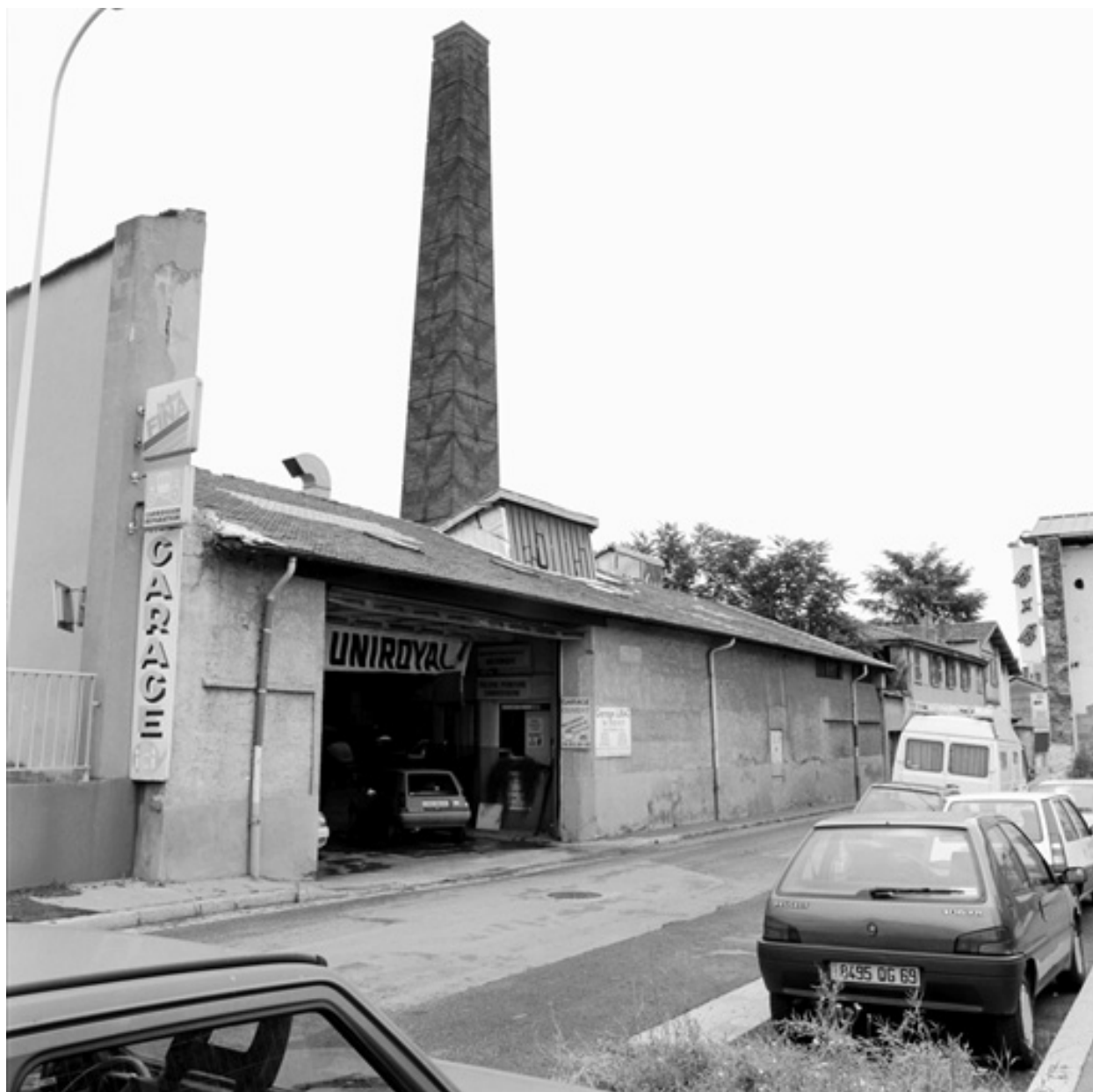
Vue générale nord de la rue du Souvenir
