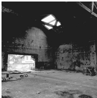
Vue intérieure Phot. Martial Couderette IVR82_20016900577X
