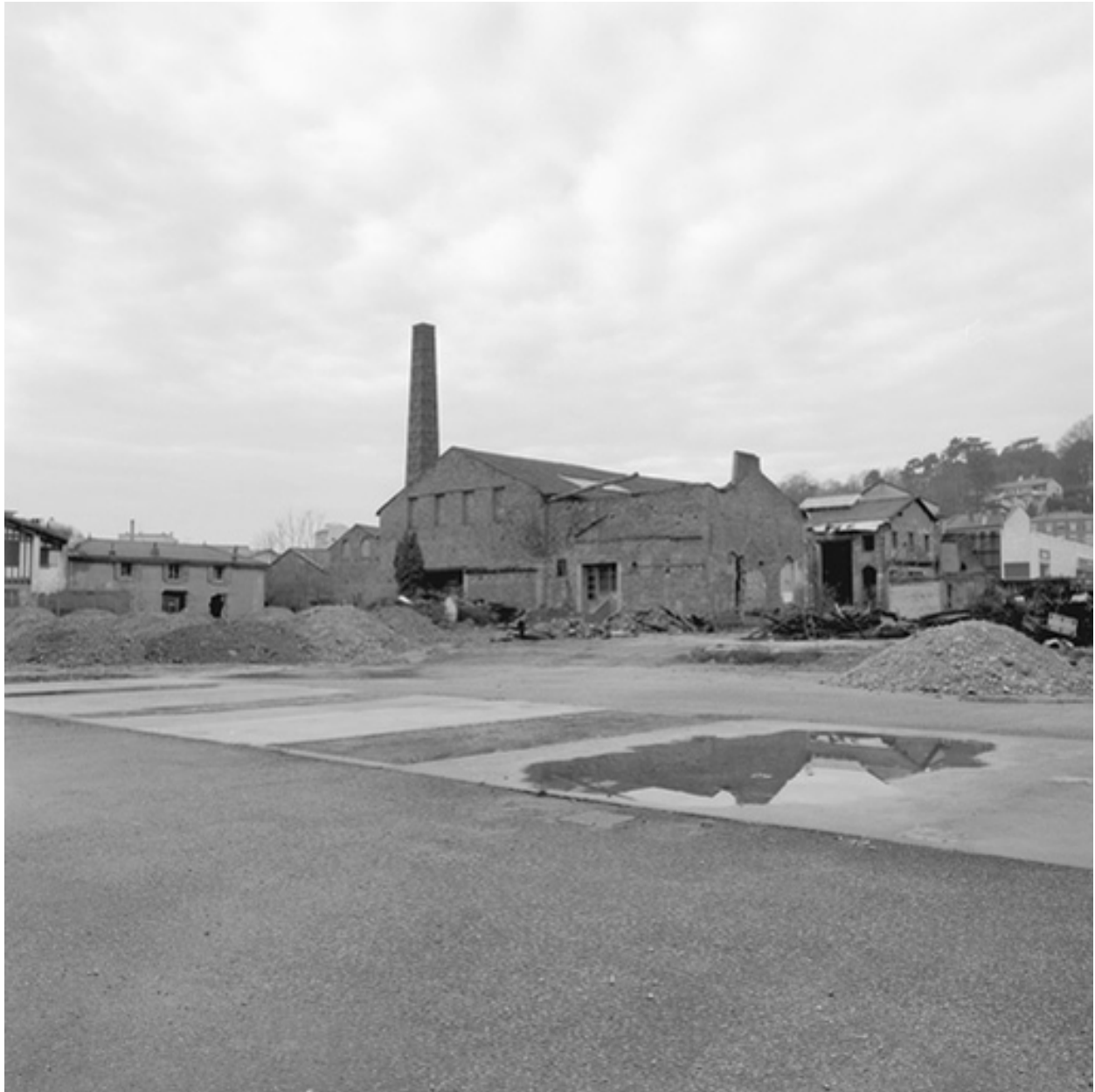
Vue générale sud-ouest, rue Marietton
