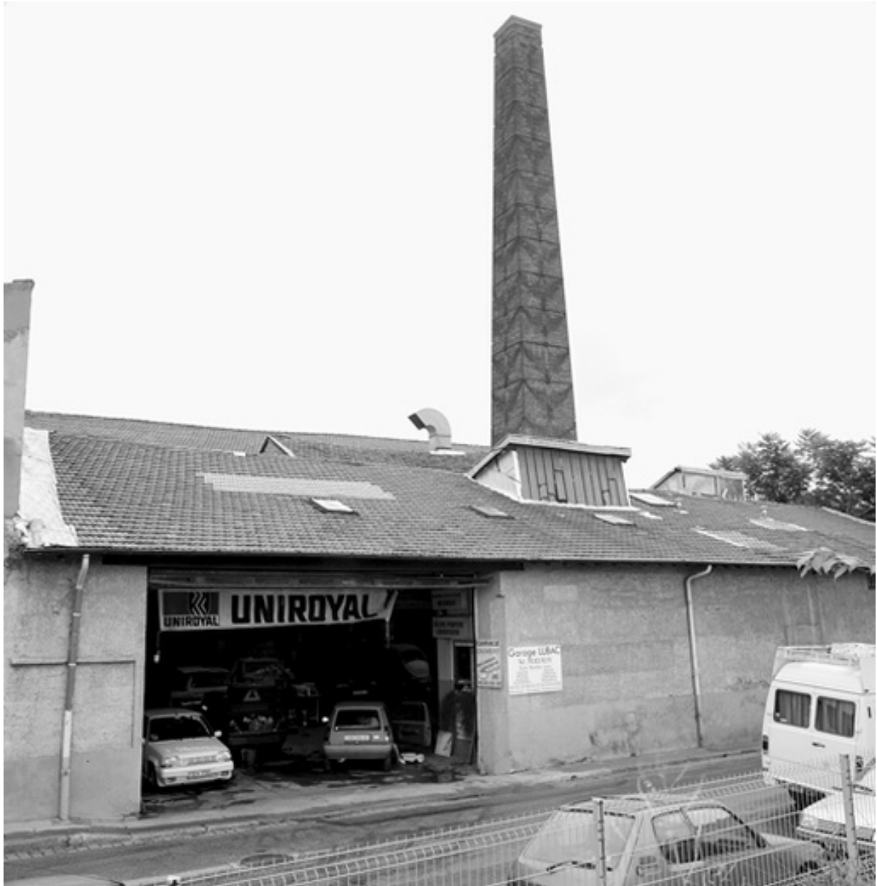
Détail garage Lubac, rue du Souvenir
