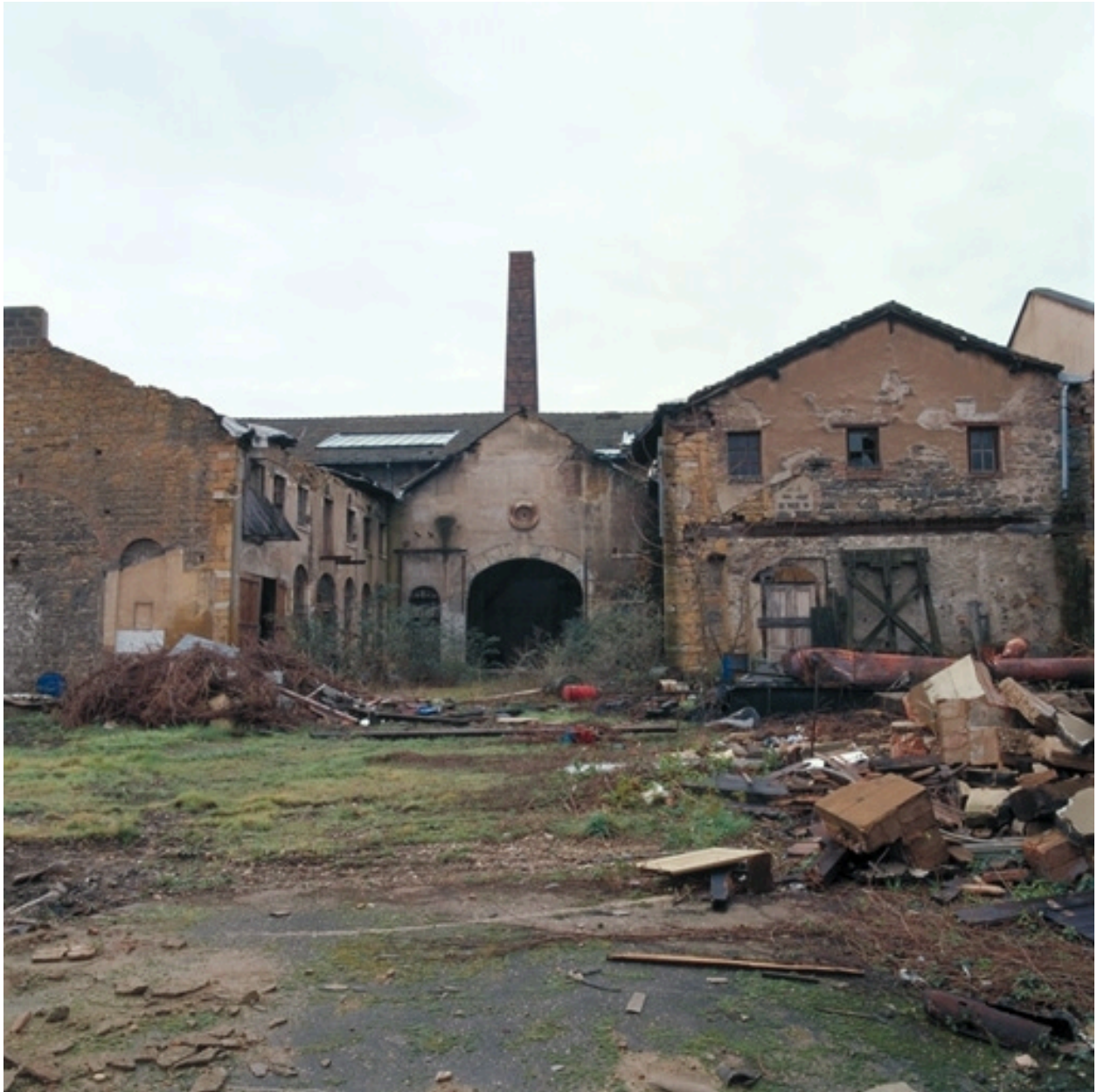
Vue générale ouest
