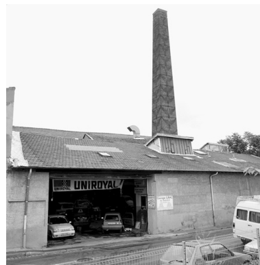
Détail garage Lubac, rue du Souvenir Phot. Martial Couderette IVR82_20016900579X
