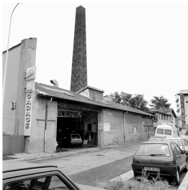
Vue générale nord de la rue du Souvenir Phot. Martial Couderette IVR82_20016900578X
