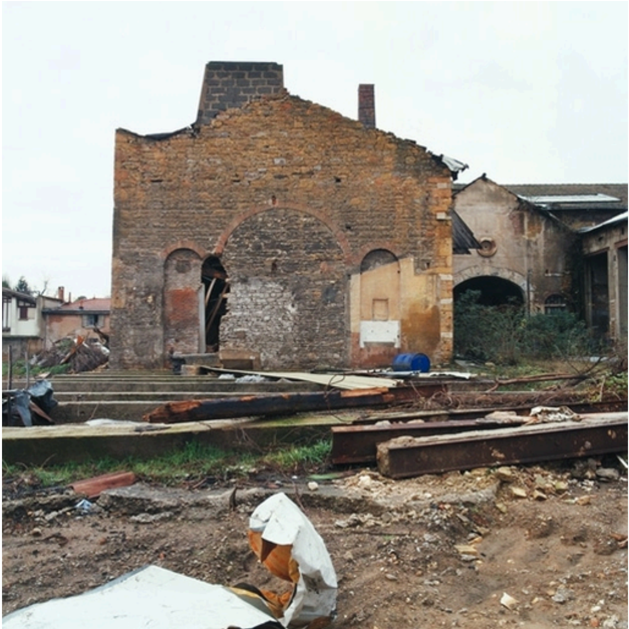
Vue ouest angle rue du souvenir
