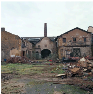
Vue générale ouest Phot. Martial Couderette IVR82_20016900571XA
