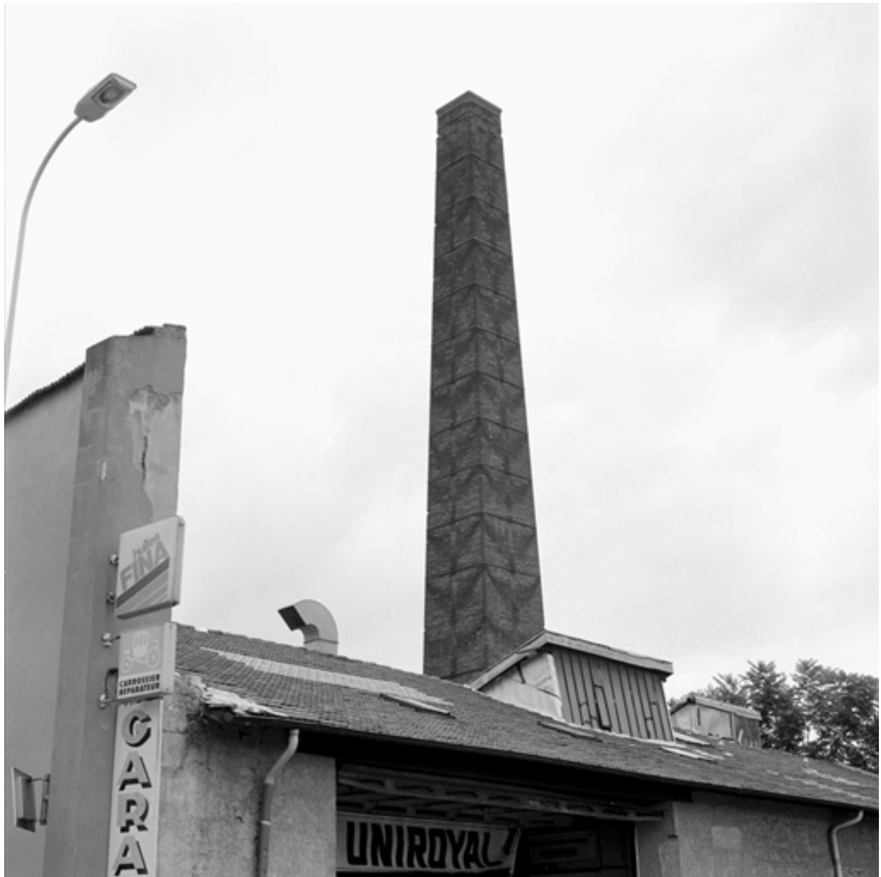
Détail cheminée quadrangulaire
