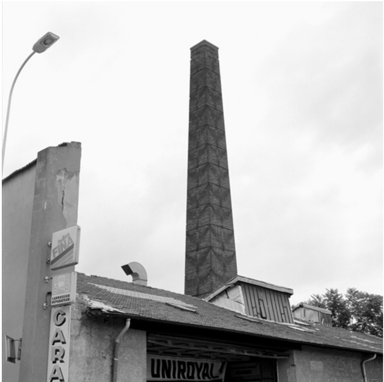
Détail cheminée quadrangulaire
