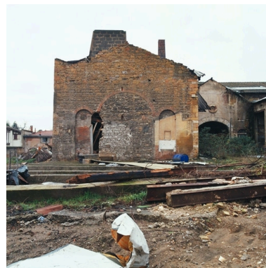
Vue ouest angle rue du souvenir Phot. Martial Couderette IVR82_20016900573XA
