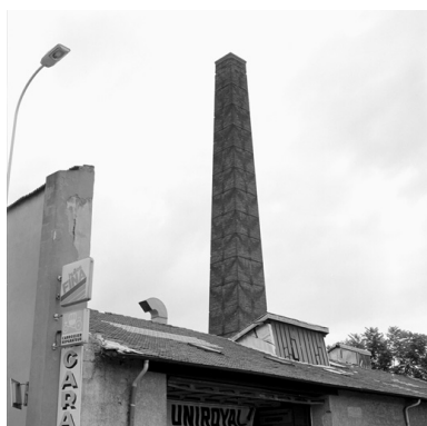
Détail cheminée quadrangulaire Phot. Martial Couderette IVR82_20016900580X
