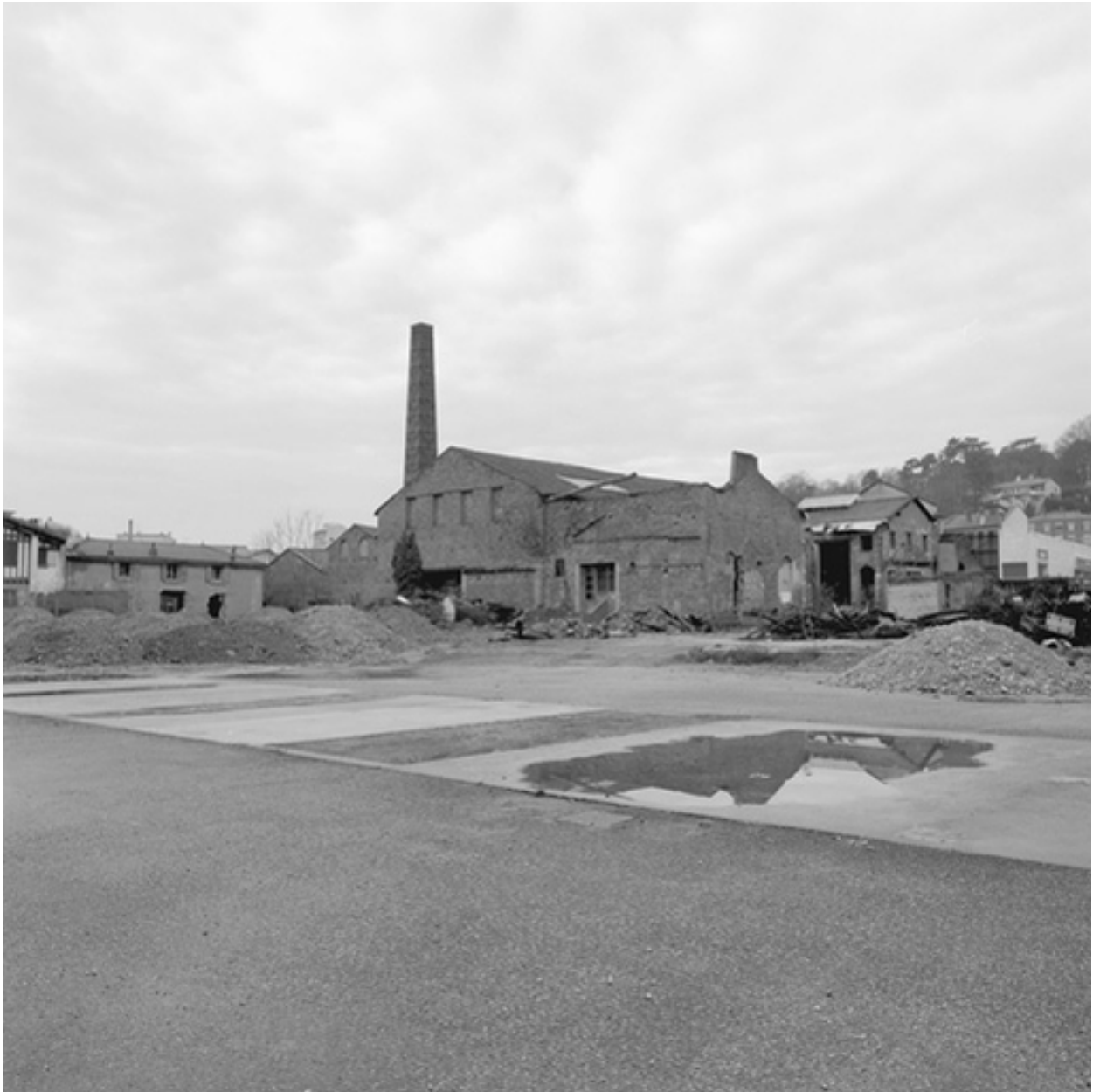
Vue générale sud-ouest, rue Marietton
