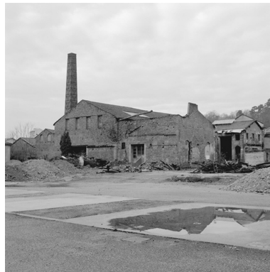
vue d'ensemble Phot. Martial Couderette IVR82_20016900567X
