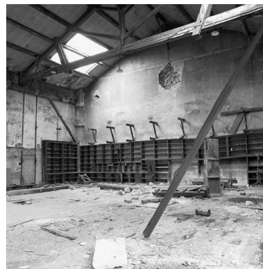
Intérieur du bâtiment principal Phot. Martial Couderette IVR82_20016900576X
