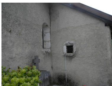
Vue extérieure de la chapelle latérale percée d'une fenêtre à accolade. Phot. Jérôme Daviet IVR82_20127400590NUCA
