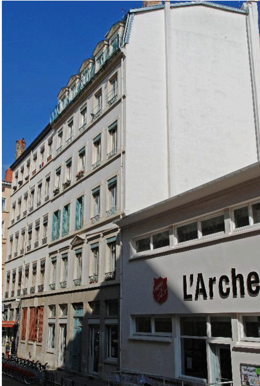
Vue générale, depuis le sud-est : élévation sur rue et mur pignon
