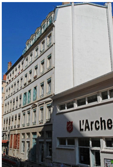
Vue générale, depuis le sud-est : élévation sur rue et mur pignon Phot. Catherine Guégan IVR84_20166900590NUCA
