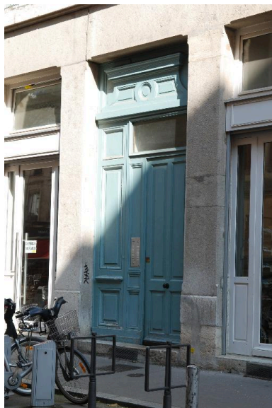
Vue rapprochée de la porte d'entrée Phot. Catherine Guégan IVR84_20166900592NUCA
