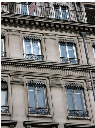
Détail des fenêtres des deux derniers étages Phot. Maryannick Chalabi IVR82_20046904674NUCA
