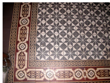
Carrelage en ciment moulé du vestibule Phot. Maryannick Chalabi IVR82_20046904073NUCA
