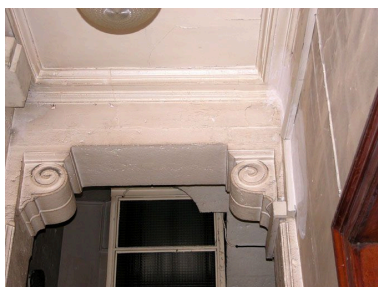
Détail de l'étrésillonement supportant le plafond du vestibule Phot. Maryannick Chalabi IVR82_20046904072NUCA
