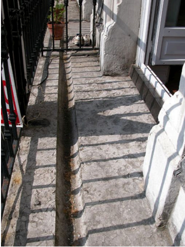
Détail de la rigole du balcon filant devant l'étage de comble Phot. Maryannick Chalabi IVR82_20046904676NUCA
