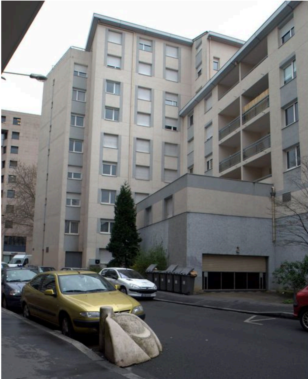
Elévation postérieure, vue partielle
