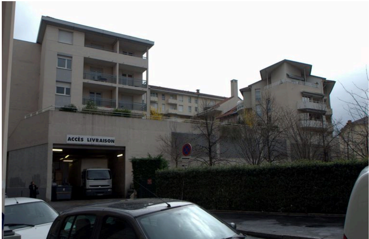
Élévation postérieure et garage, depuis le sud-ouest
