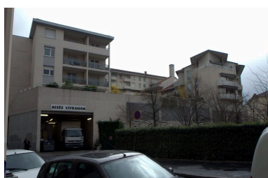
Elévation postérieure et garage, depuis le sud-ouest Phot. Maryannick Chalabi IVR82_20116901721NUCA
