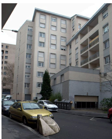
Elévation postérieure, vue partielle Phot. Maryannick Chalabi IVR82_20116901722NUCA
