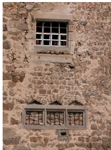
Détail des baies anciennes du mur pignon. Phot. Thierry Monnet IVR82_20114201137NUCA
