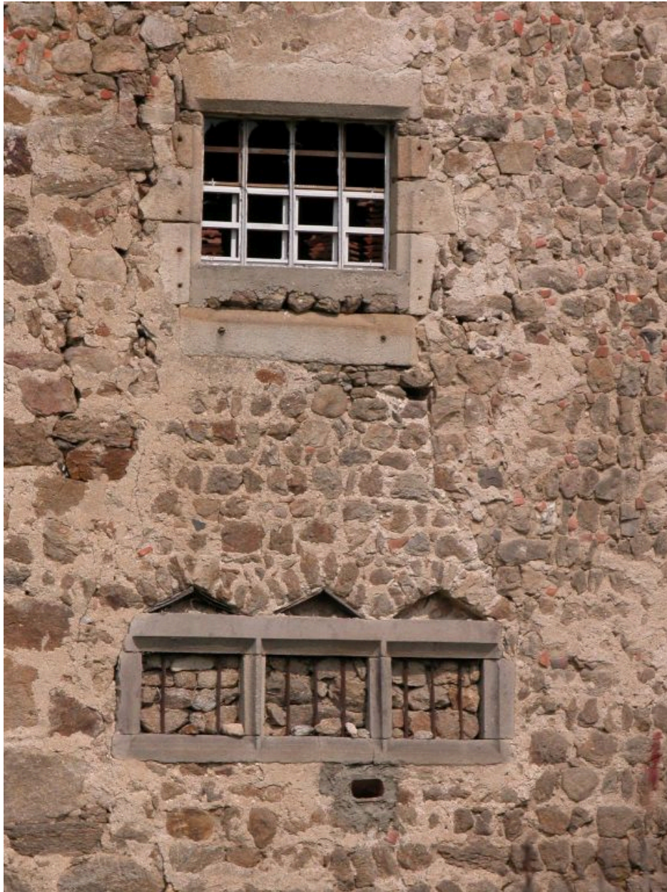
Détail des baies anciennes du mur pignon.
