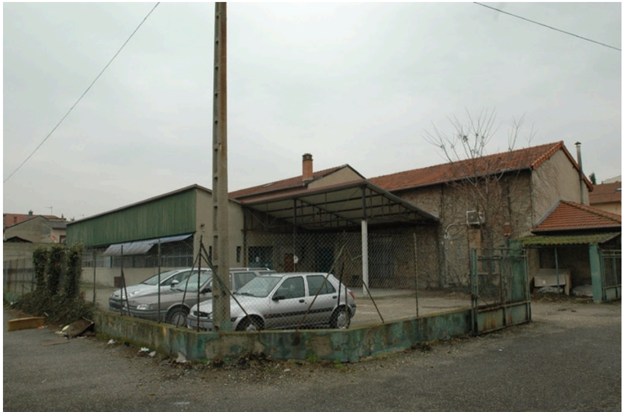
Vue sur la cour, angle sud ouest.
