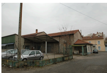
Vue sur cour, détail des entrepôt et hangars. Phot. Nadine Halitim-Dubois IVR82_20096901684NUCA
