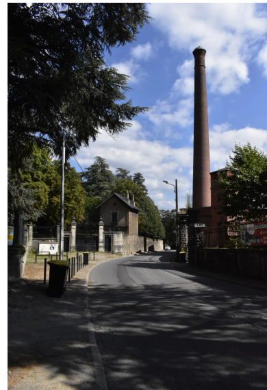
Depuis la rue François-Gillet, à gauche porte cochère (sans couverture, avec fermeture en métal) à laquelle sont adossées deux portes piétonnes. Elles donnent accès au parc du "château Prodon" (ou "Les petites bruyères"). À droite, cheminée de la teinturerie Gillet (inscrite à l'Inventaire supplémentaire des MH). Phot. Bénédicte Renaud-Morand IVR84_20224200025NUCA
