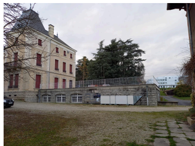
Sur le bord droit du cliché : la remise (en partie démolie), puis la cuisine adjointe à la demeure devenue principalement un restaurant d'application, puis à l'arrière-plan, les bâtiments neufs, construits comme un CET en 1975, devenu lycée professionnel hôtelier, et restructuré et agrandi en 2016-2019. Phot. Bénédicte Renaud-Morand IVR84_20224200075NUCA
