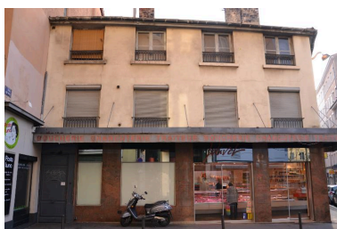
Vue d'ensemble façade ouest Phot. Noémie Caillat IVR82_20156900109NUCA
