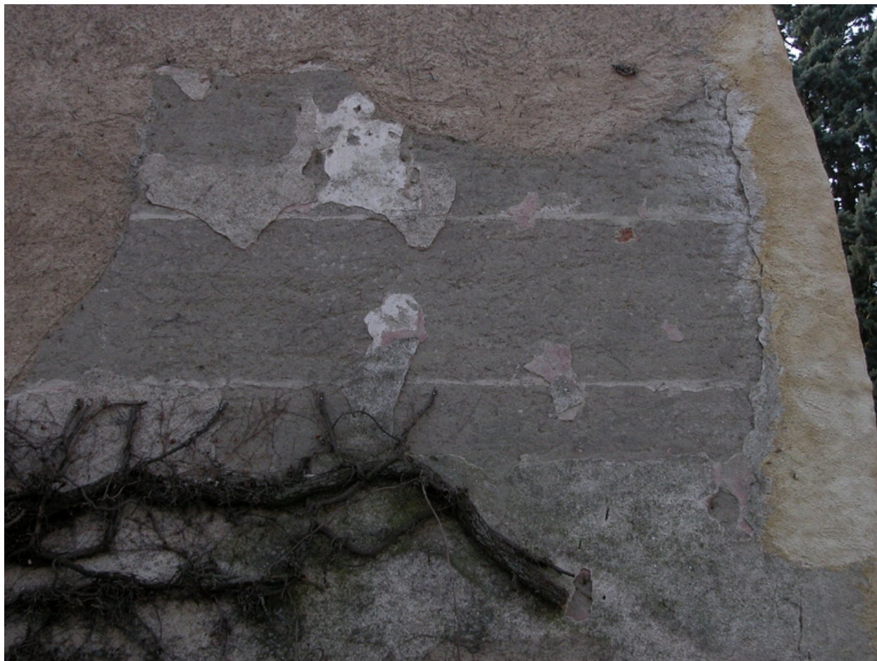
Détail de matériaux de la façade nord de l'aile sud du château : pisé, vestiges d'enduit peint.
