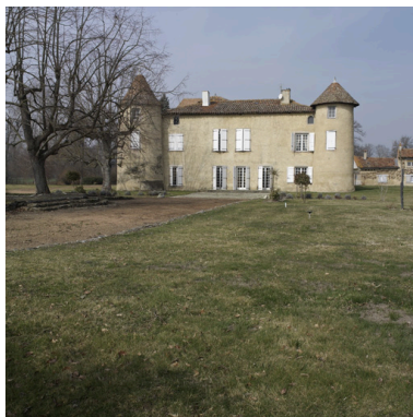
Vue générale du château depuis l'est. Phot. Eric Dessert IVR82_20064200440NUCA
