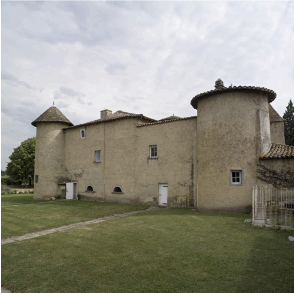
Vue générale du château depuis le nord.
