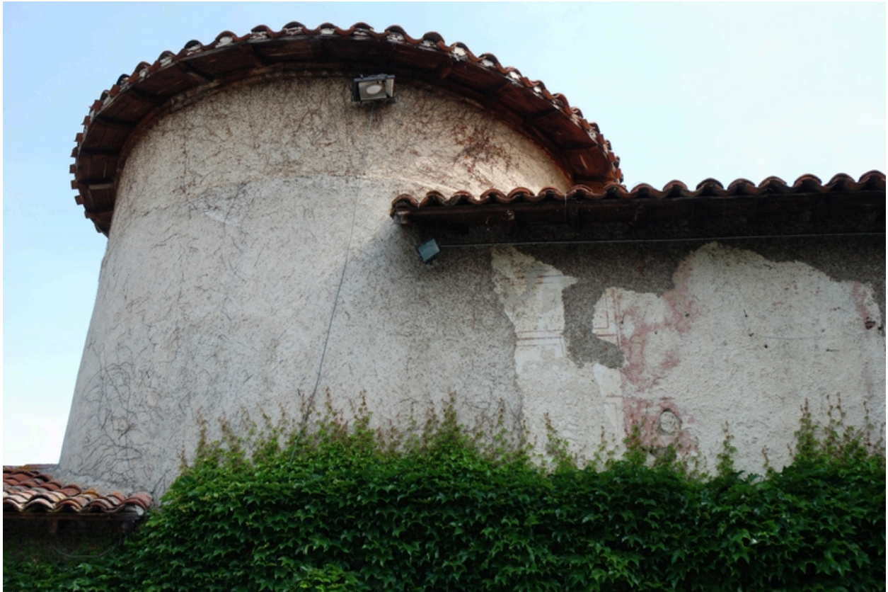
Détail de matériaux de la façade sud de l'aile nord du château : vestiges d'enduit peint.
