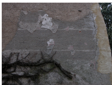
Détail de matériaux de la façade nord de l'aile sud du château : pisé, vestiges d'enduit peint. Phot. Caroline Guibaud IVR82_20134204439NUCA
