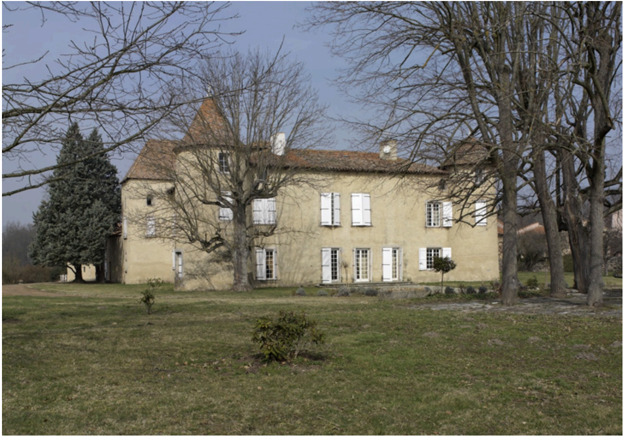
Vue générale du château depuis le sud-est.
