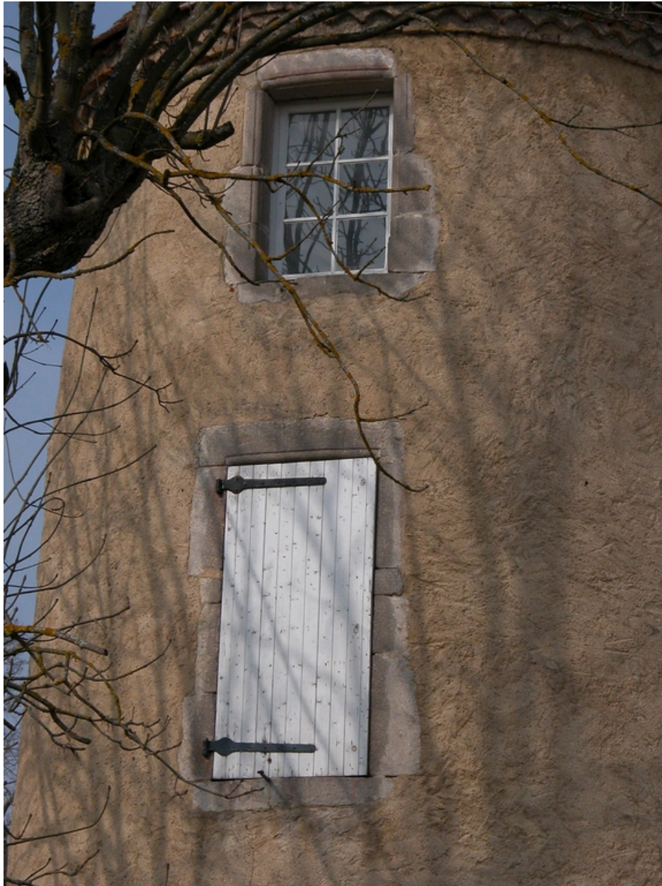
Détail de fenêtres (en place) de la tour de l'angle sud-est.
