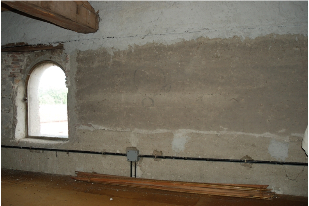
Vue intérieure du comble.
