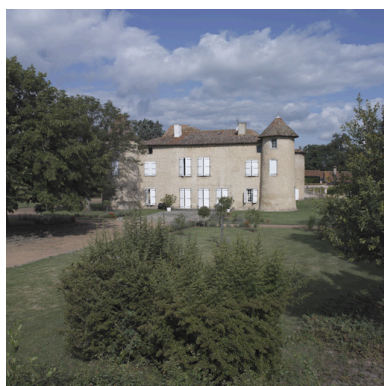
Vue générale du château depuis l'est. Phot. Eric Dessert IVR82_20054200853NUCA
