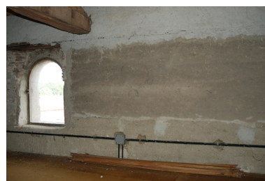
Vue intérieure du comble. Phot. Thierry Monnet IVR82_20134204416NUCA
