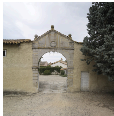
Vue du portail sud de la cour du château. Phot. Eric Dessert IVR82_20054200823NUCA
