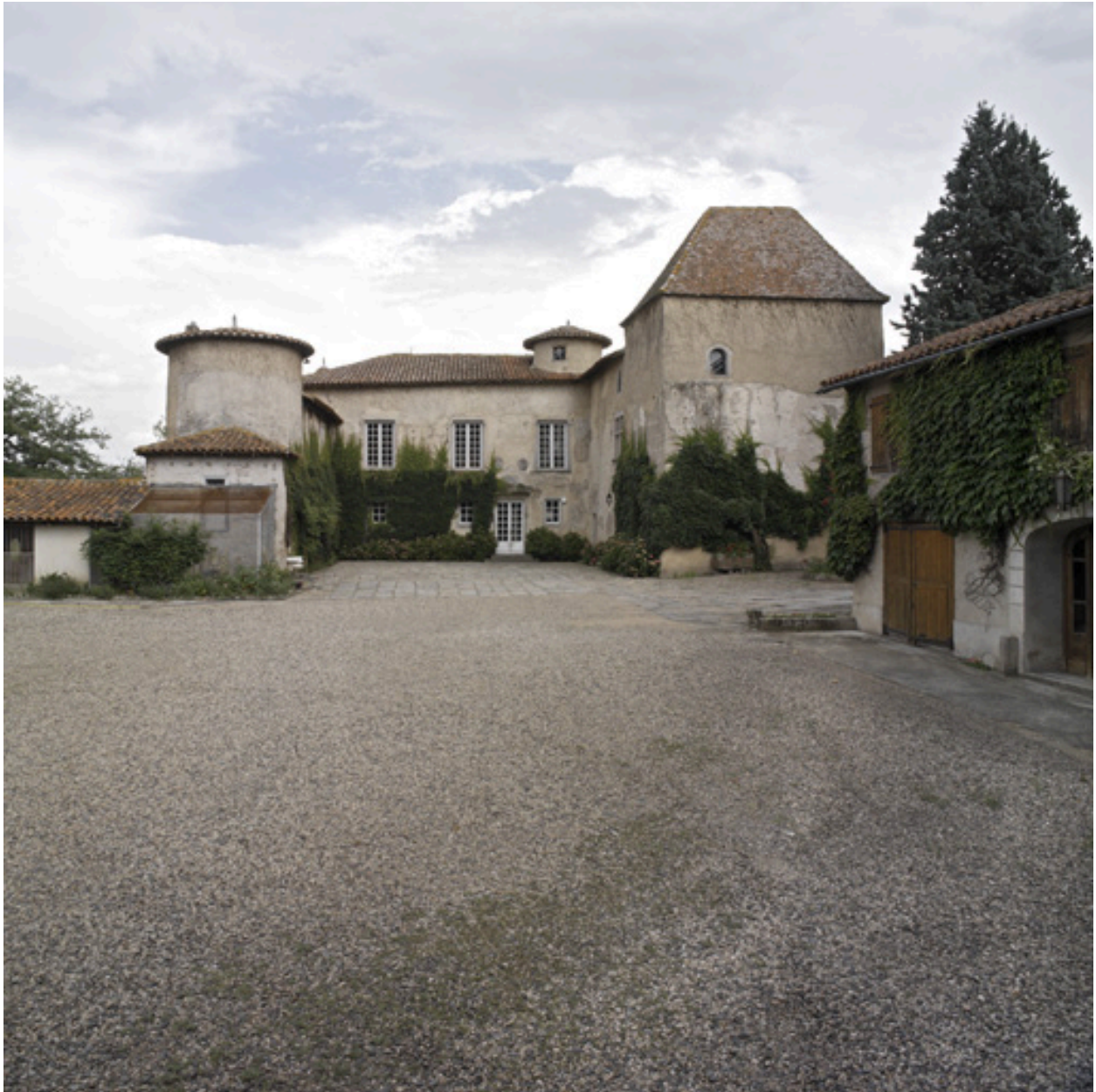
Vue d'ensemble de la cour du château, depuis l'ouest.
