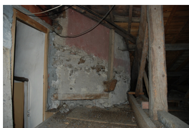
Vue intérieure du comble : charpente. Phot. Thierry Monnet IVR82_20134204417NUCA
