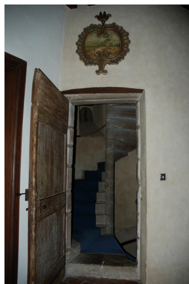
Vue intérieure de l'escalier en vis, au 1er étage. Phot. Thierry Monnet IVR82_20134204415NUCA
