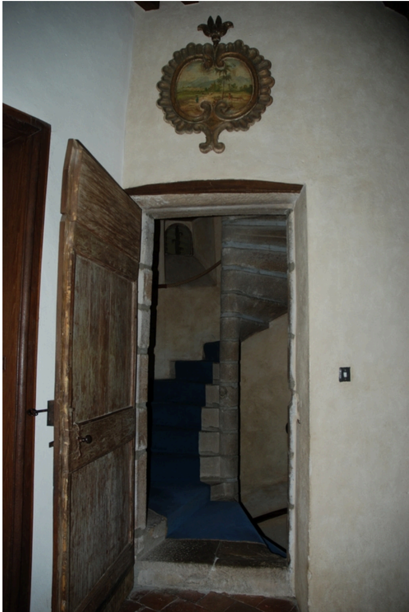
Vue intérieure de l'escalier en vis, au 1er étage.
