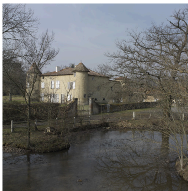
Vue générale depuis le nord-ouest. Phot. Eric Dessert IVR82_20064200427NUCA
