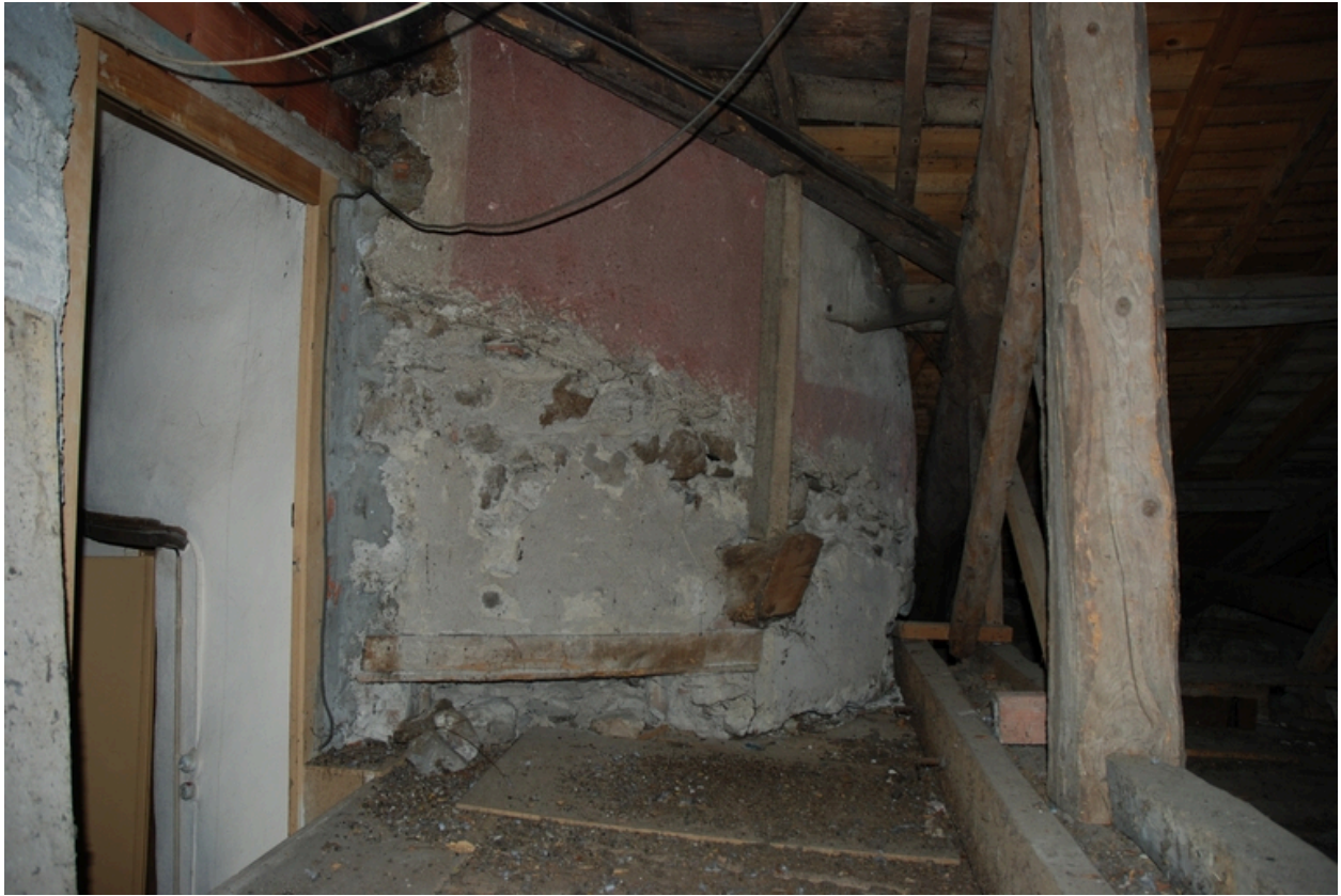
Vue intérieure du comble : charpente.
