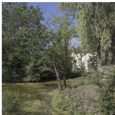
Vue générale depuis le nord-est. Phot. Eric Dessert IVR82_20054200856NUCA
