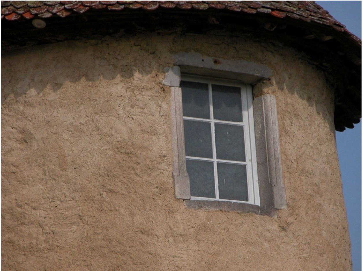
Détail de fenêtre (remontée) de la tour de l'angle nord-est.
