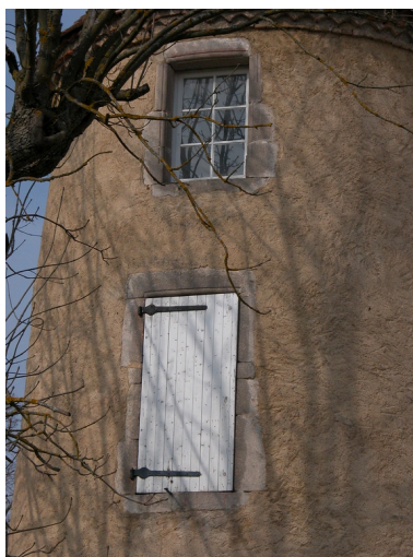
Détail de fenêtres (en place) de la tour de l'angle sud-est. Phot. Caroline Guibaud IVR82_20134204438NUCA
