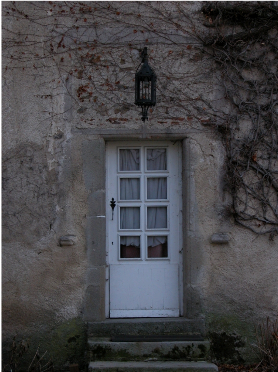
Vue de la porte de l'aile sud, depuis la cour.
