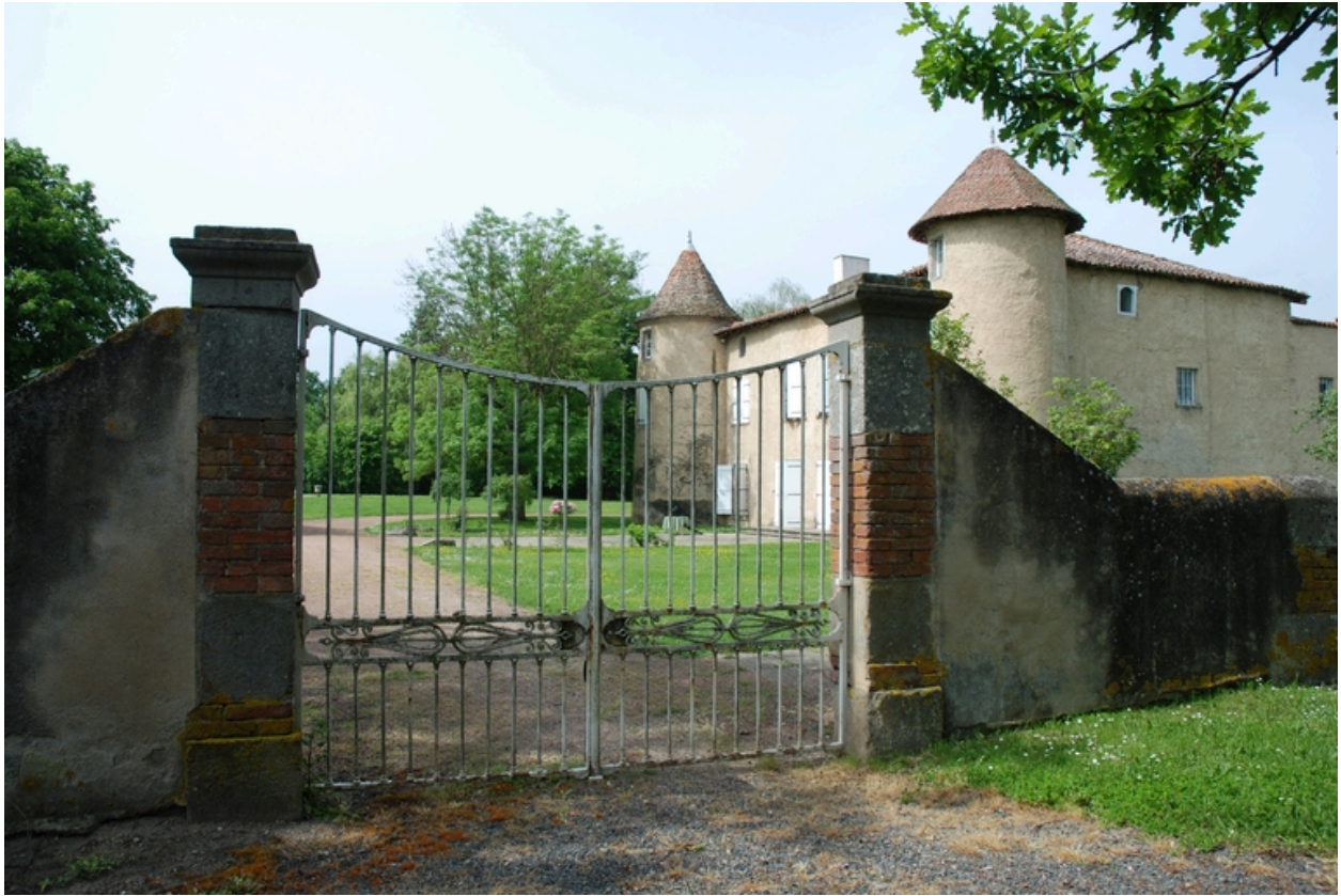
Vue du portail situé entre la partie agricole et le parc du château.
