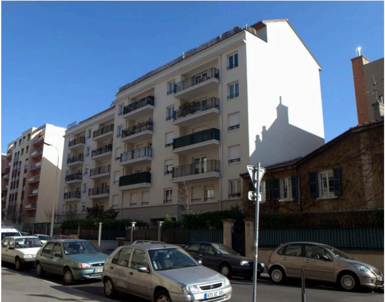
Vue générale depuis le sud-ouest
