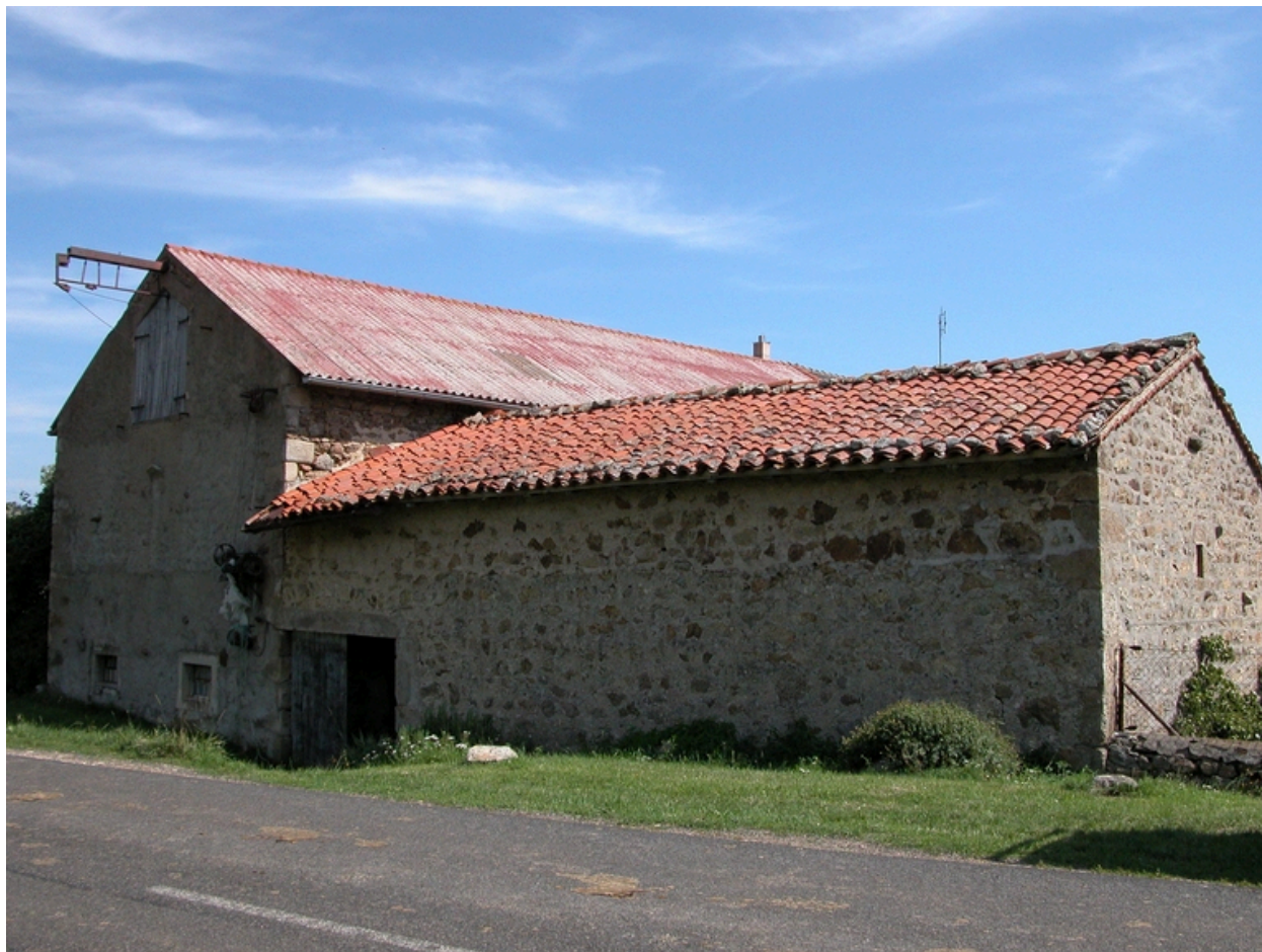
Vue d'ensemble depuis le sud : cuvage et passage couvert, pignon de la grange-étable.
