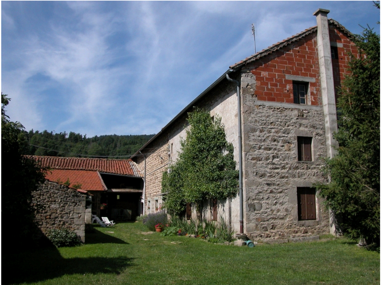
Vue d'ensemble de la cour depuis le nord-est.
