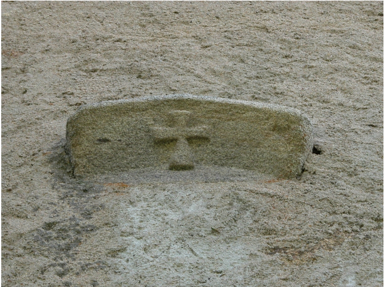
Détail du fragment de corniche en granite en remploi dans le pignon de la grange-étable.
