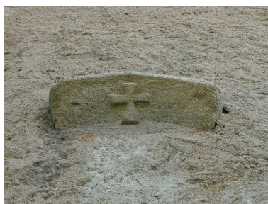
Détail du fragment de corniche en granite en remploi dans le pignon de la grange-étable. Phot. Caroline Guibaud IVR82_20124201092NUCA
