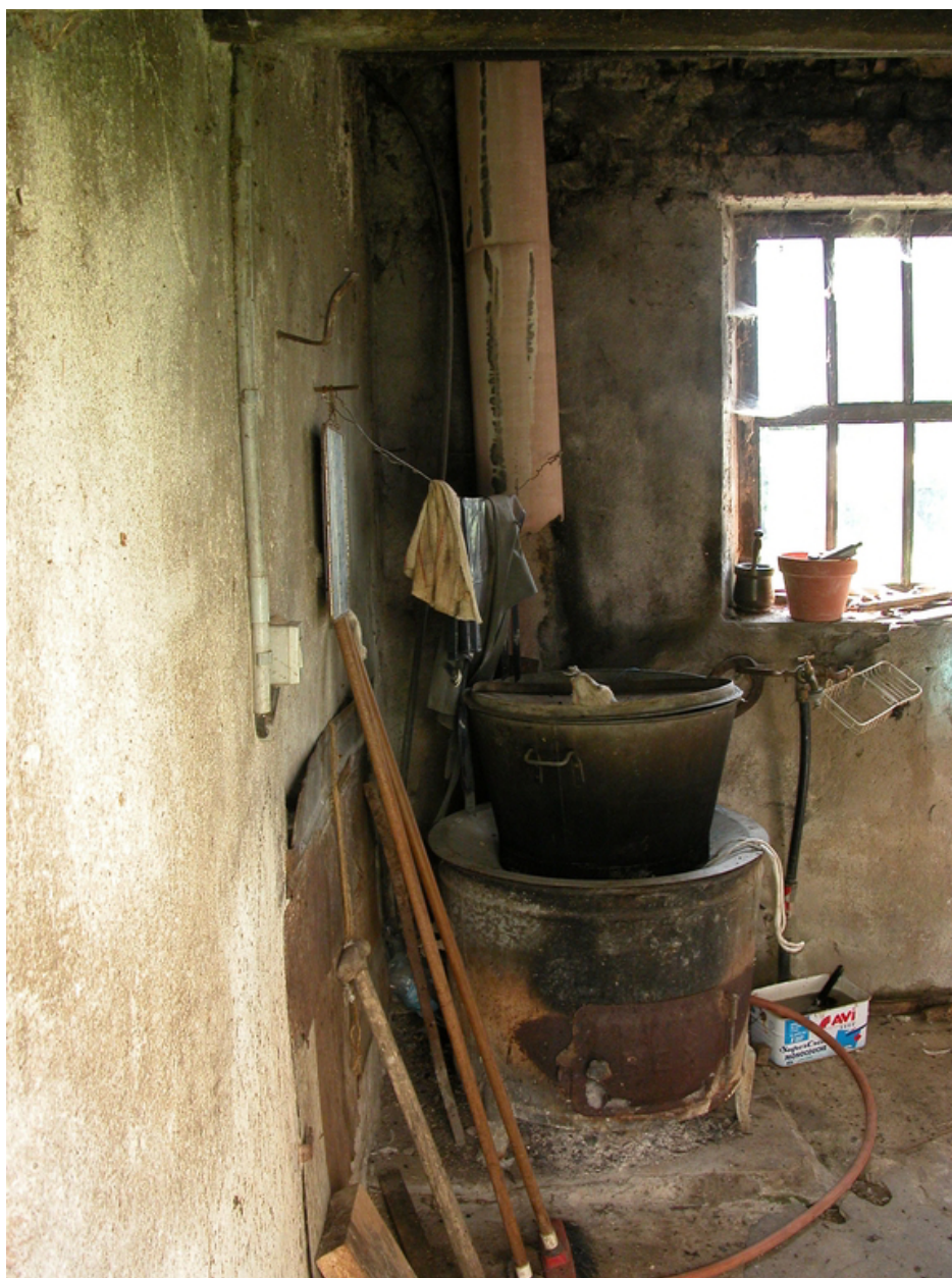
Vue intérieure de la chaudière.
