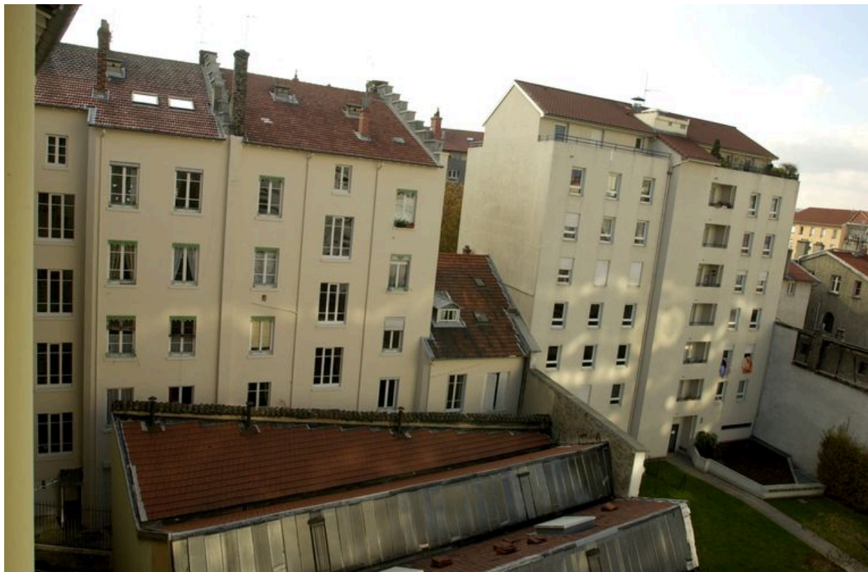
Élévation postérieure depuis le nord-est
