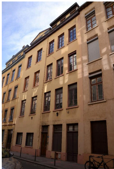
Vue d'ensemble façade nord Phot. Noémie Caillat IVR82_20156900252NUCA
