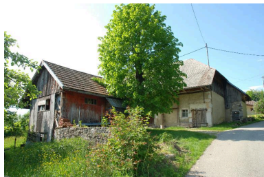
Vue générale depuis le sud-est. Au premier plan, remise en charpente. Phot. Caroline Guibaud IVR82_20147302419NUCA
